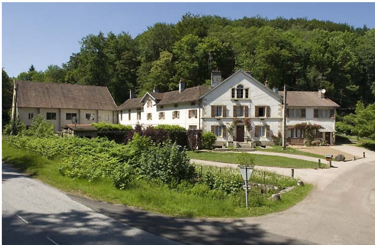
Ecole et logement (commune du Clerjus, 88). 70, Aillevillers-et-Lyaumont, lieudit : la Chaudeau
