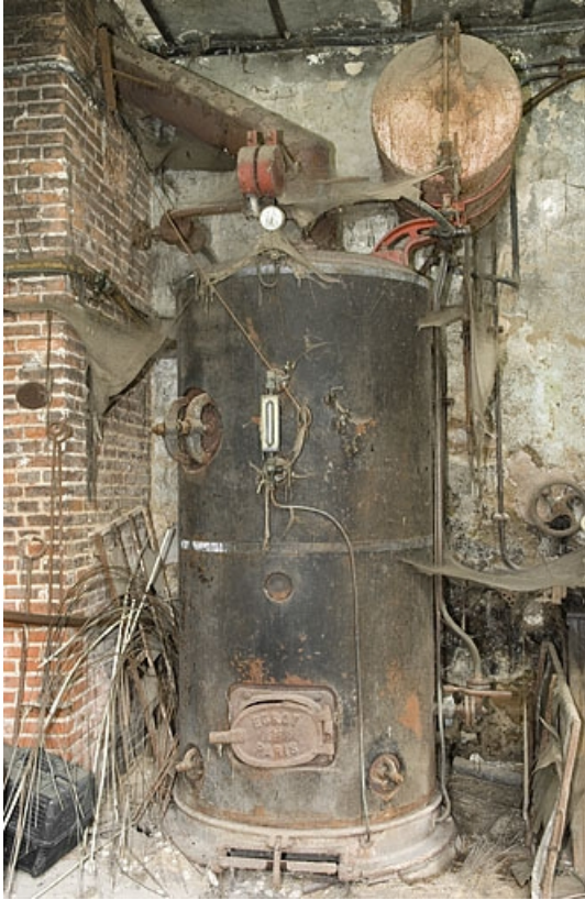
Atelier de distillation. Chaudière Egrot.
