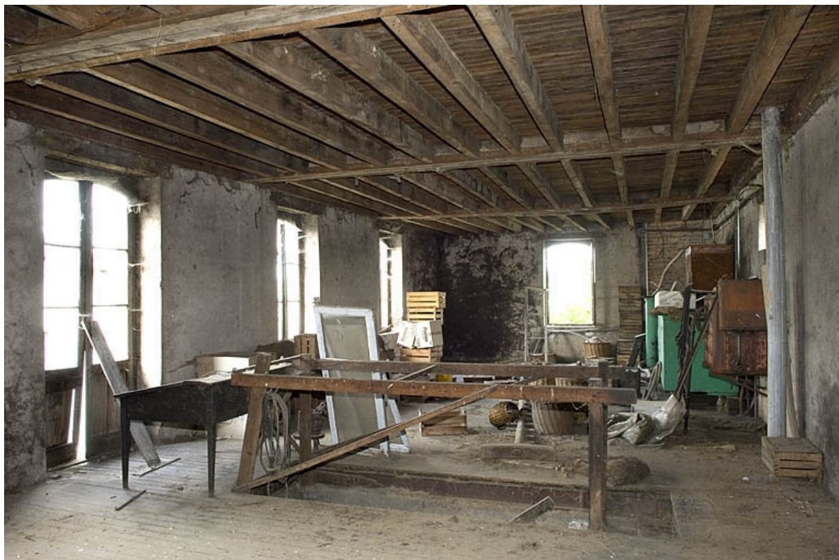
Atelier de distillation (1er étage). Vue d'ensemble du chai.
