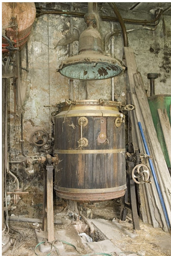
Atelier de distillation. Alambic Deroy Fils Aîné (mur nord).
