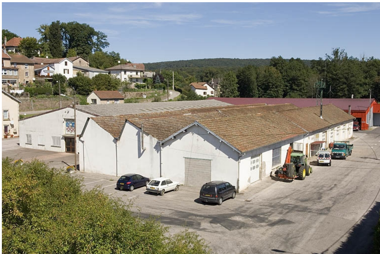
Vue depuis le sud-ouest.
