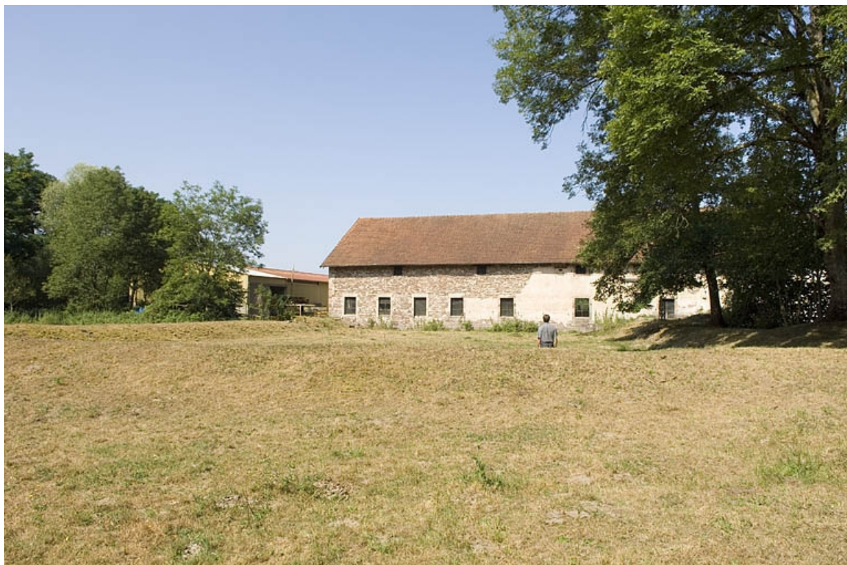
Façade postérieure de la salle des tables et du séchoir. Au premier plan : fosse à pulpe. 70, Corbenay rue de la Féculerie, lieudit : les Naues
