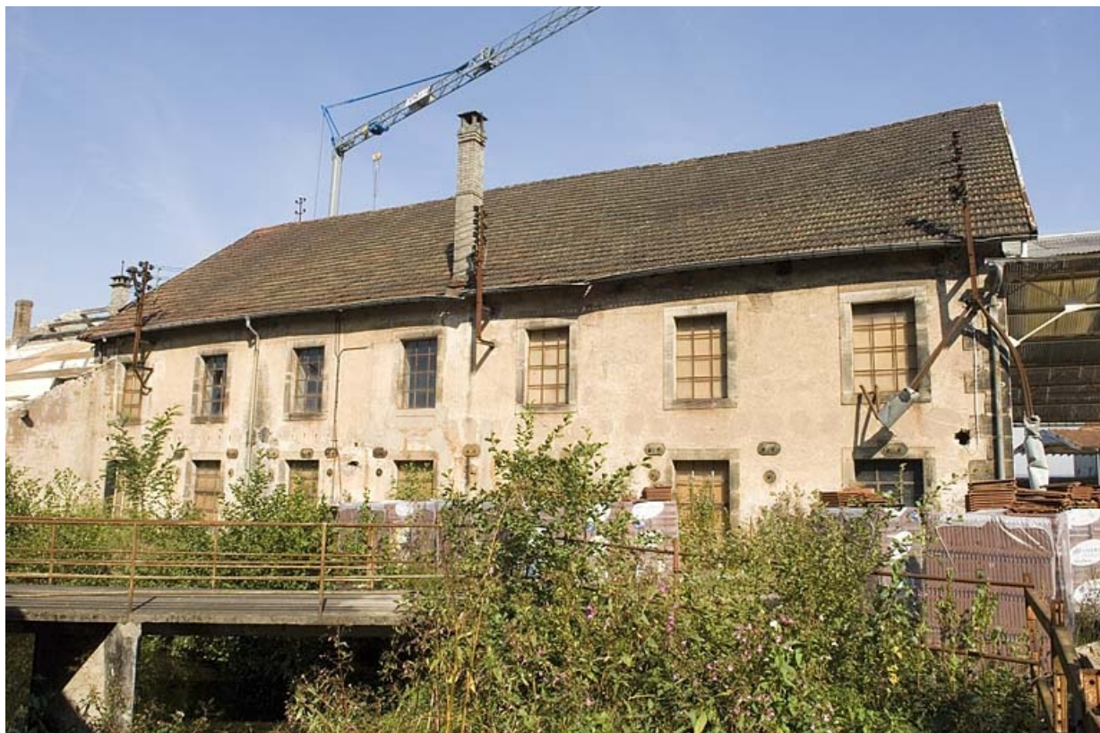
Façade sud de l'atelier de fabrication. 70, Corbenay, 4 avenue Jacques Parisot
