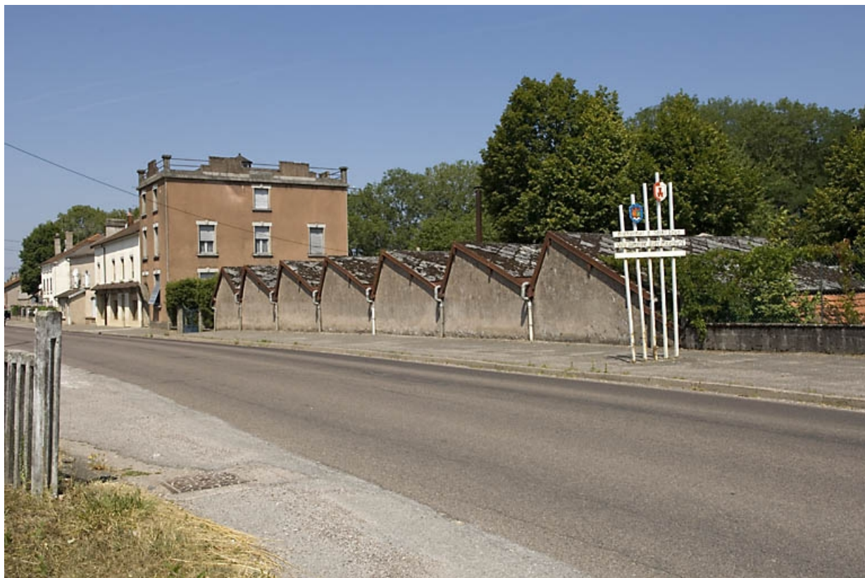
Logement, bureau et atelier de fabrication le long de l'avenue.
