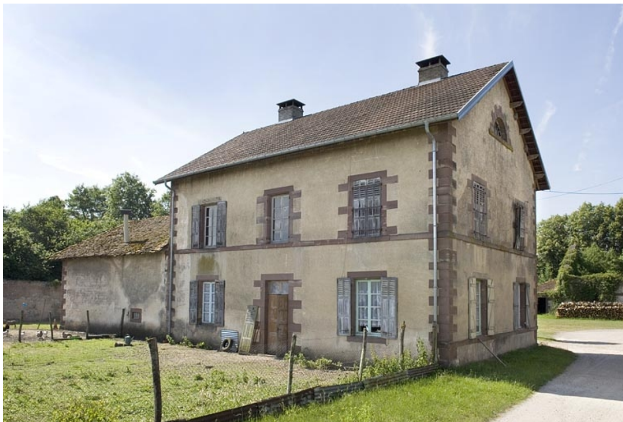
Pavillon est depuis le chemin d'accès. 70, Magnoncourt rue de la Forge
