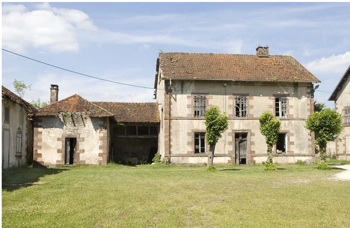
Pavillon ouest depuis la cour.
