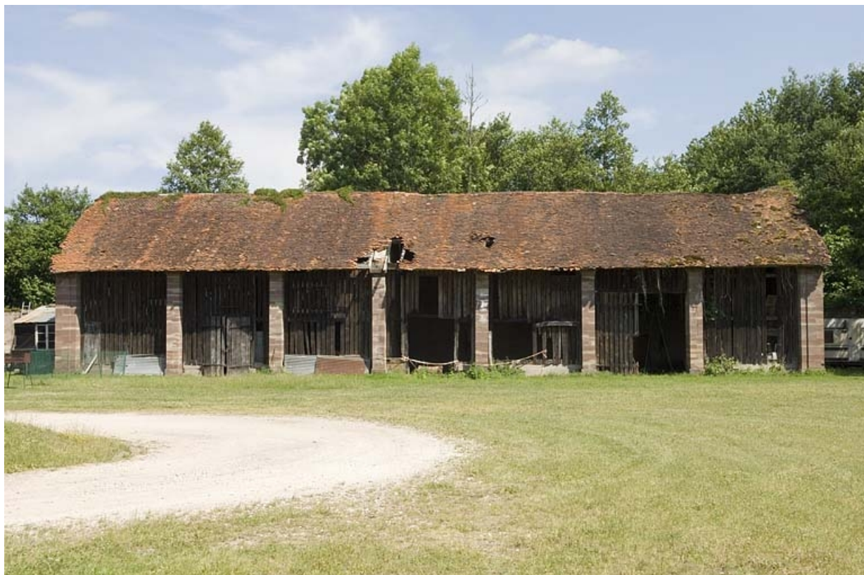
Halle à charbon et écurie vues de face.
