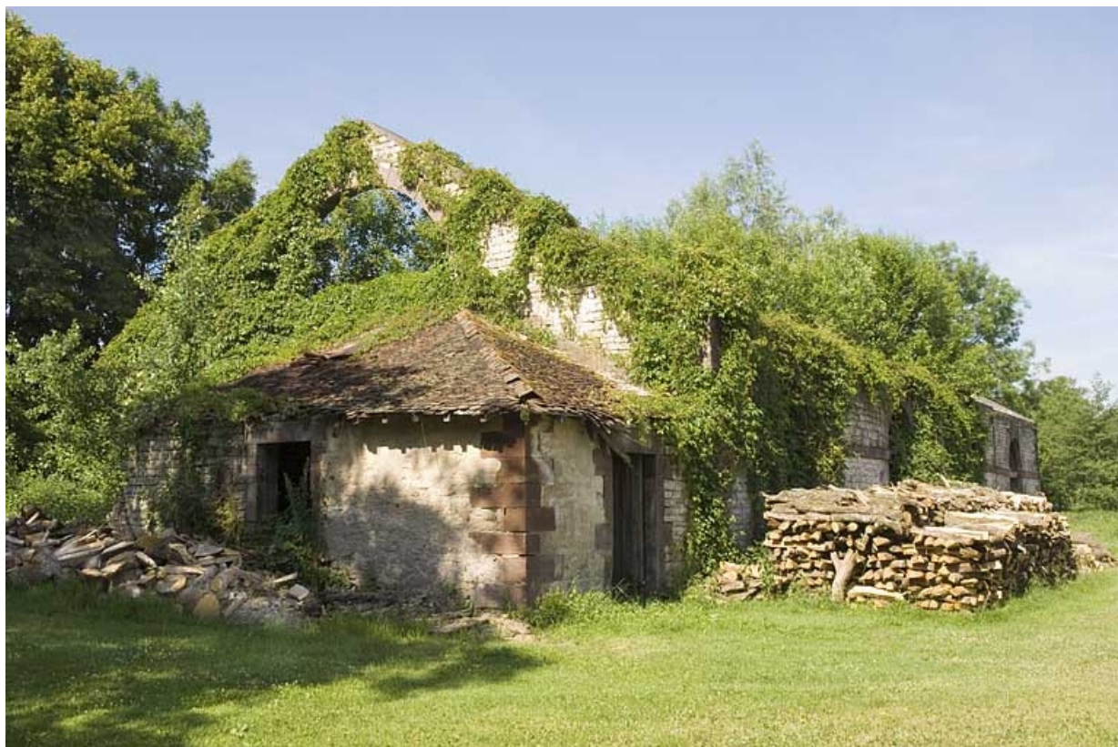
Atelier du laminier (en ruines) depuis l'est. 70, Magnoncourt rue de la Forge
