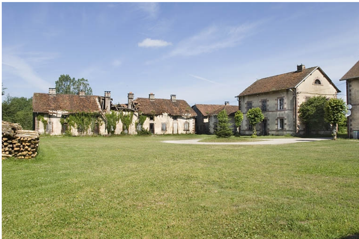
Vue d'ensemble depuis l'angle sud-est de la cour.
