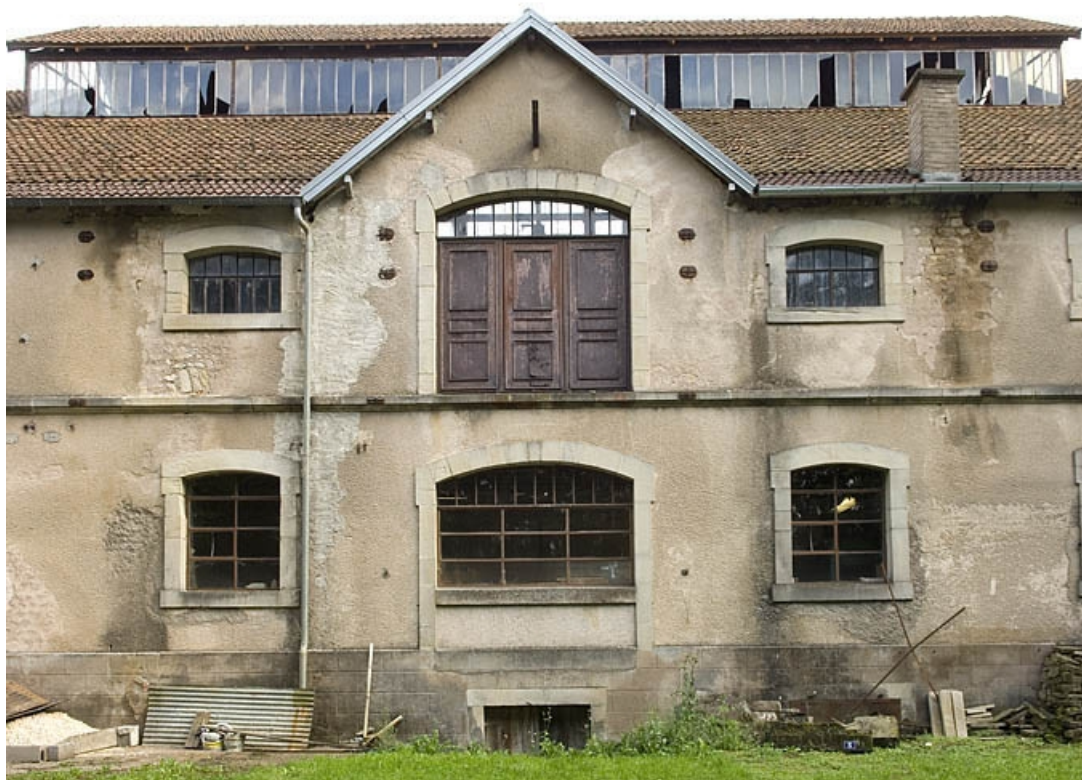
Travée centrale de la façade postérieure.
