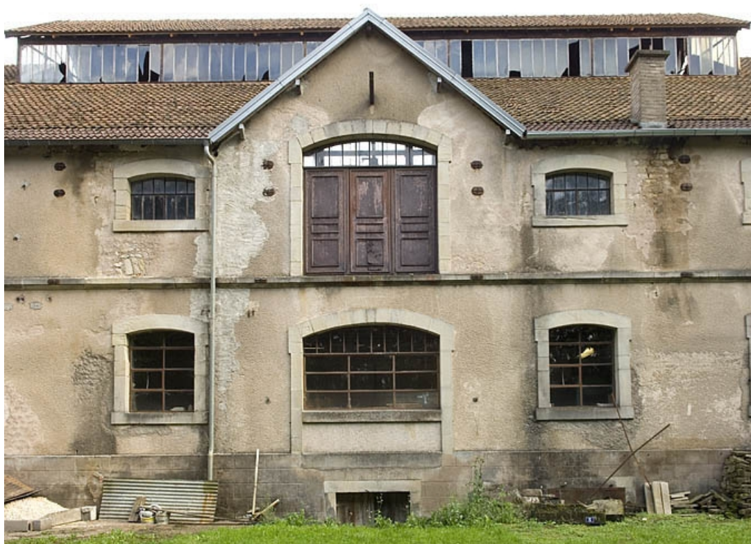
Travée centrale de la façade postérieure.
