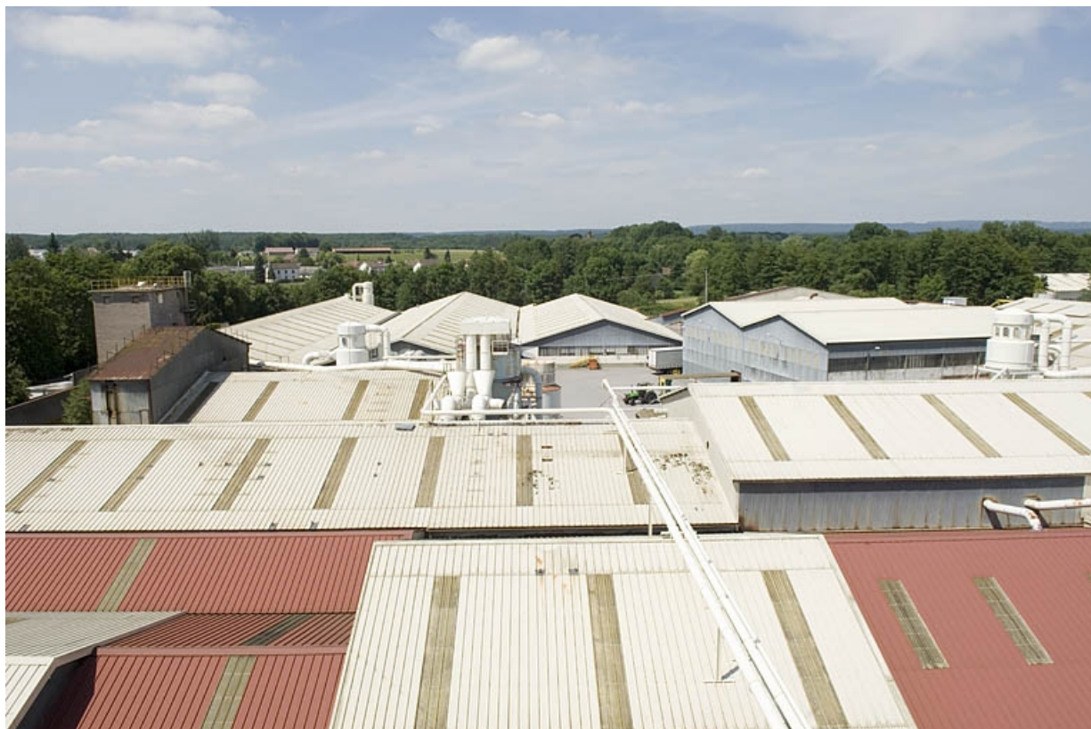
Toitures de l'usine de meubles, vers le nord-est.
