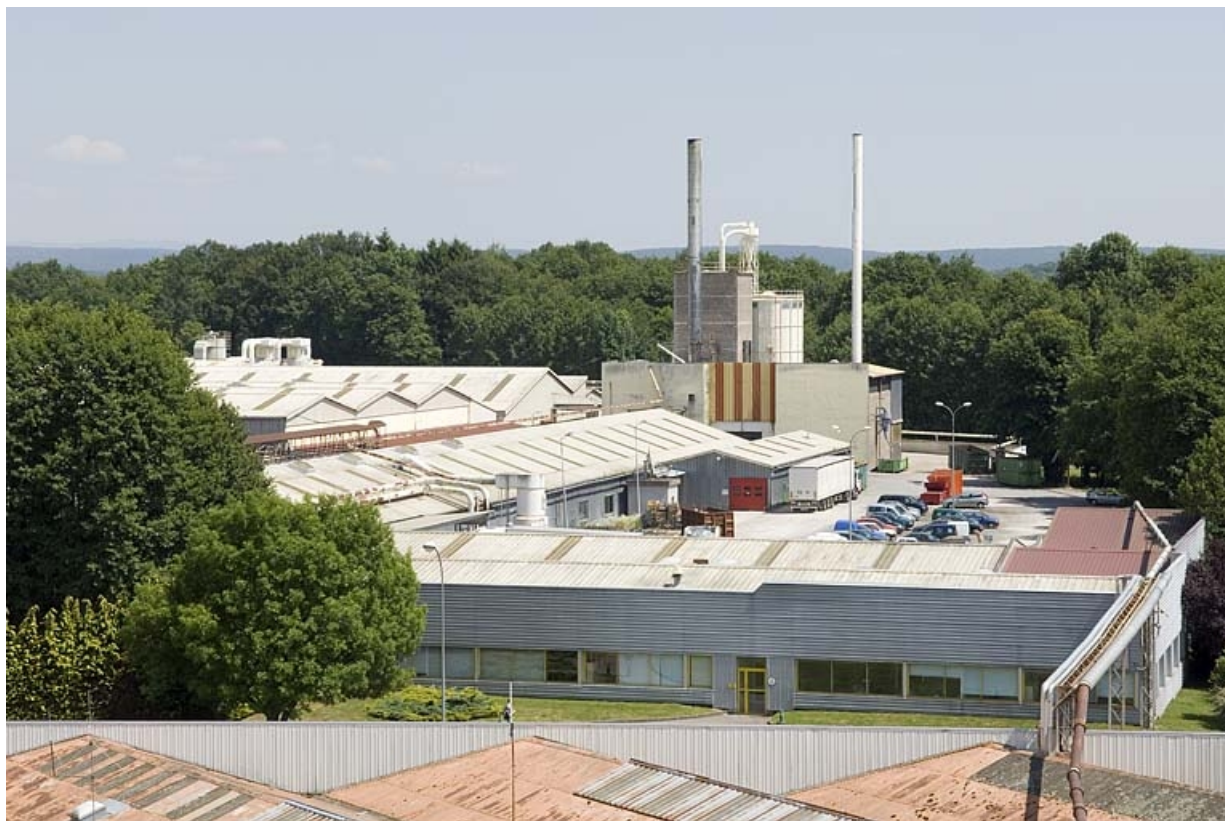
Partie sud de l'usine de meubles.
