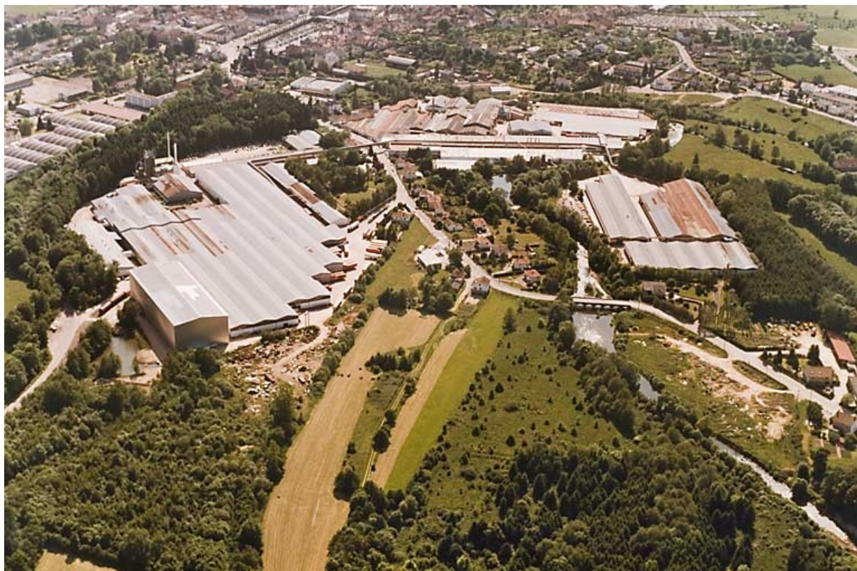
Vue aérienne depuis l'est.
