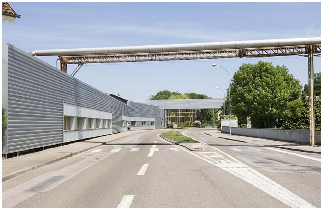
Vue de l'usine depuis l'avenue Jacques Parisot.
