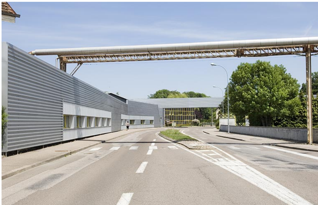
Vue de l'usine depuis l'avenue Jacques Parisot.
