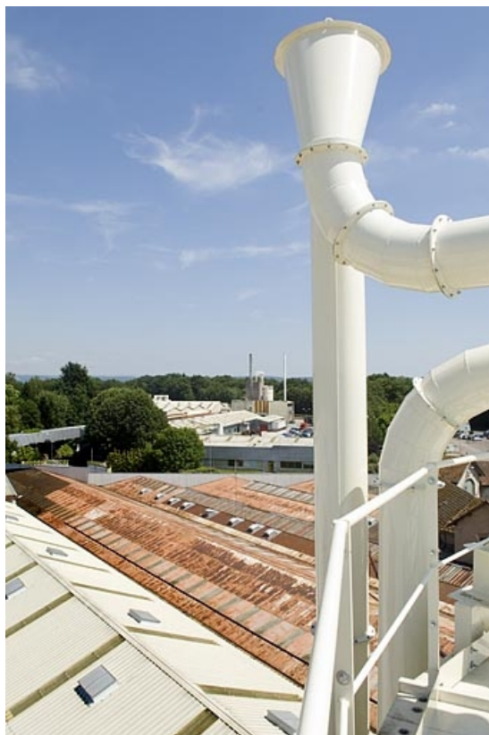
Partie sud de l'usine de meubles depuis un silo.
