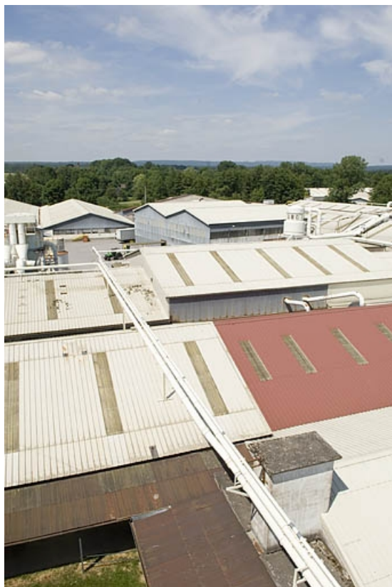
Toitures de l'usine de meubles, vers le nord-est (cadrage vertical).
