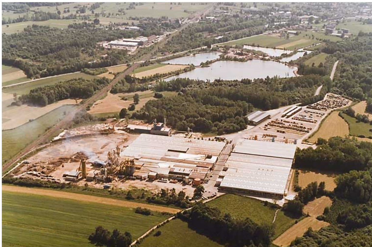
Usine de panneaux de particules de bois, dite Cie française du Panneau. Vue aérienne depuis le nord-est. 70, Saint-Loup-sur-Semouse, 15 avenue Jacques Parisot
