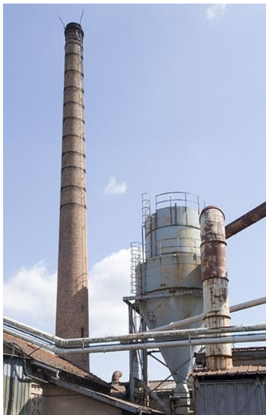
Cheminée et silo. Vue rapprochée.
