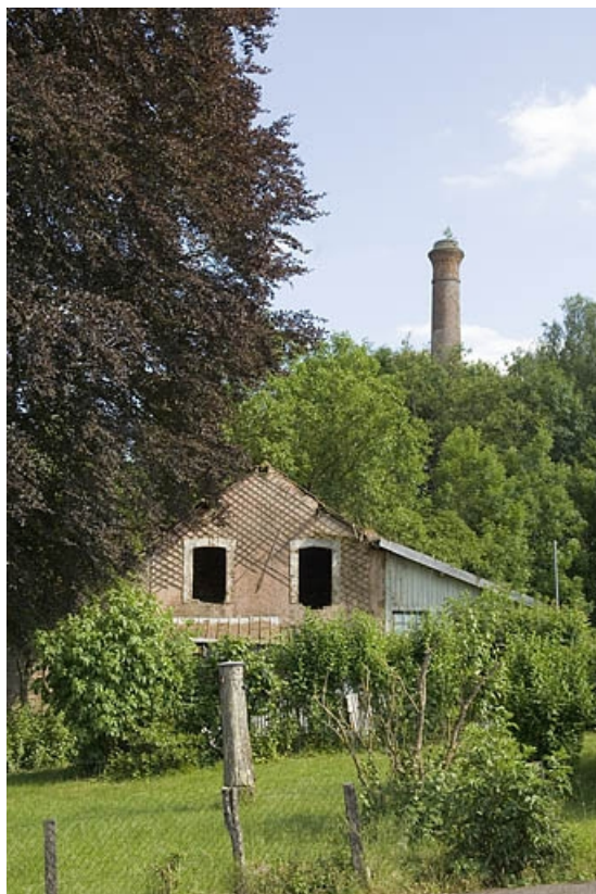
Dépendance située entre l'usine et la cité Saint-Anne.
