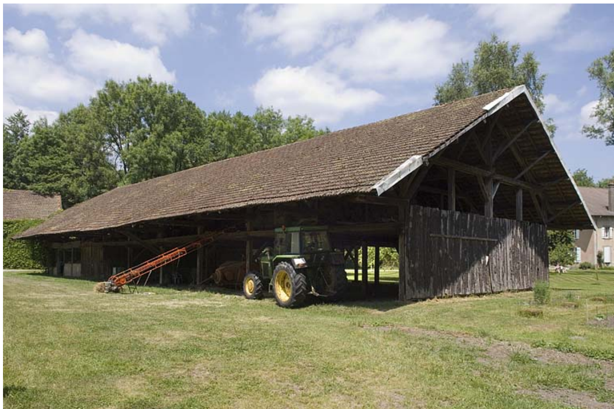
Entrepôt industriel vu depuis le sud.
