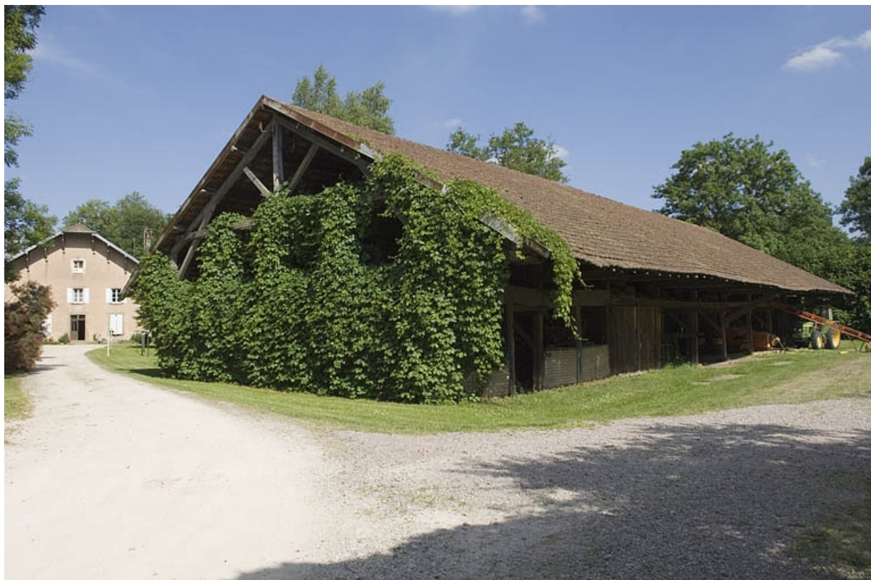
Entrepôt industriel vu depuis l'ouest.
