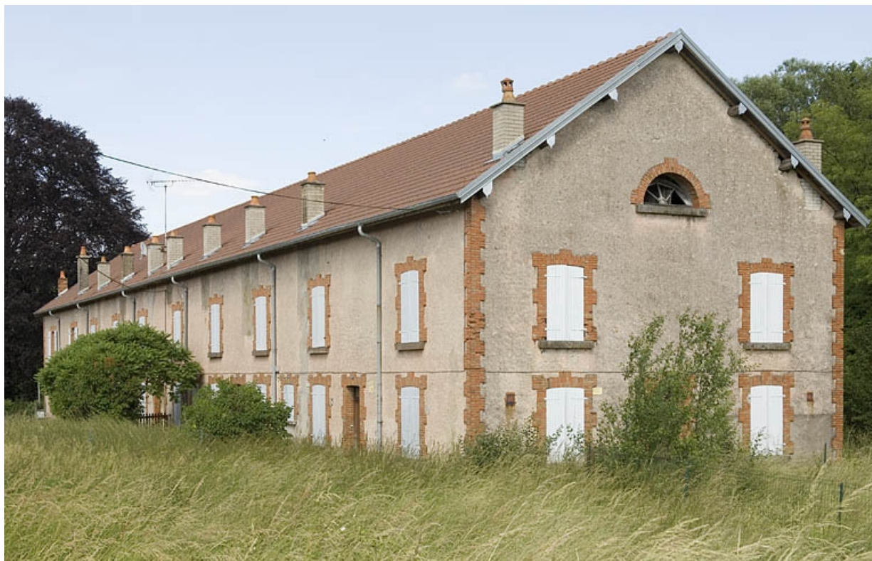
Logement ouvrier dit cité Saint-Anne. Vue depuis le sud-ouest.
