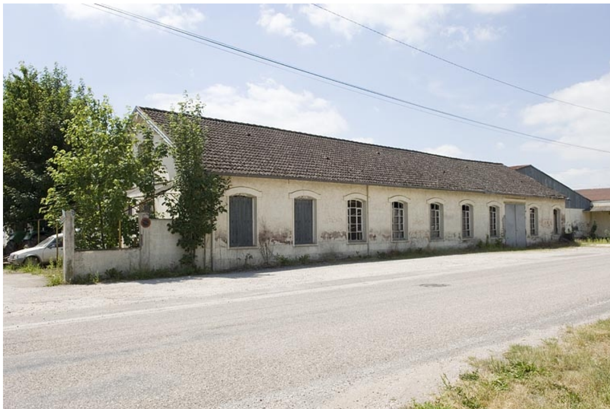
Atelier de fabrication sur rue. Vue de trois quarts gauche.
