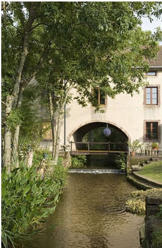
Passage du bief de dérivation sous le bâtiment.
