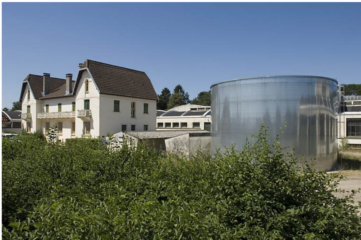
Le bâtiment des bureaux depuis le sud-est. 70, Saint-Loup-sur-Semouse rue de la Viotte
