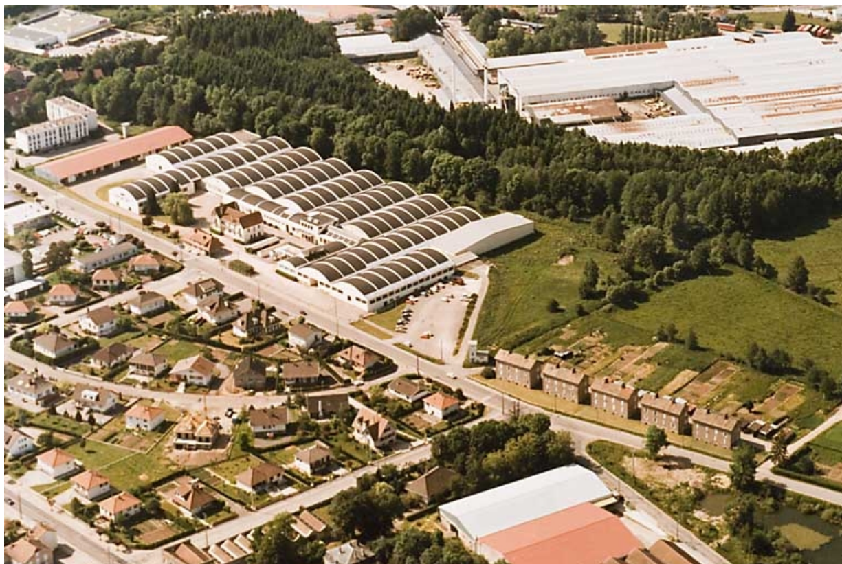
Vue aérienne depuis le sud-est.
