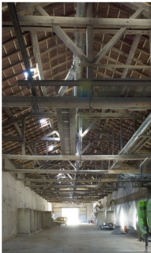
Intérieur de l'atelier de fabrication.
