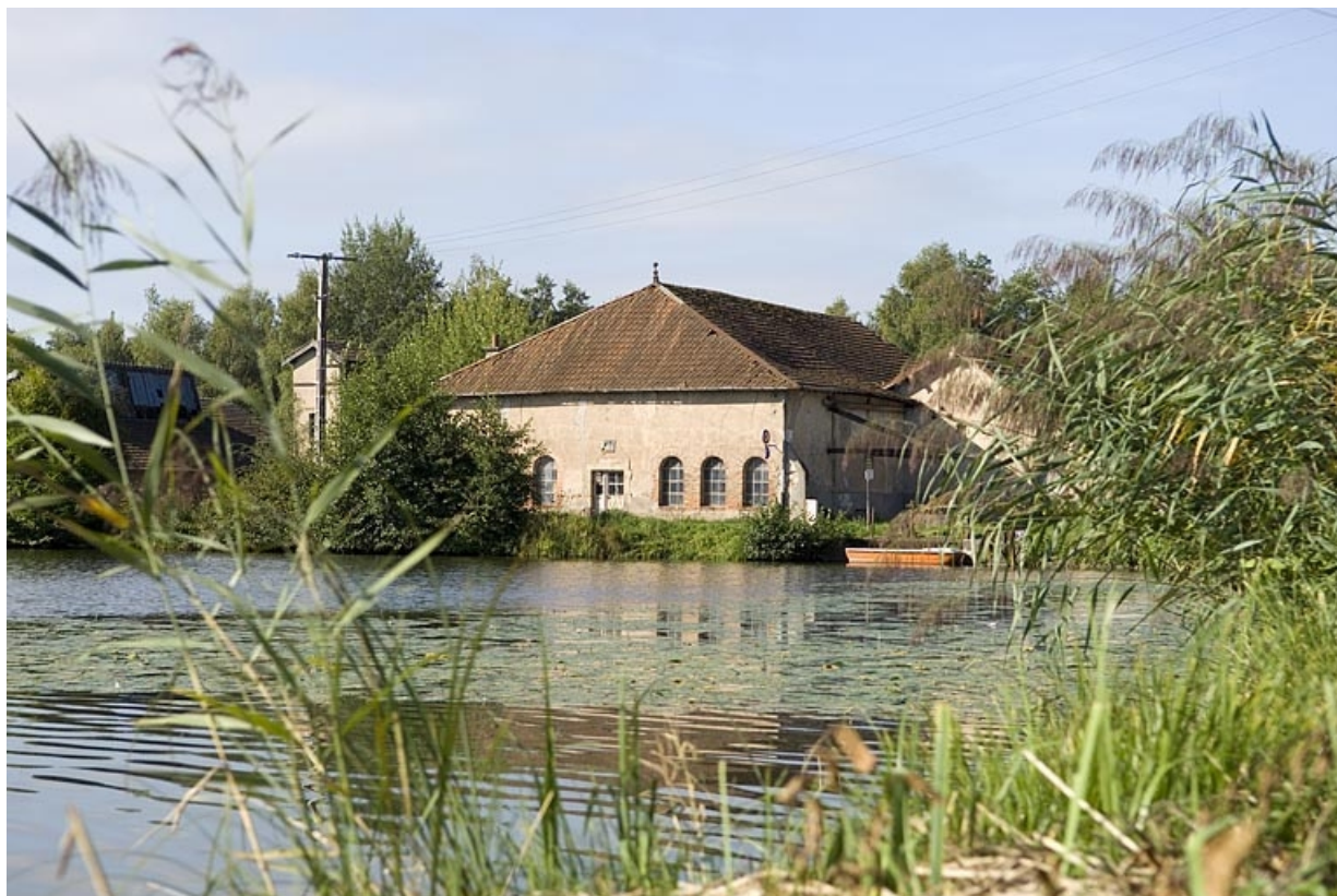
Vue depuis l'étang, à l'est.
