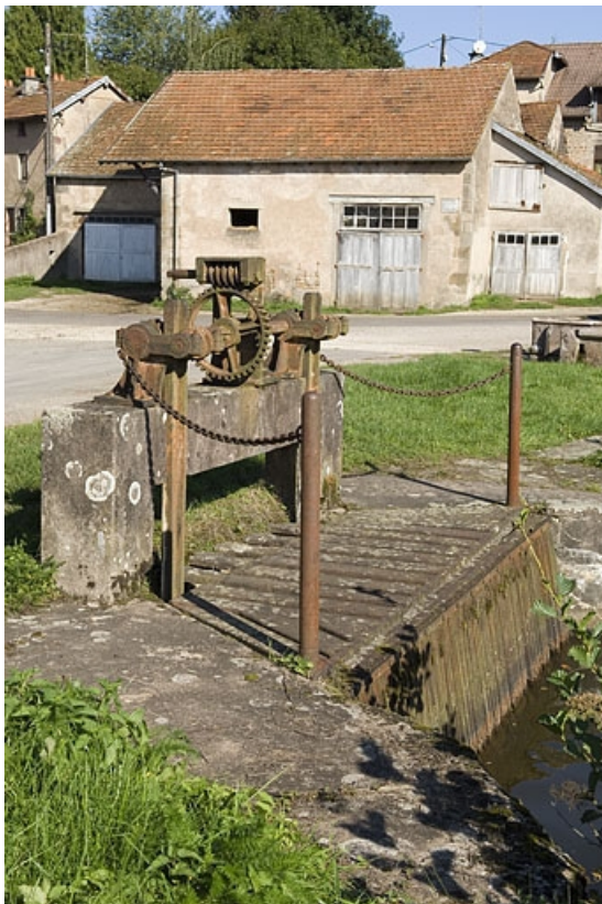
Vanne de prise d'eau de l'étang.
