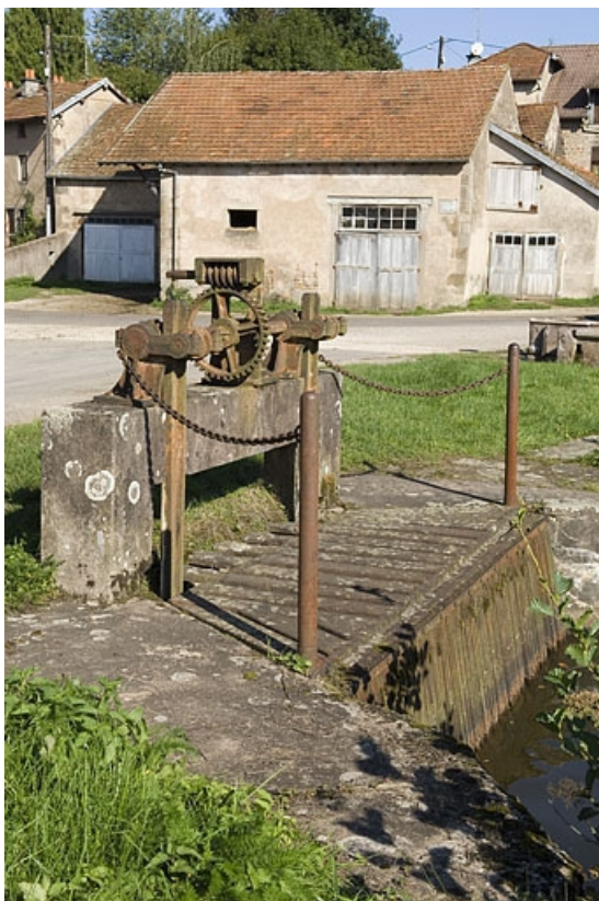
Vanne de prise d'eau de l'étang.
