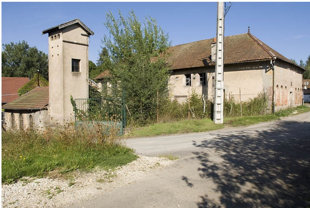
Vue des bâtiments depuis la chaussée de l'étang.
