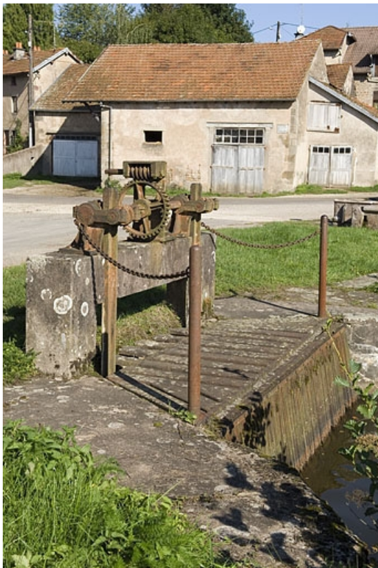
Vanne de prise d'eau de l'étang.
