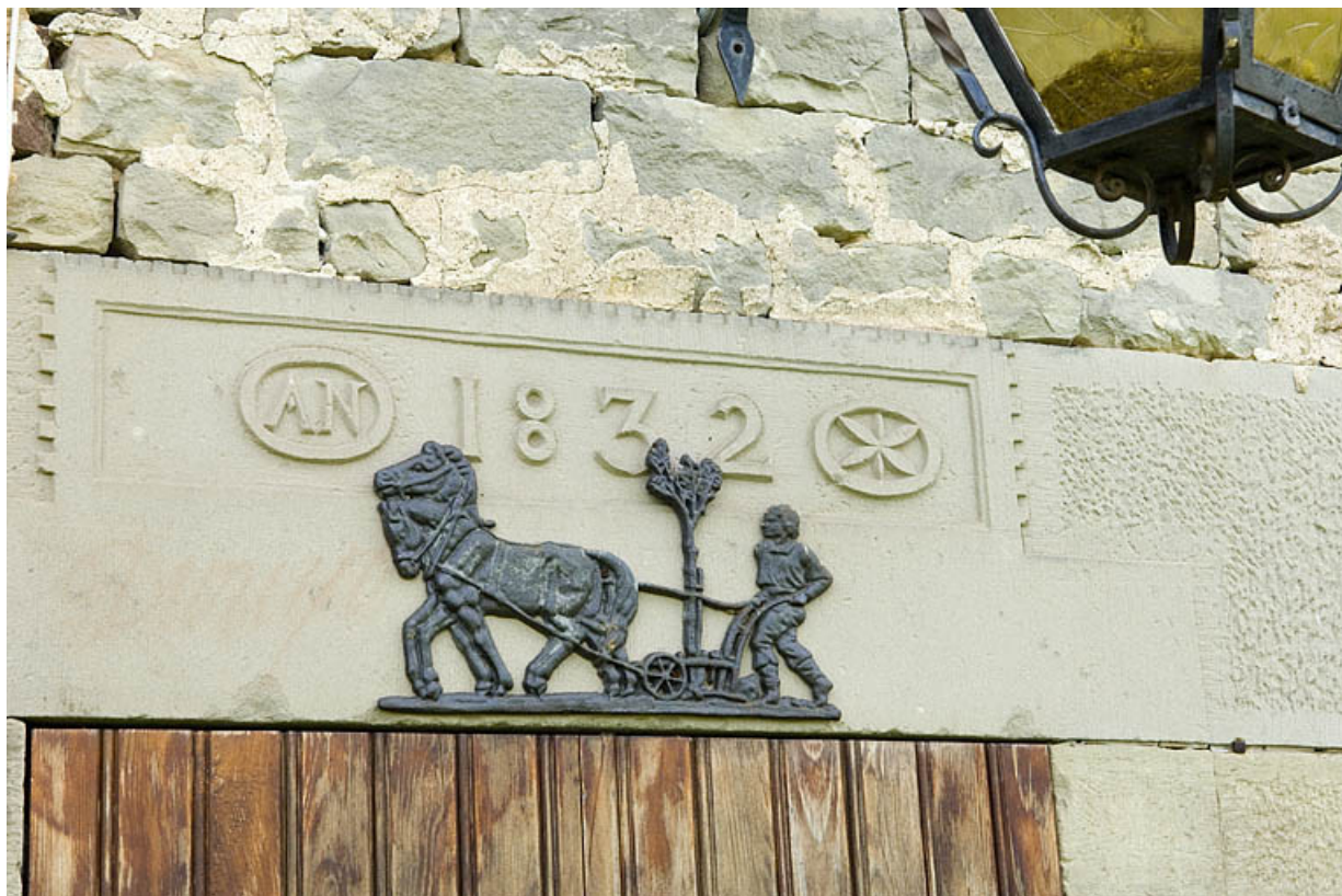
Logement ouvrier collectif (est). Détail d'un linteau.
