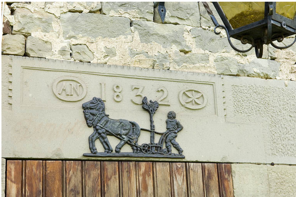
Logement ouvrier collectif (est). Détail d'un linteau.
