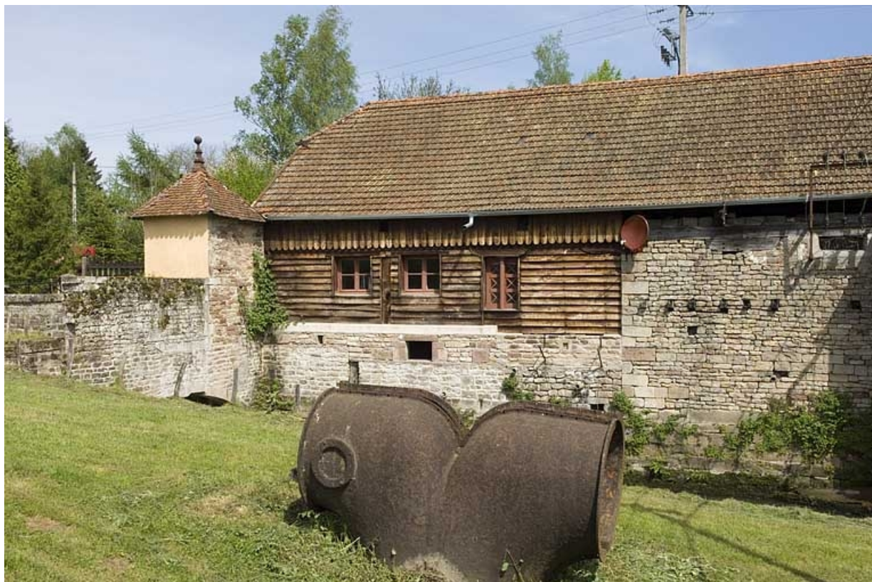
Façade sud de l'atelier de fabrication.
