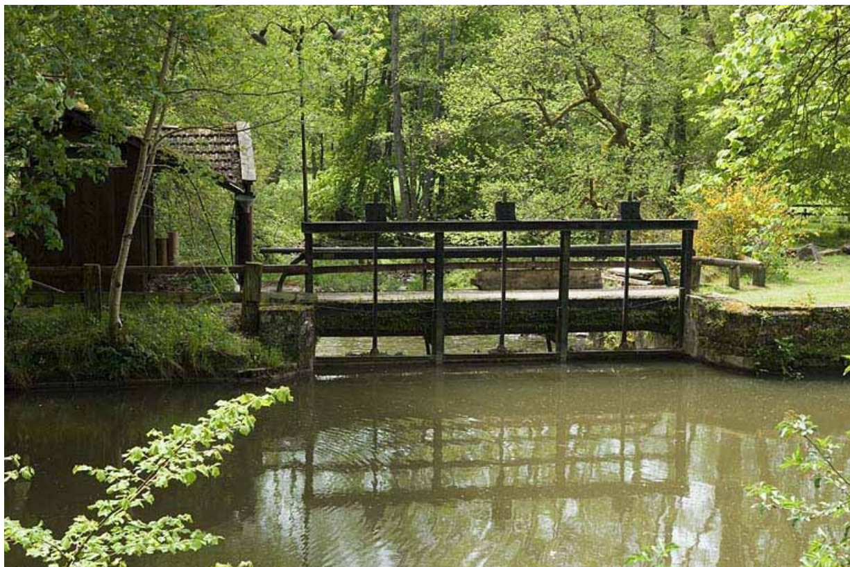
Vannes de décharge sur le bief d'aménée.
