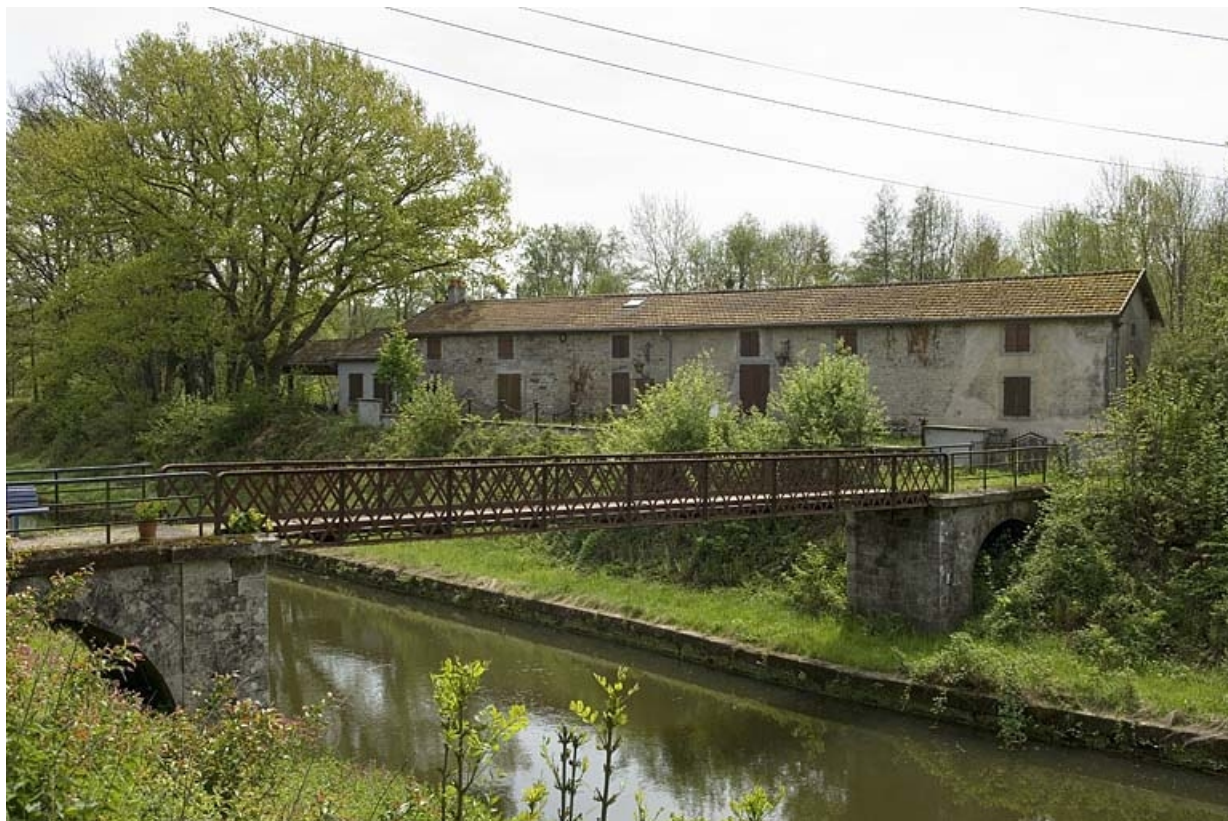
Vue d'ensemble du logement ouvrier collectif (est).
