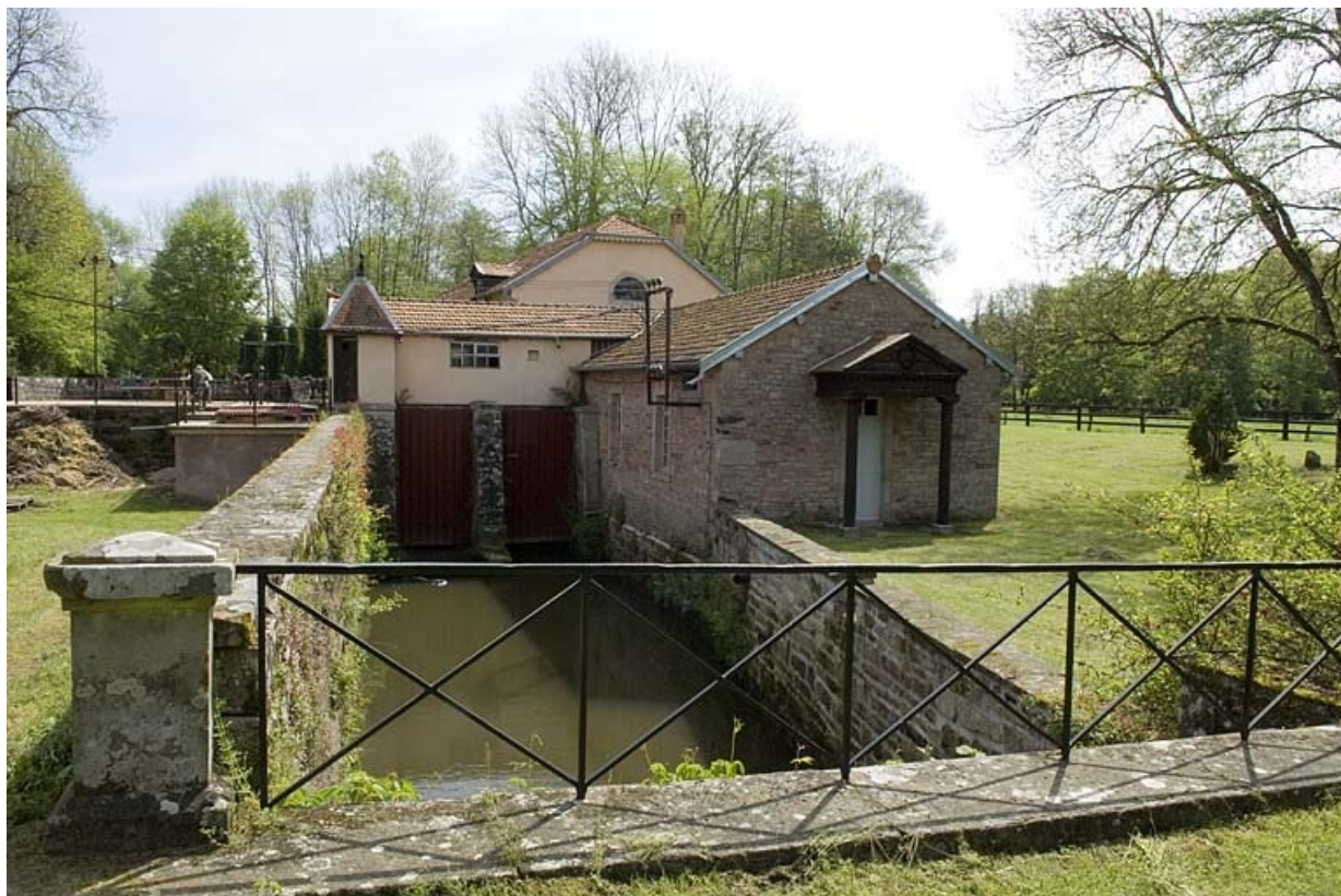
Canal de fuite de la salle des machines (sud). 70, Pont-du-Bois, lieudit : la Forge
