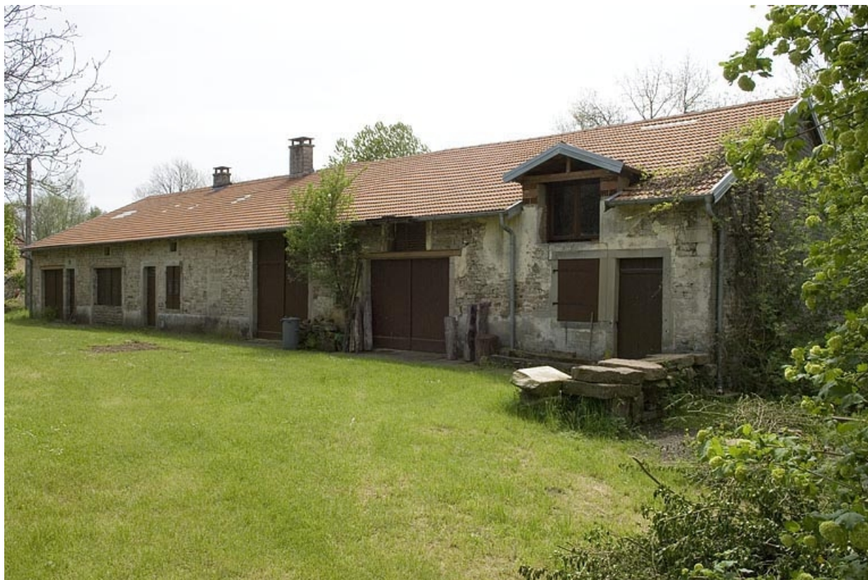
Logement ouvrier collectif (ouest). Vue de trois quarts.
