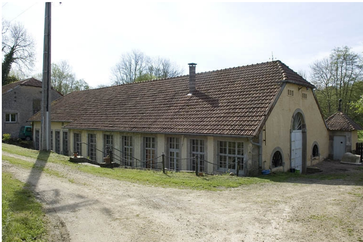
Atelier de fabrication (rive droite) vu de trois quarts.
