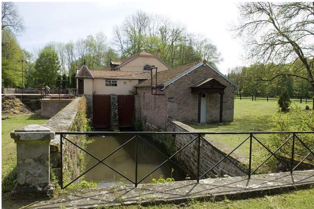
Canal de fuite de la salle des machines (sud). 70, Pont-du-Bois, lieudit : la Forge
