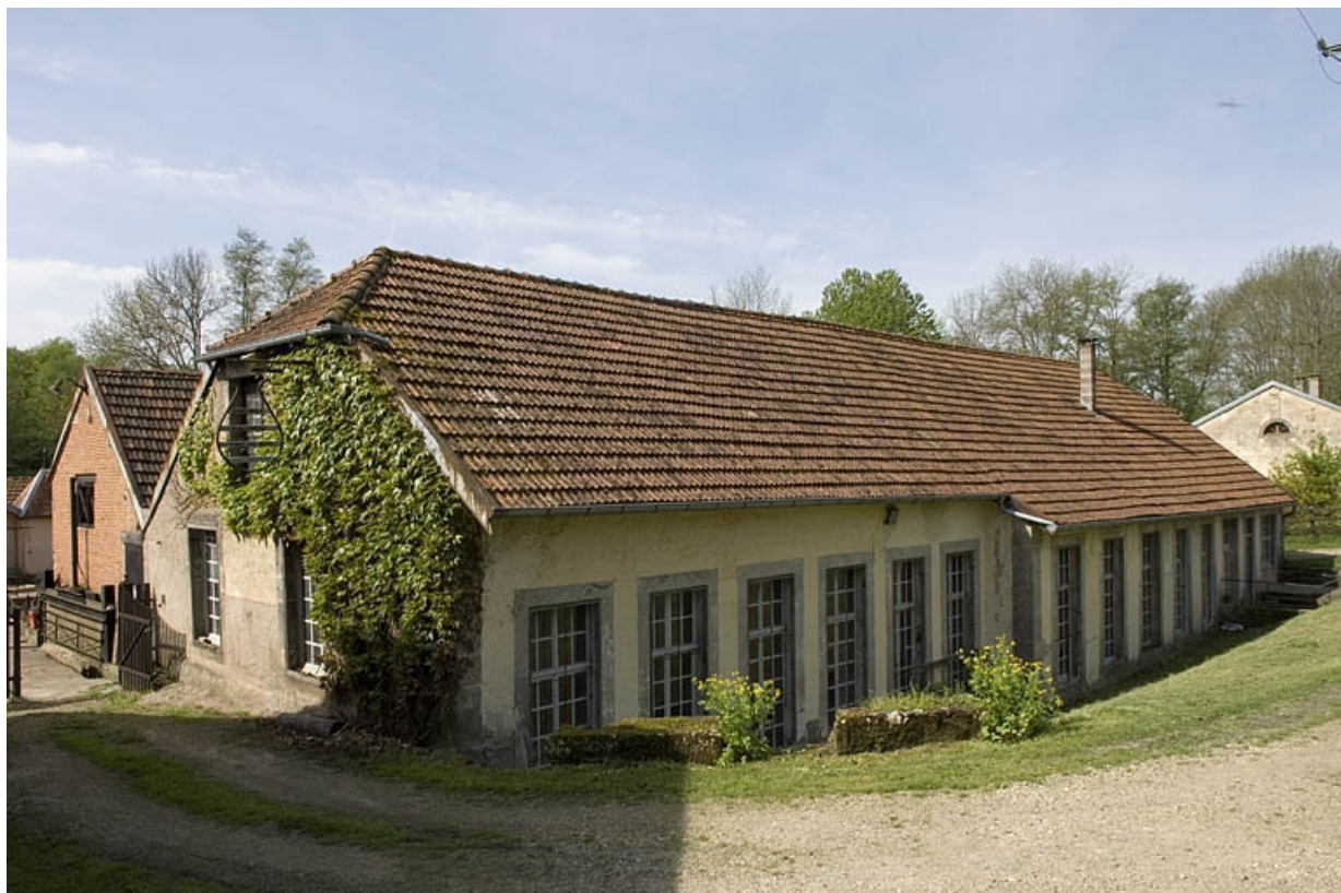
Atelier de fabrication (rive droite) depuis le nord-est.
