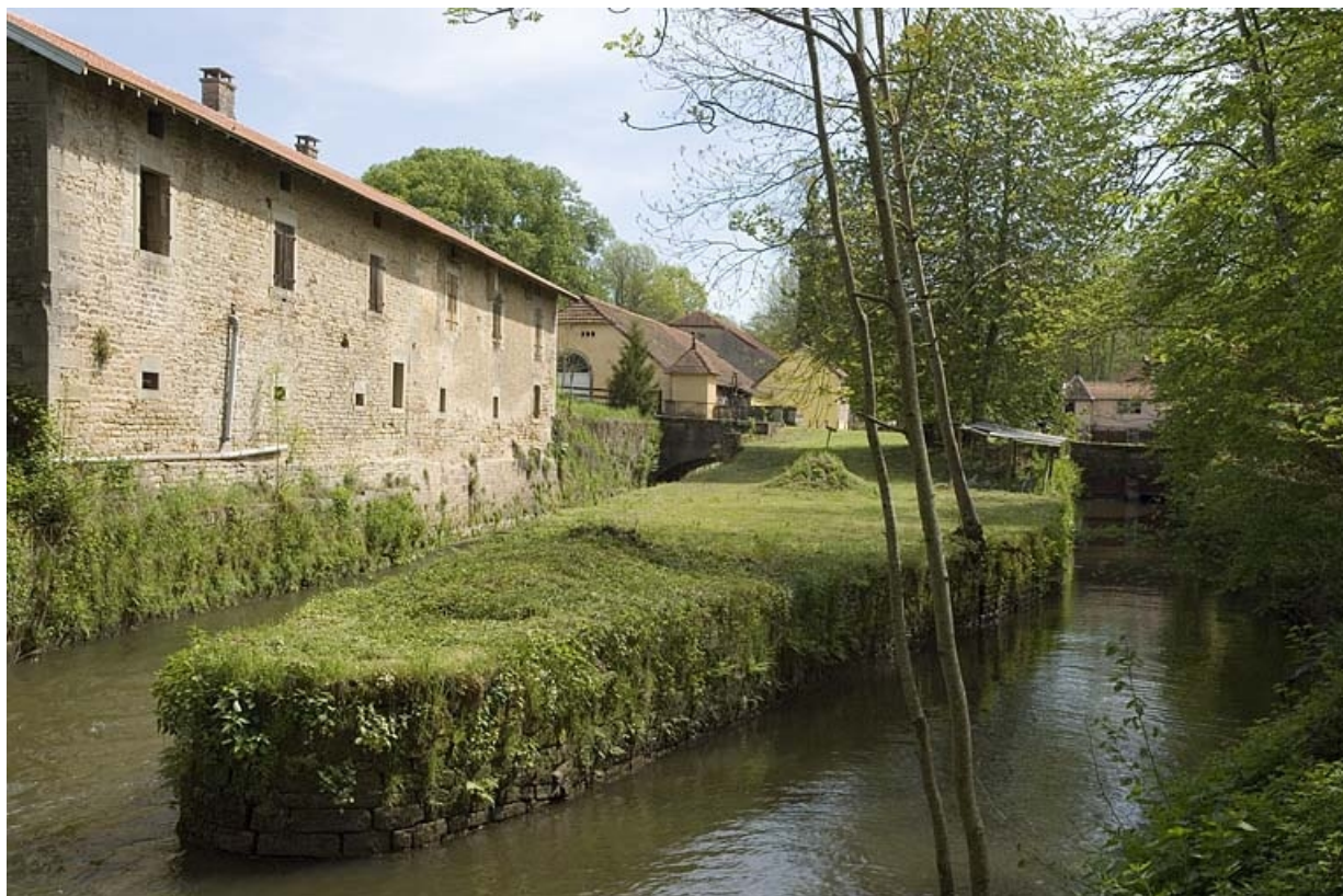
Vue d'ensemble depuis l'ouest. 70, Pont-du-Bois, lieudit : la Forge
