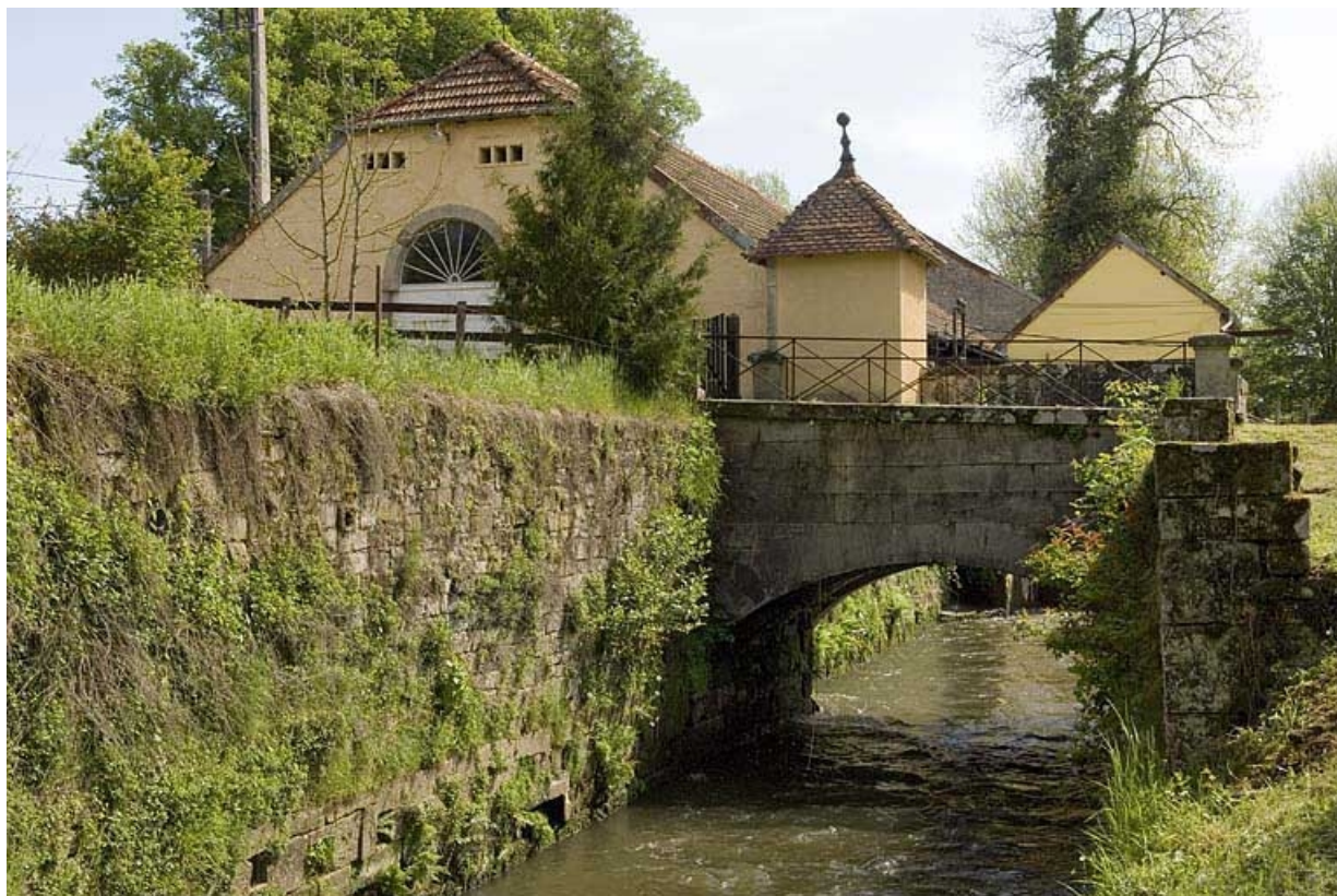
Canal de fuite de la salle des machines (nord).
