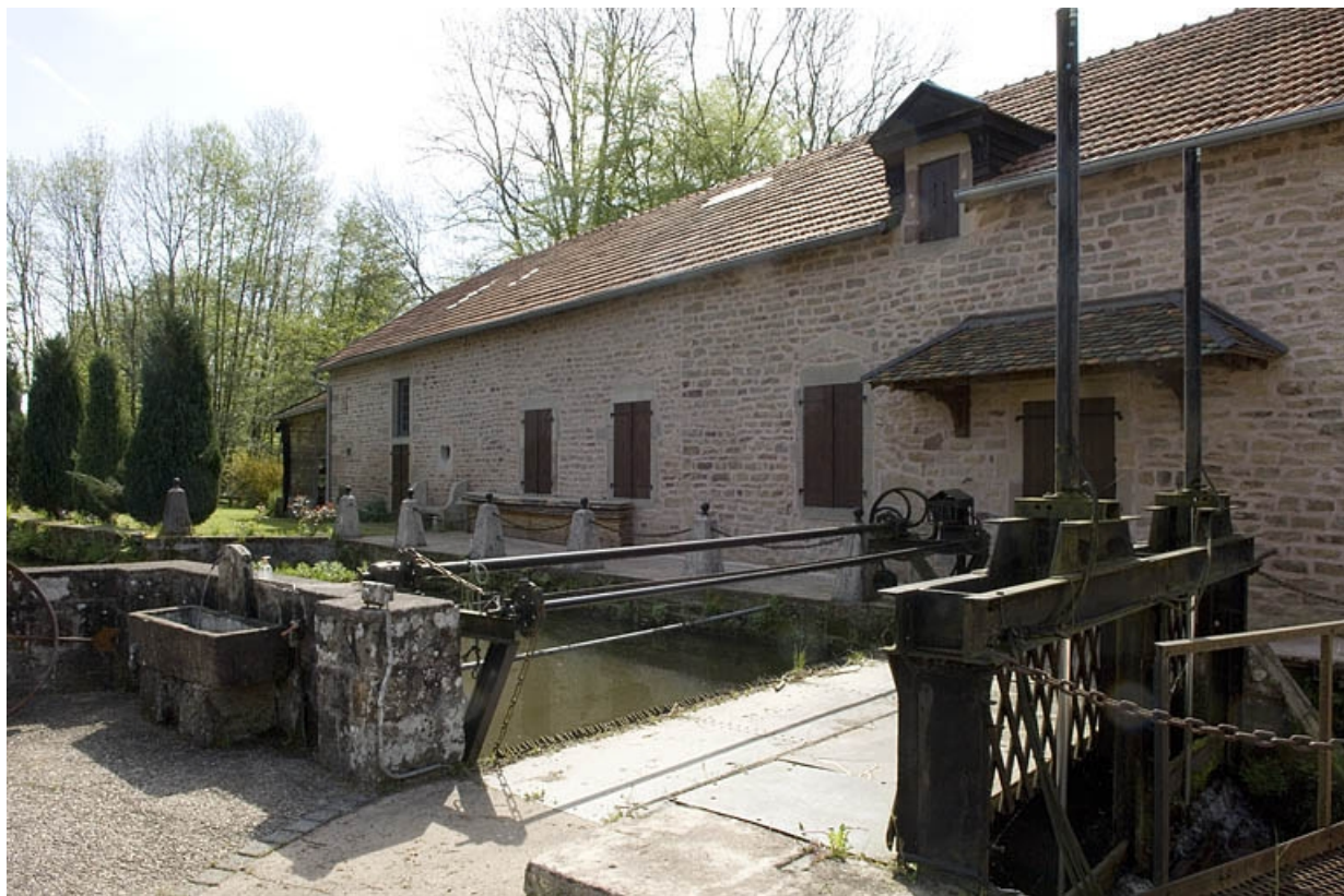
Logement (rive gauche) depuis l'est.
