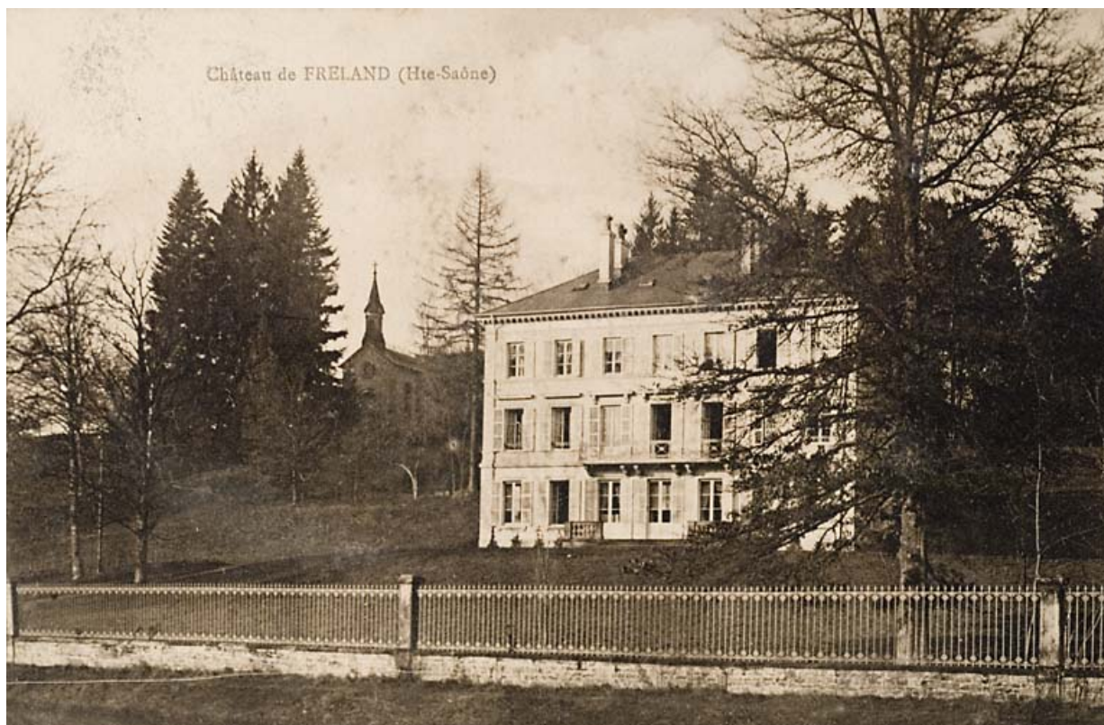
Vue d'ensemble [fin 19e ou début 20e siècle]. 70, Mailleroncourt-Saint-Pancras, lieudit : Freland
