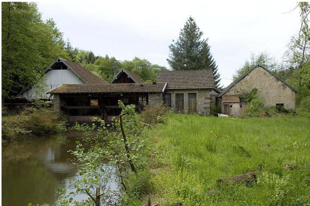
Façades postérieures depuis le bief d'aménée. 70, Mailleroncourt-Saint-Pancras, lieudit : Freland
