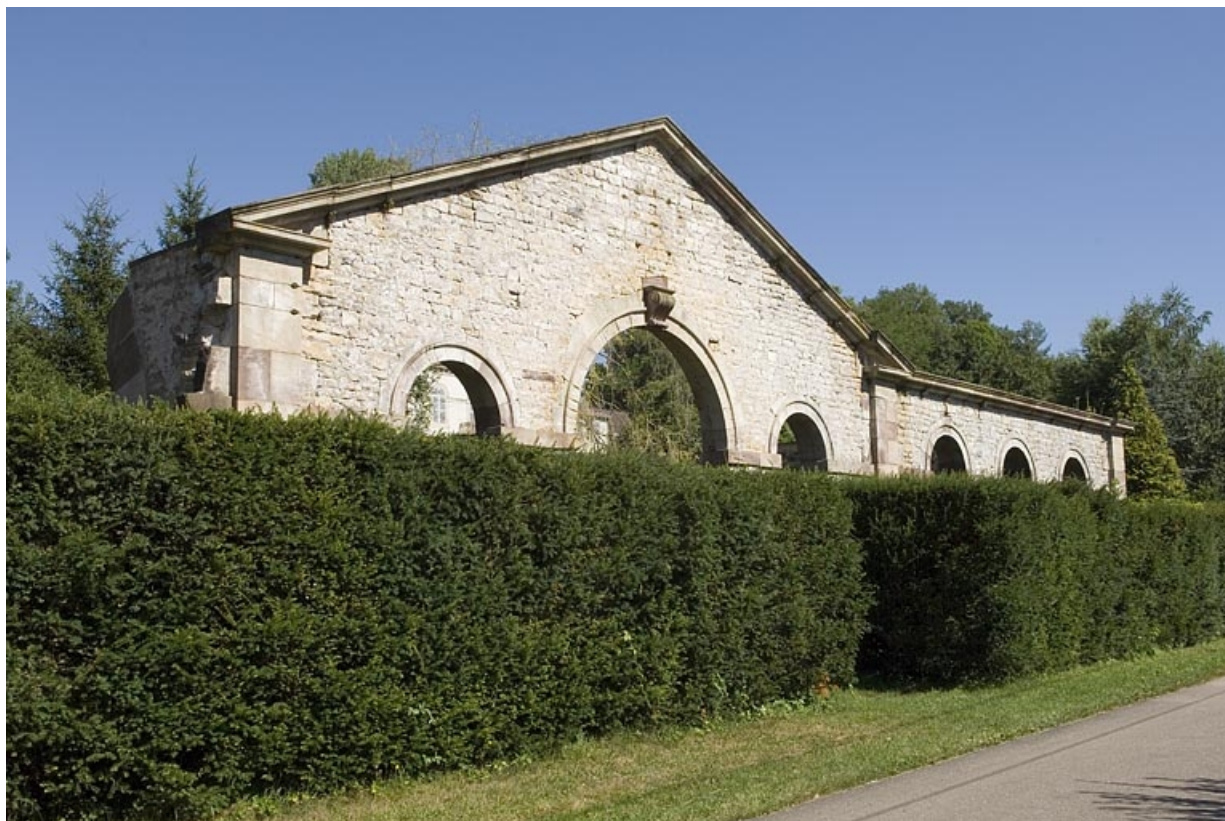
Façade antérieure de l'atelier du haut fourneau.
