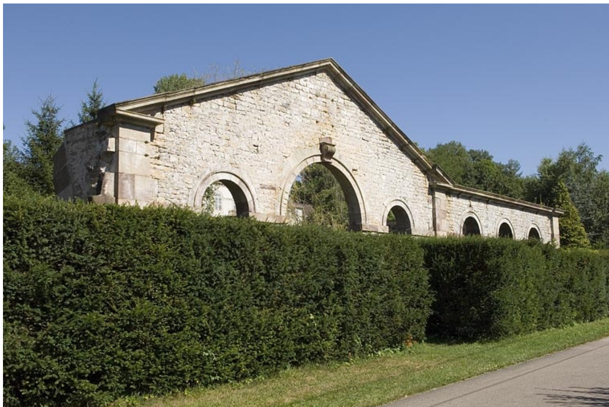
Façade antérieure de l'atelier du haut fourneau.
