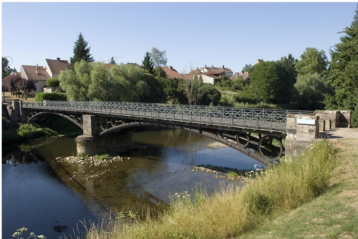
Pont métallique sur la Lanterne (commune de Bourguignon-lès-Conflans). Réalisation des forges de Varigney. 70, Dampierre-lès-Conflans, lieudit : Varigney
