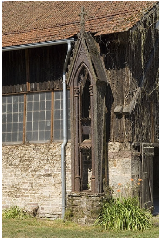
Pinacle en fonte adossé au magasin industriel.
