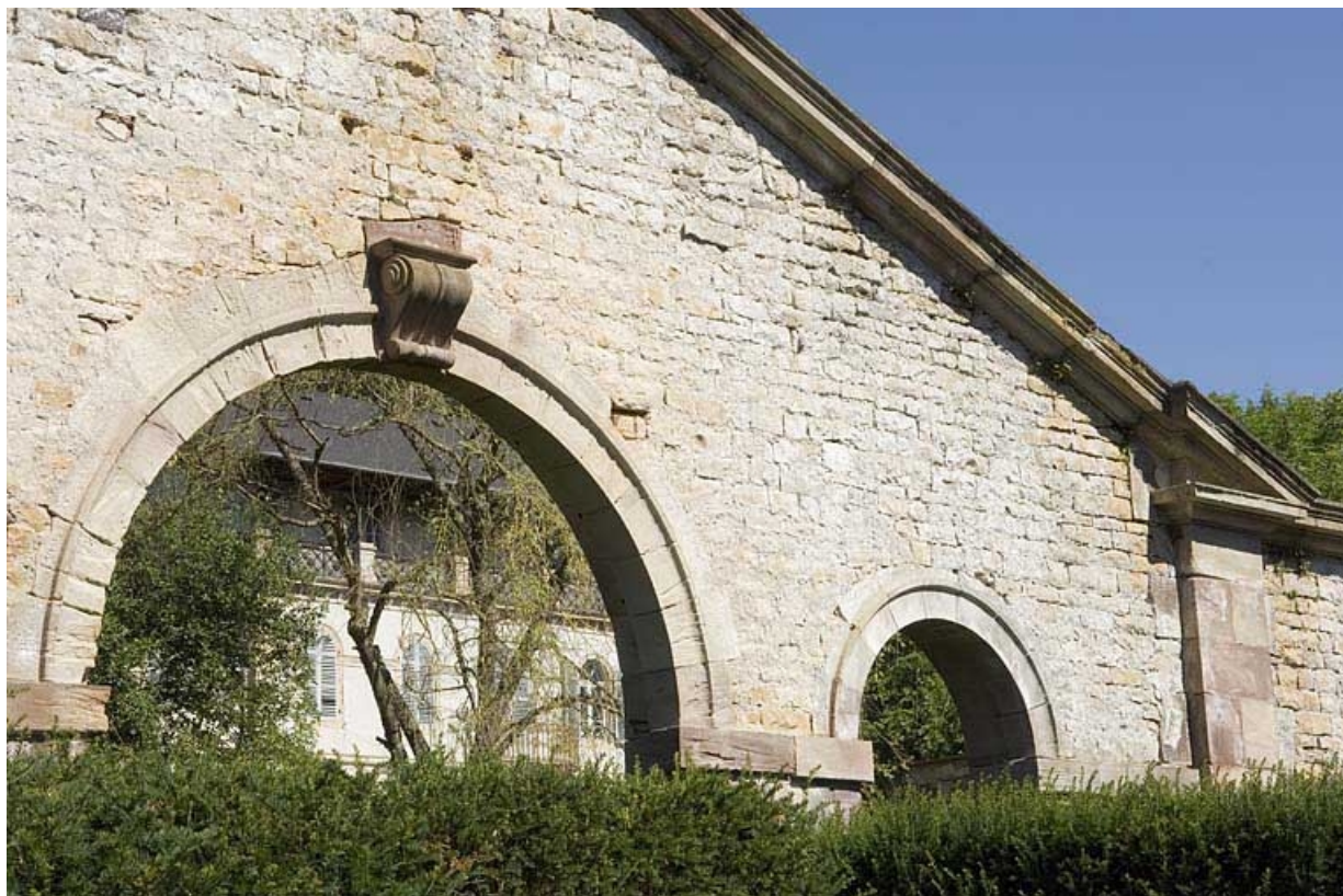
Façade antérieure de l'atelier du haut fourneau. Détail du fronton.
