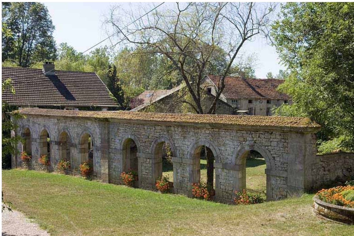
Vestiges de l'atelier de fabrication. Mur nord.
