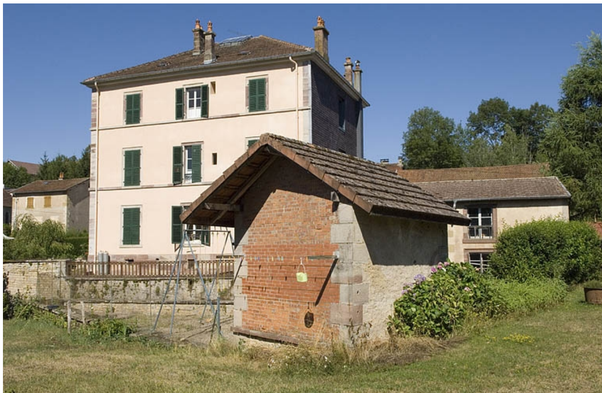
Logement patronal sud. Façade postérieure.
