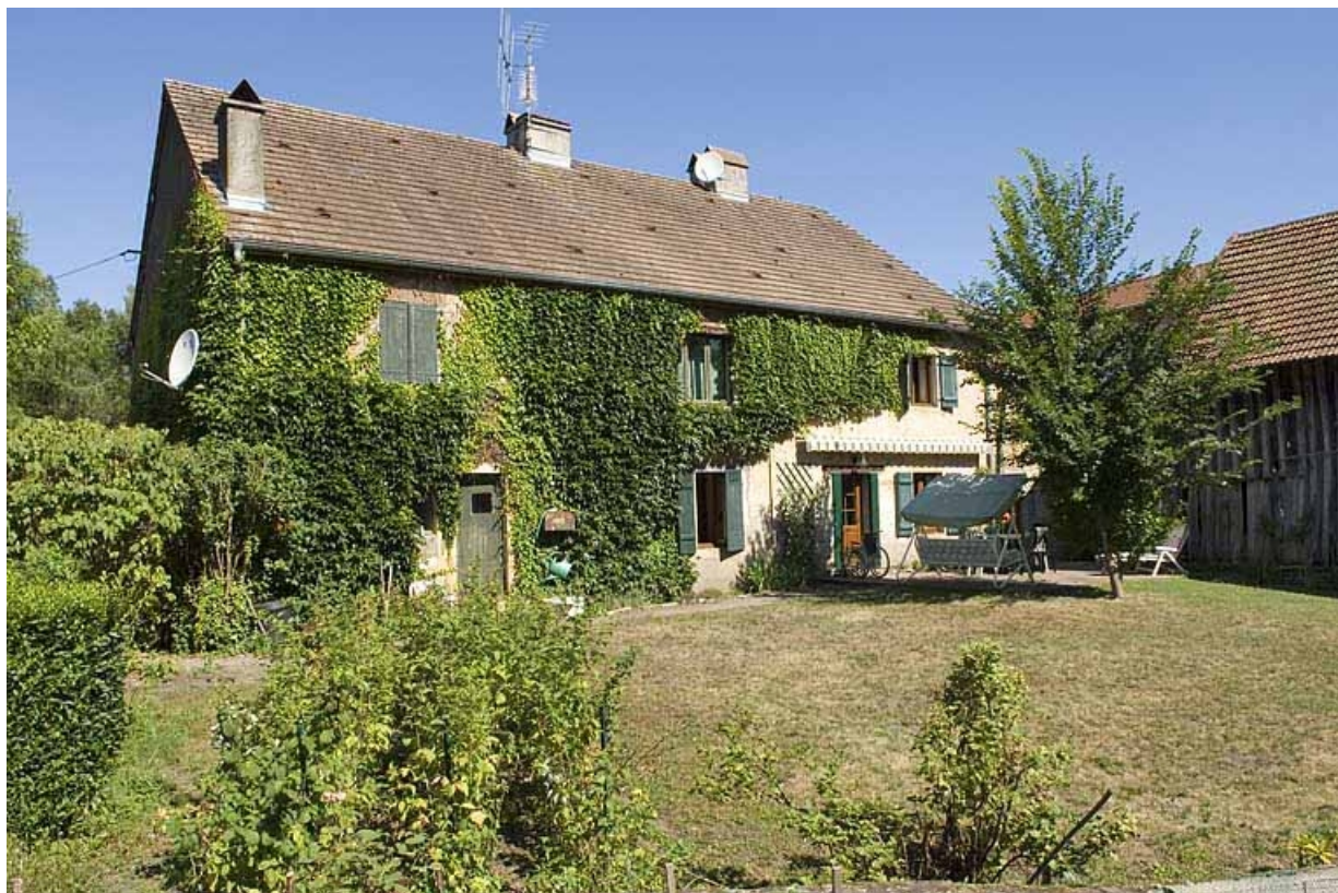
Ancien magasin, actuellement logement. Façade postérieure.
