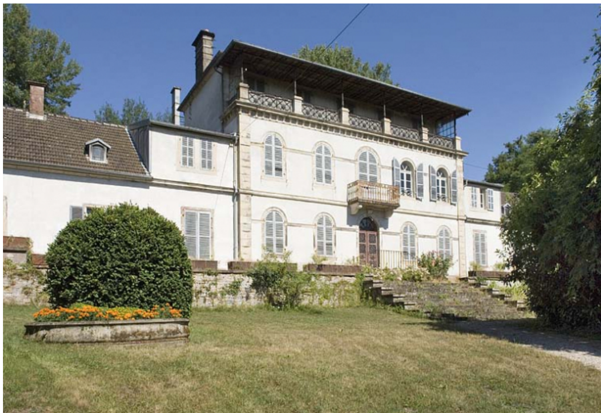
Logement patronal nord. Façade antérieure.
