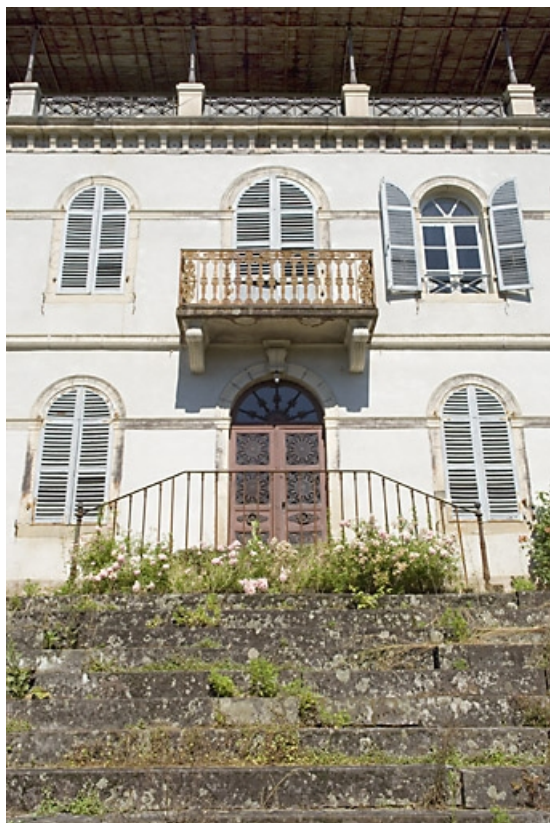
Logement patronal nord. Détail des travées centrales.
