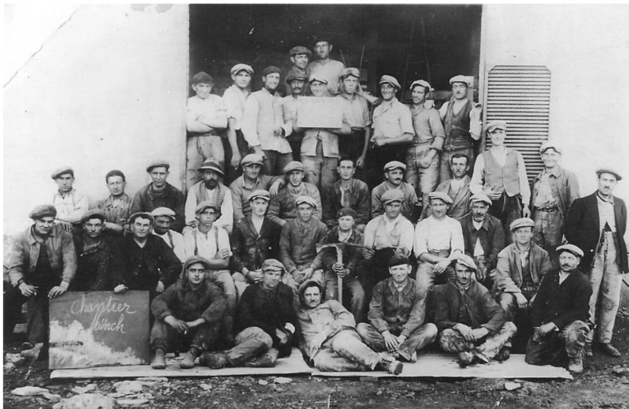
Ouvriers de l'entreprise Cilia [ ?] chantier Münch. 70, Creveney, lieudit : Prés du Grand Bois
