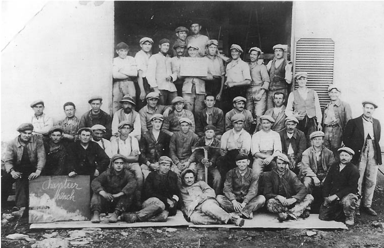
Ouvriers de l'entreprise Cilia [ ?] chantier Münch. 70, Creveney, lieudit : Prés du Grand Bois
