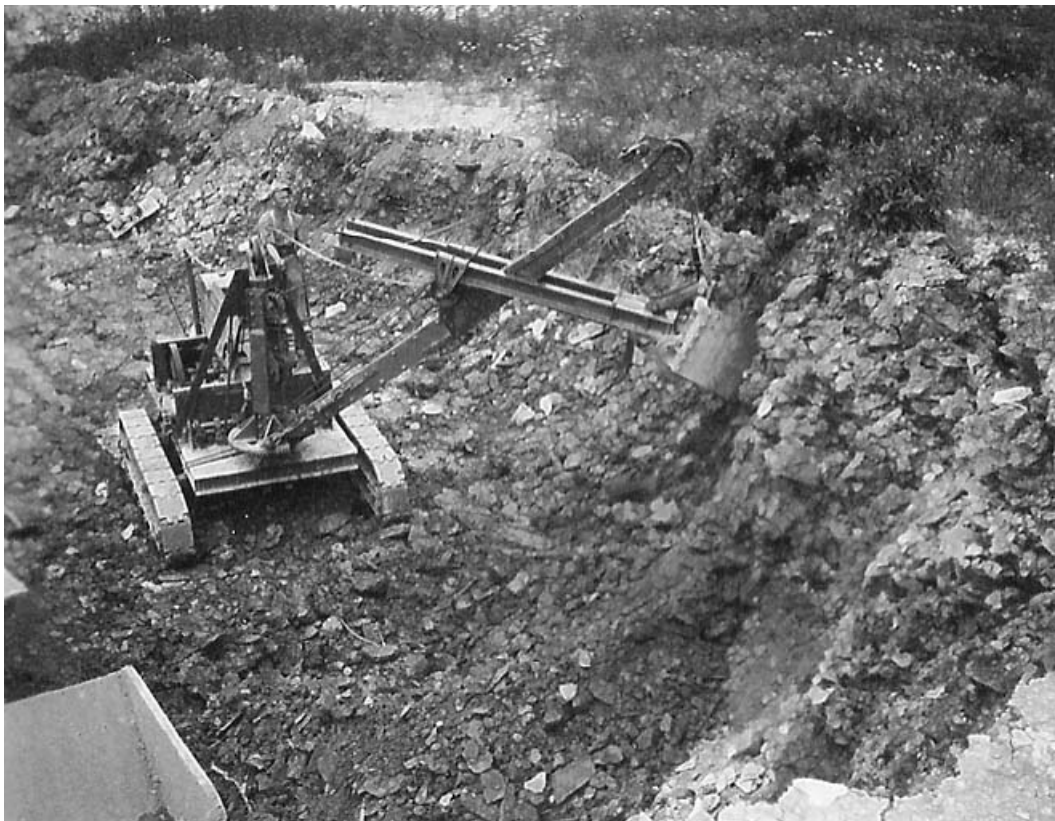
La pelle mécanique en action.
