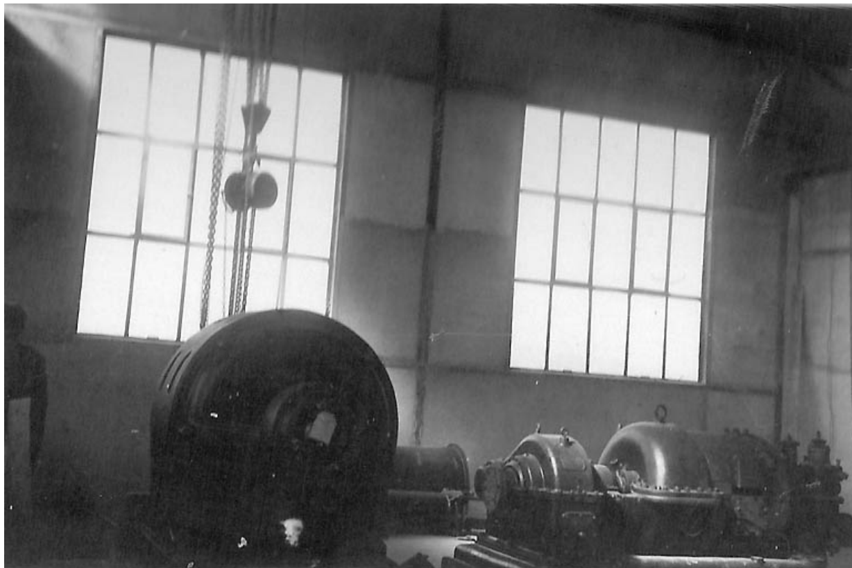
Centrale électrique. La turbine à vapeur.
