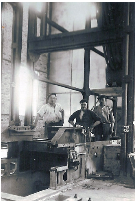
Bâtiment des fours. Montage des grilles automatiques.
