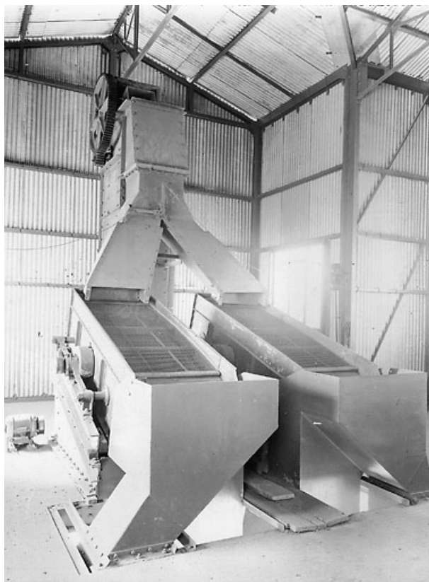
Atelier de concassage. Cribles vibrants. 70, Creveney, lieudit : Prés du Grand Bois
