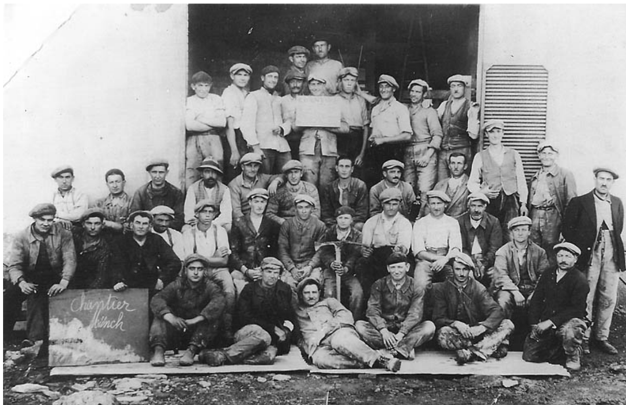
Ouvriers de l'entreprise Cilia [ ?] chantier Münch.
