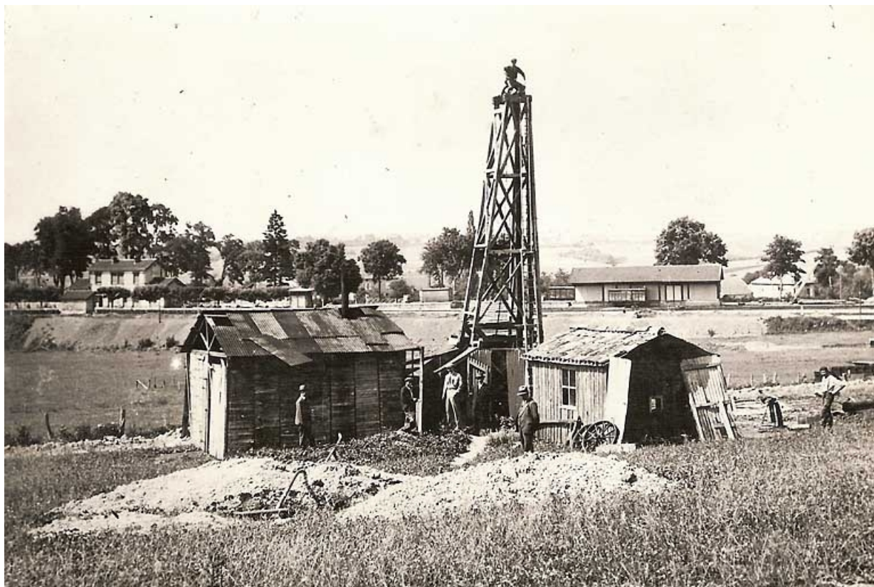
Forage du puits d'eau potable.
