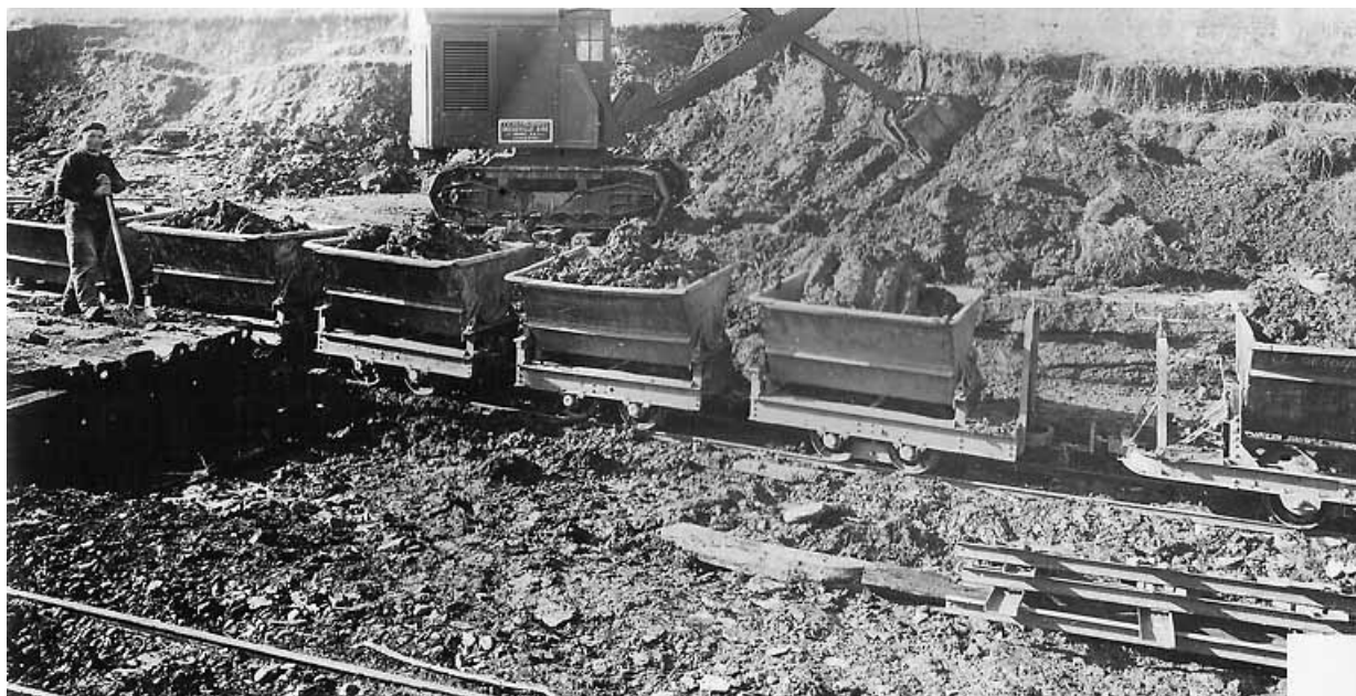
Chargement des wagonnets à la carrière.
