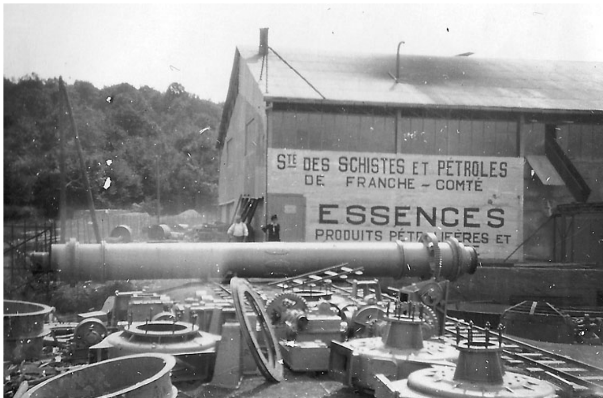
Déchargement du four.
