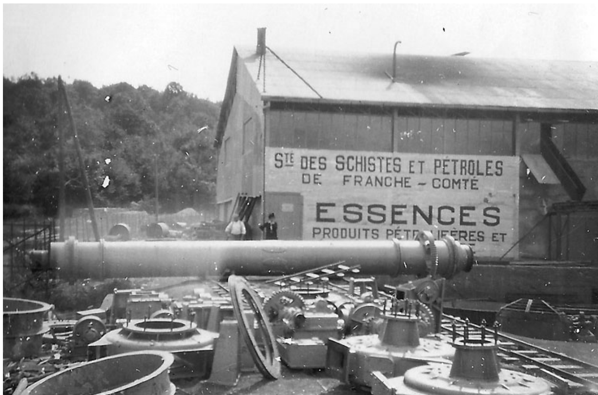
Déchargement du four.
