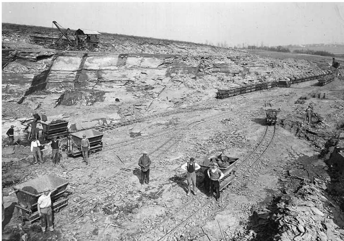
Vue d'ensemble de la carrière en exploitation.
