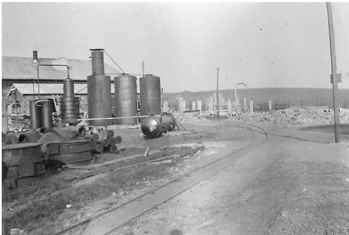
Mise en chantier de la centrale électrique. 70, Creveney, lieudit : Prés du Grand Bois
