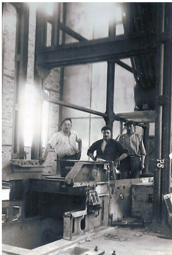
Bâtiment des fours. Montage des grilles automatiques.
