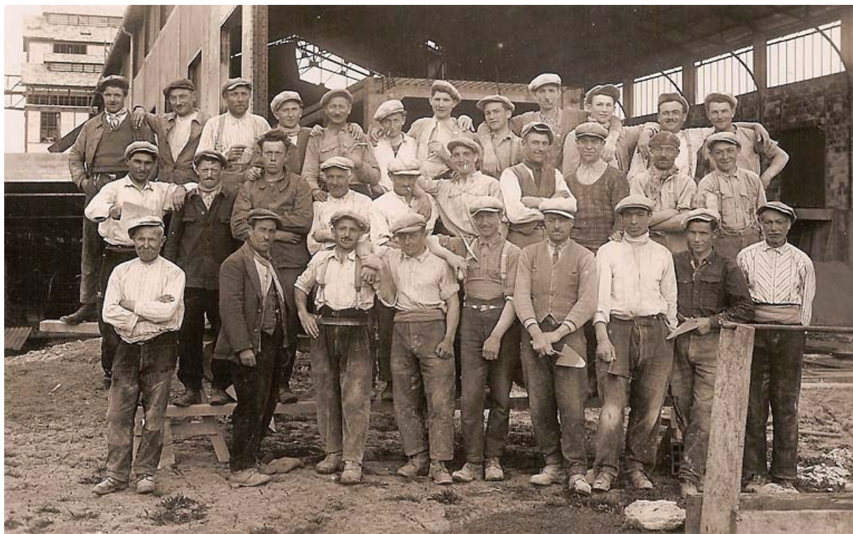
Ouvriers de l'entreprise Cilia [ ?].
