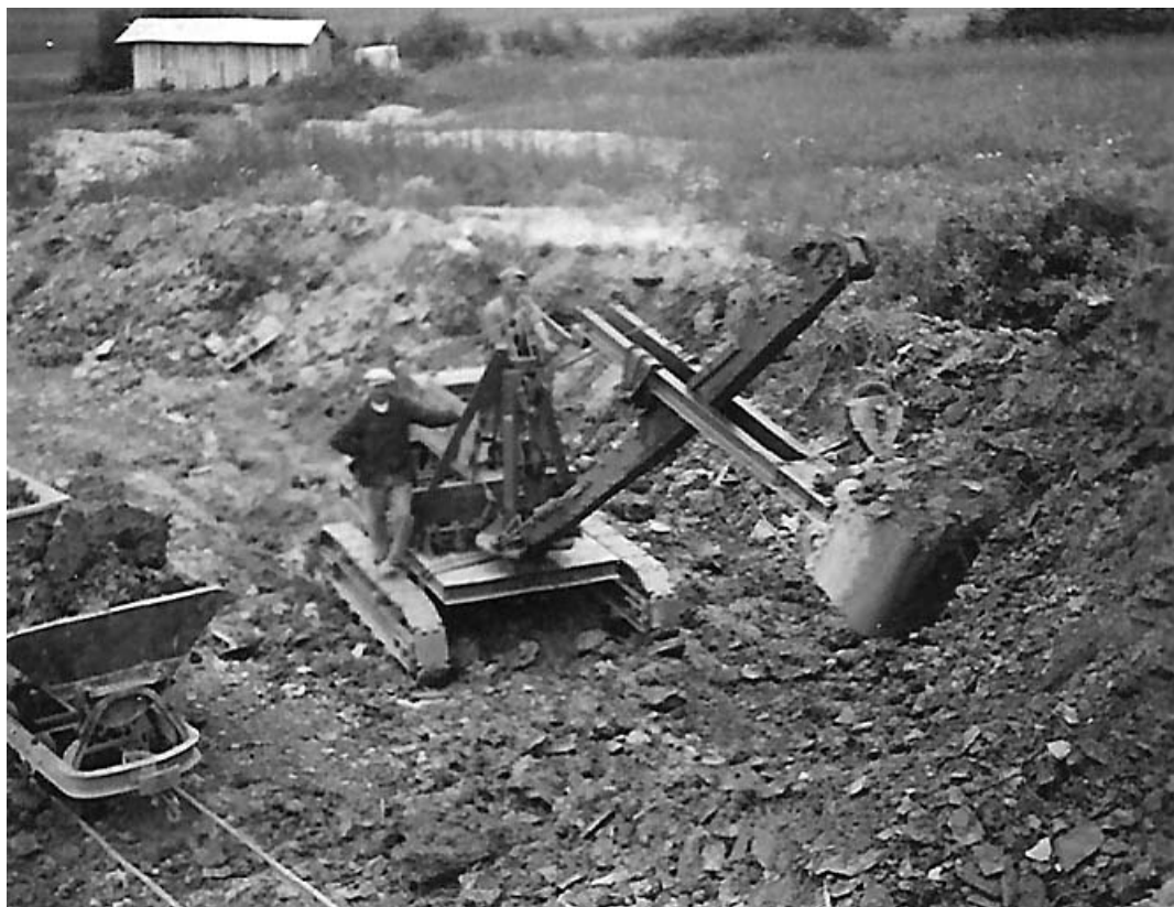
La pelle mécanique. Chargement d'un wagonnet.
