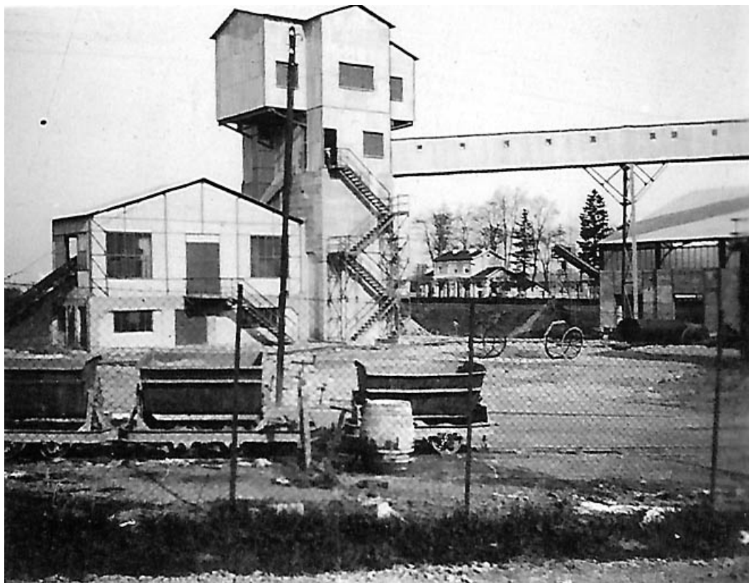
L'ensemble de concassage depuis l'est. 70, Creveney, lieudit : Prés du Grand Bois
