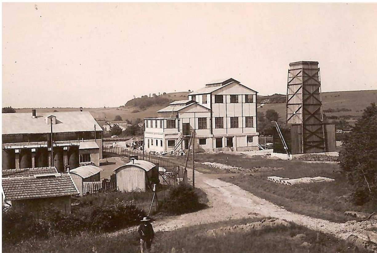
La centrale électrique et la tour de réfrigération.
