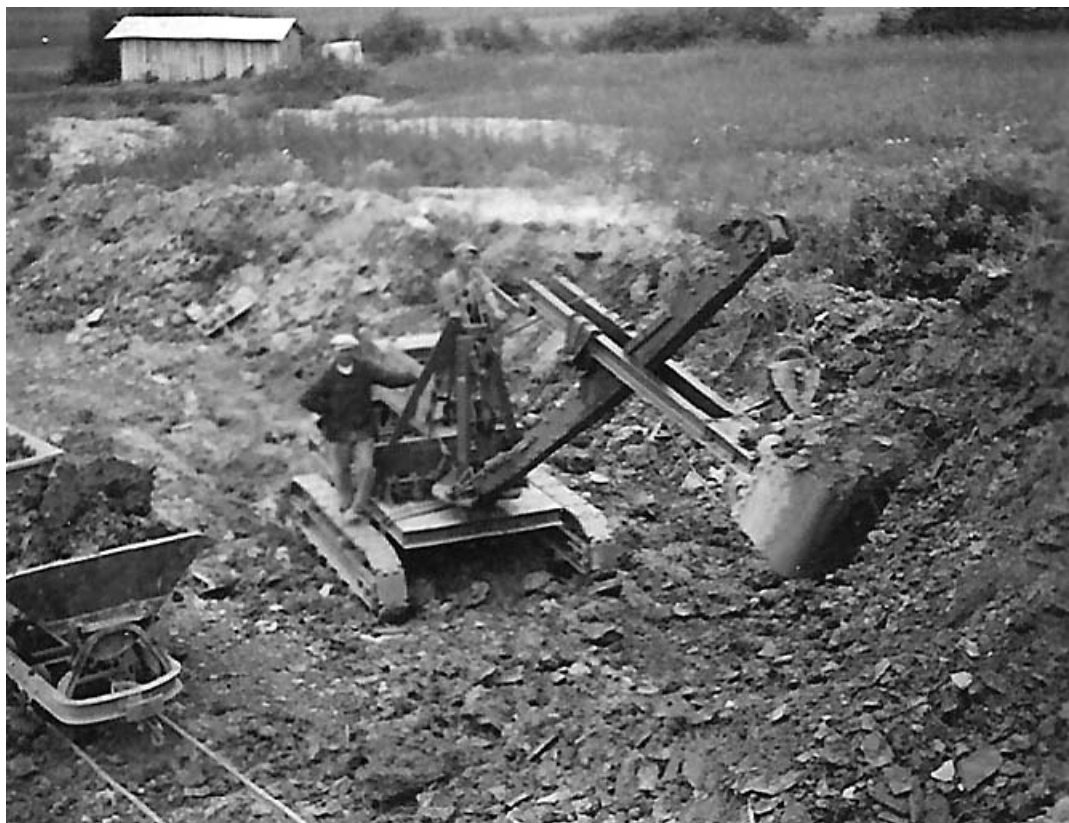
La pelle mécanique. Chargement d'un wagonnet.
