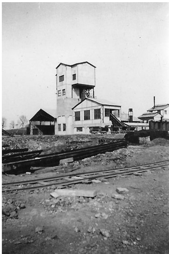
L'ensemble de concassage depuis le sud-ouest.
