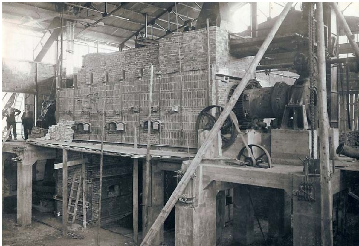
Bâtiment des fours. Four d'essai des schistes.
