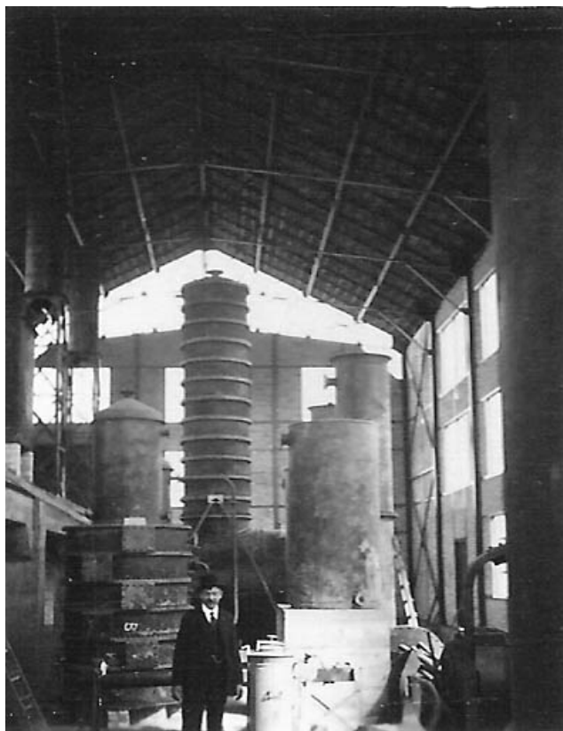
Vue intérieure de la raffinerie.
