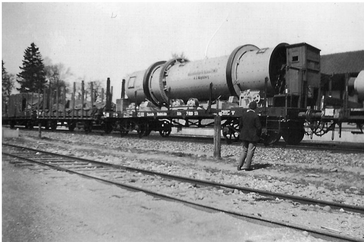
Le séchoir en gare de Creveney.
