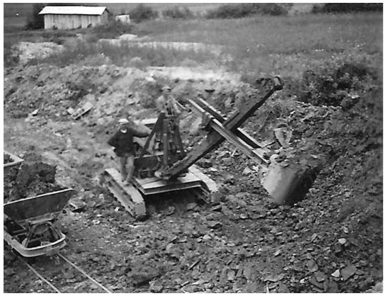
La pelle mécanique. Chargement d'un wagonnet.
