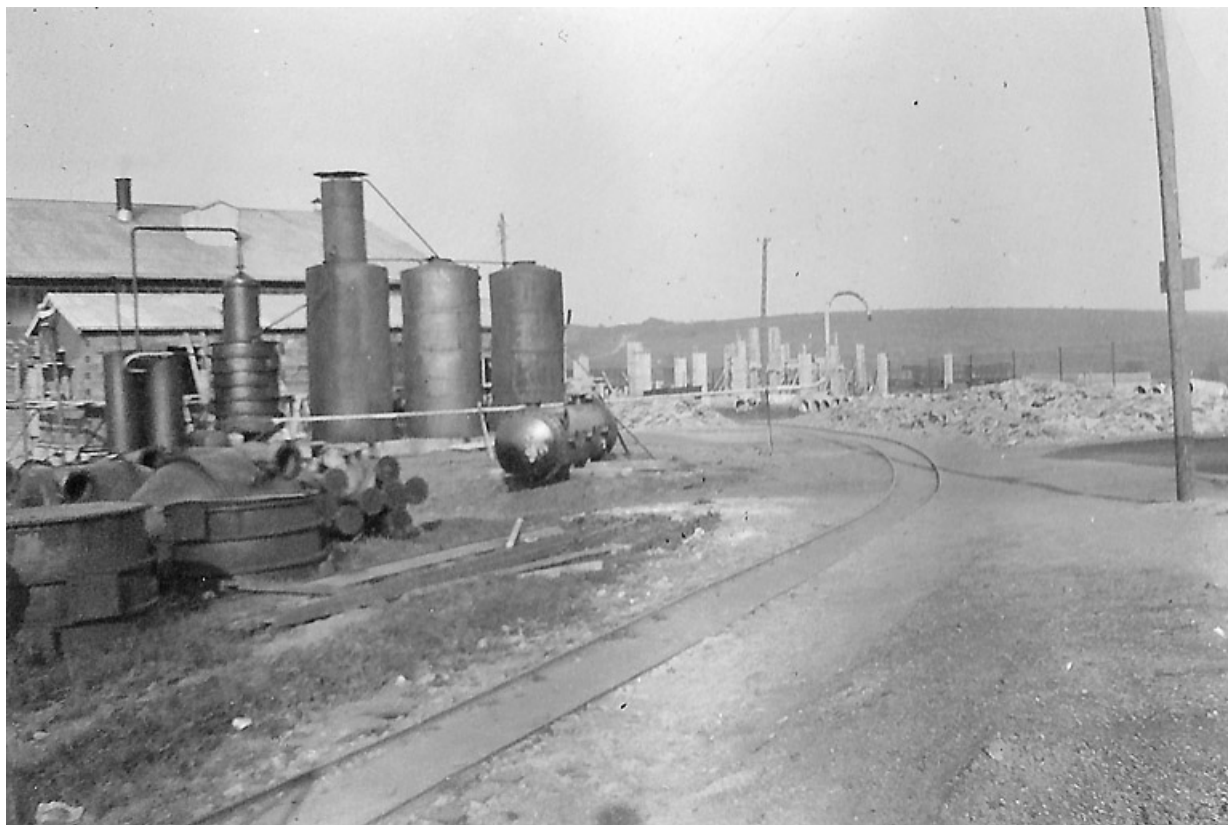
Mise en chantier de la centrale électrique. 70, Creveney, lieudit : Prés du Grand Bois
