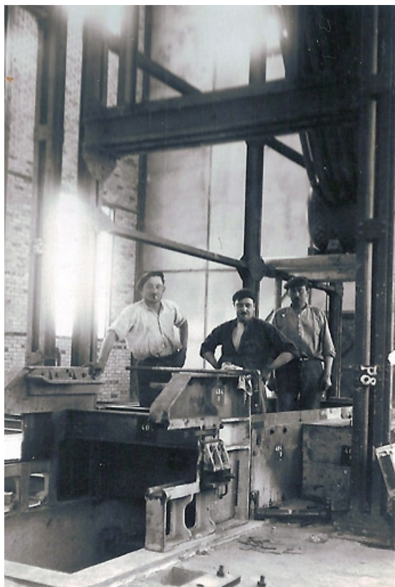
Bâtiment des fours. Montage des grilles automatiques.
