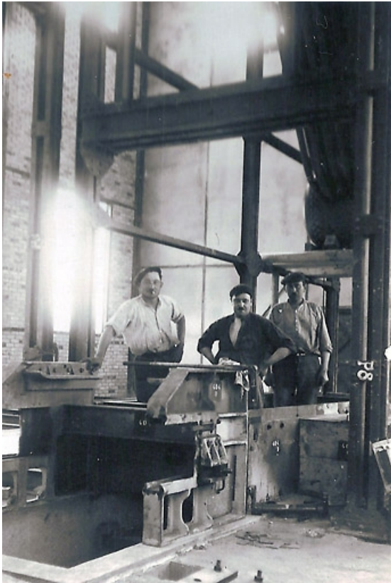
Bâtiment des fours. Montage des grilles automatiques.
