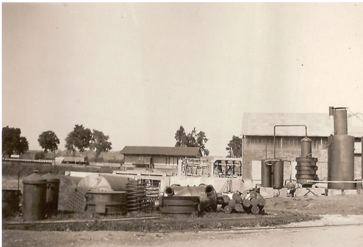
Agrandissement du bâtiment des fours.
