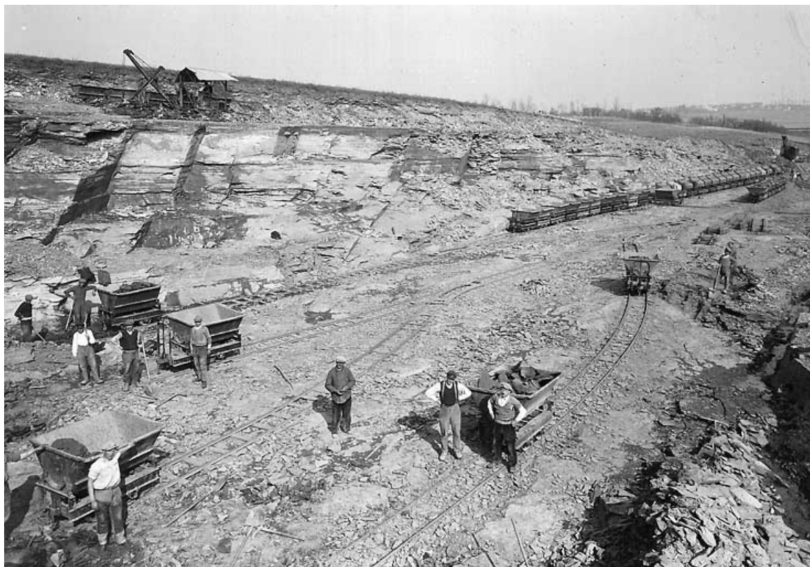
Vue d'ensemble de la carrière en exploitation.
