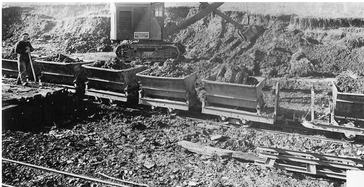
Chargement des wagonnets à la carrière.
