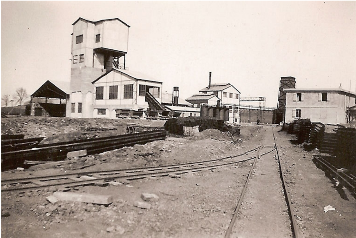
L'ensemble de concassage et la centrale électrique depuis l'ouest.
