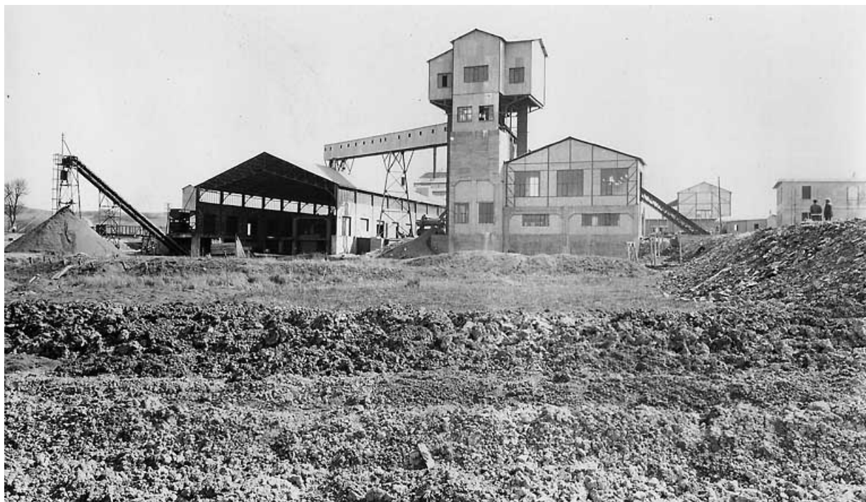
Vue d'ensemble depuis l'ouest.
