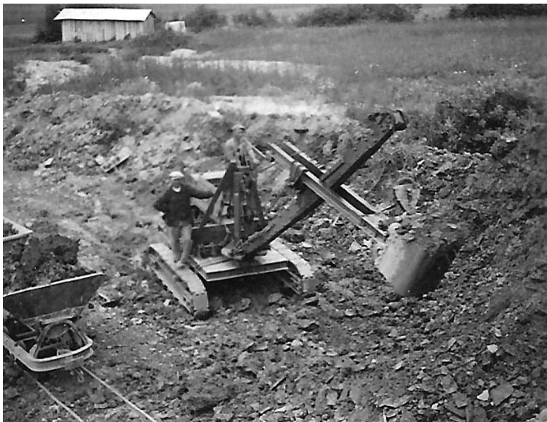
La pelle mécanique. Chargement d'un wagonnet.
