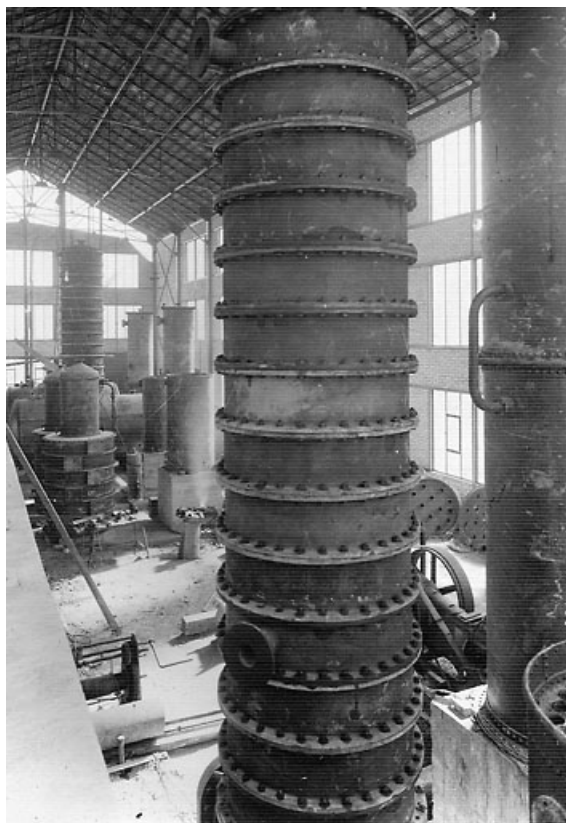
Intérieur de la raffinerie. Colonnes de distillation.
