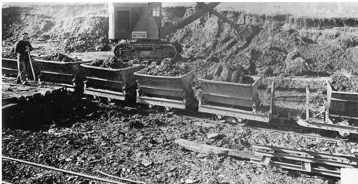
Chargement des wagonnets à la carrière.
