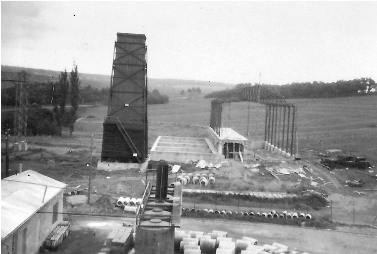
Tour de réfrigération et raffinerie en construction.
