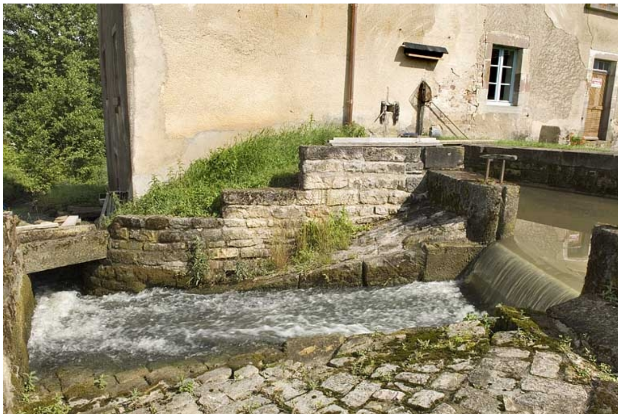
Le vannage et la chaussée du bief de dérivation.
