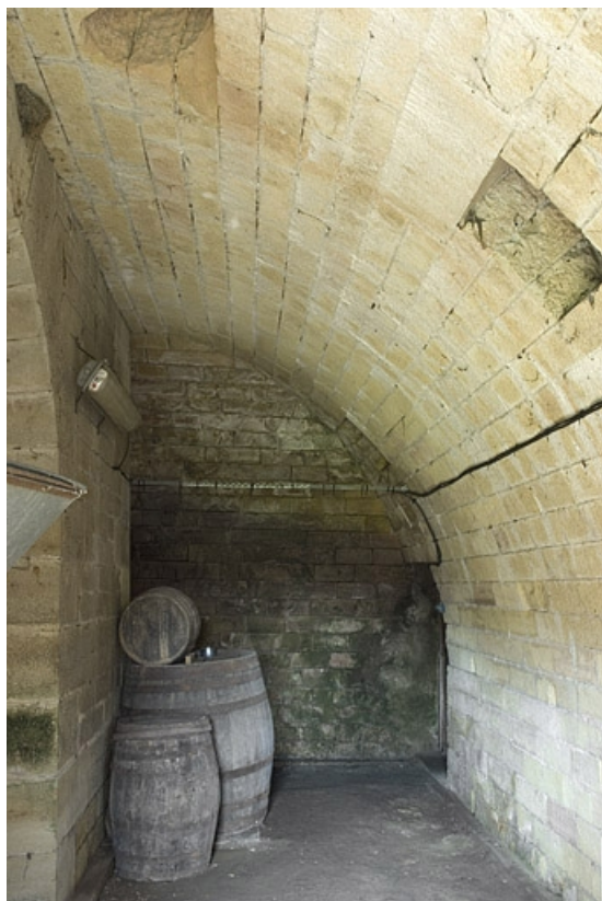
Couloir de circulation voûté d'un demi-berceau.
