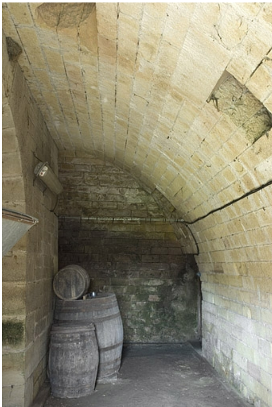
Couloir de circulation voûté d'un demi-berceau.
