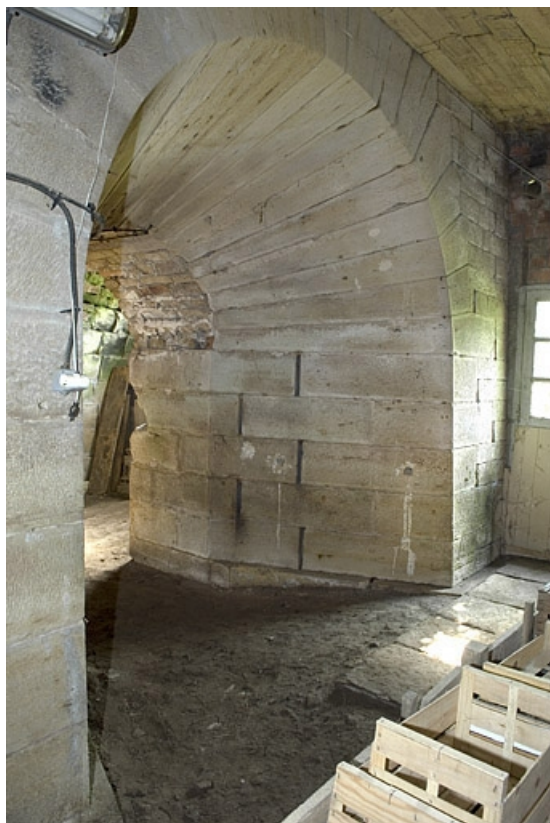
Détail d'une embrasure et de son appareillage.
