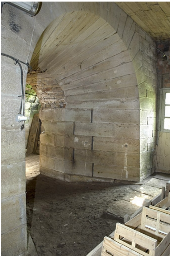
Détail d'une embrasure et de son appareillage.
