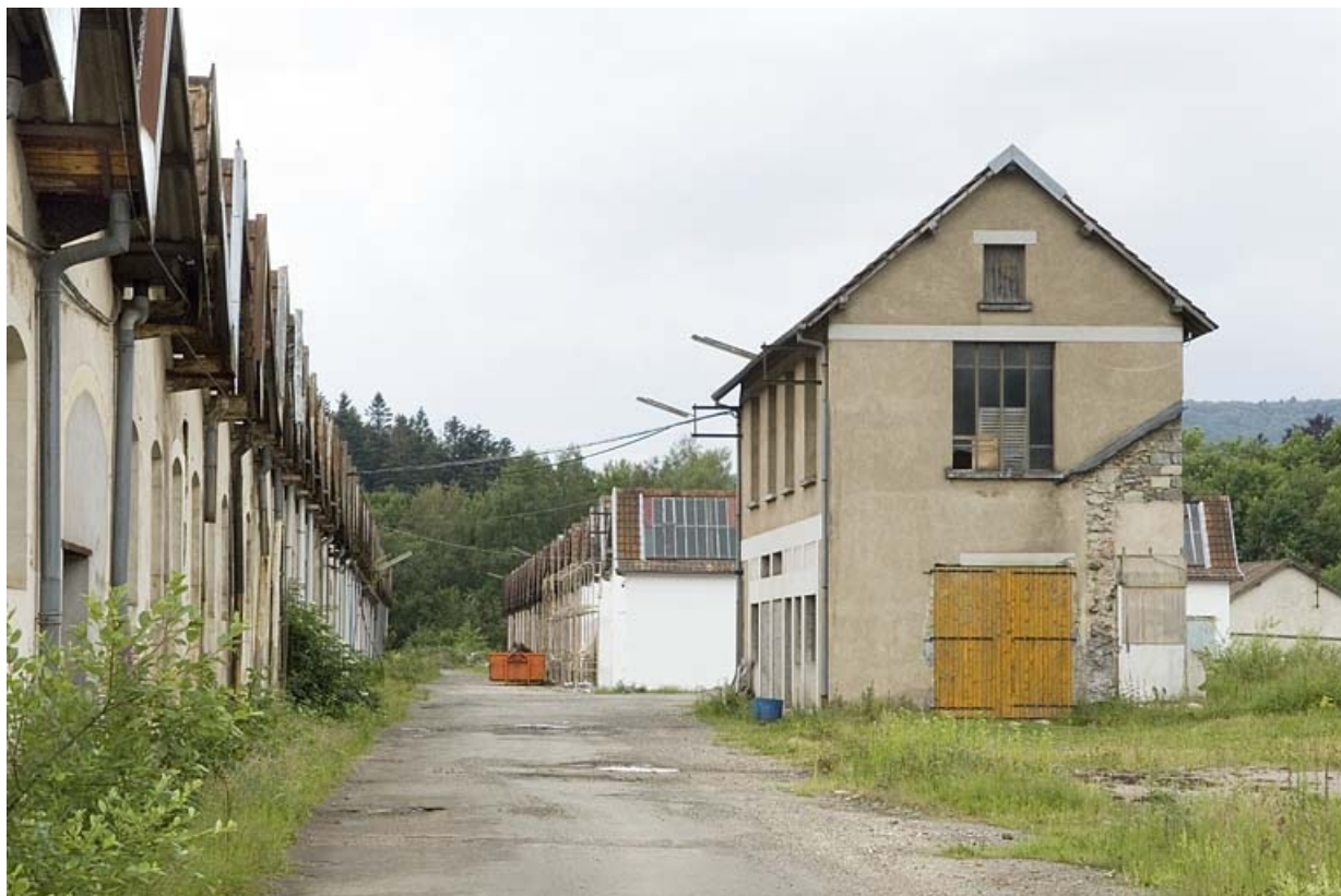
Ateliers de fabrication et transformateur depuis le nord-est. 70, Plancher-les-Mines rue du Pont du Var
