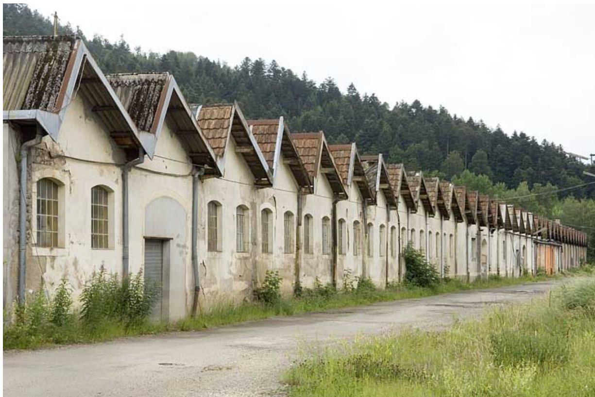
Atelier de fabrication. Alignement de pignons de sheds. 70, Plancher-les-Mines rue du Pont du Var
