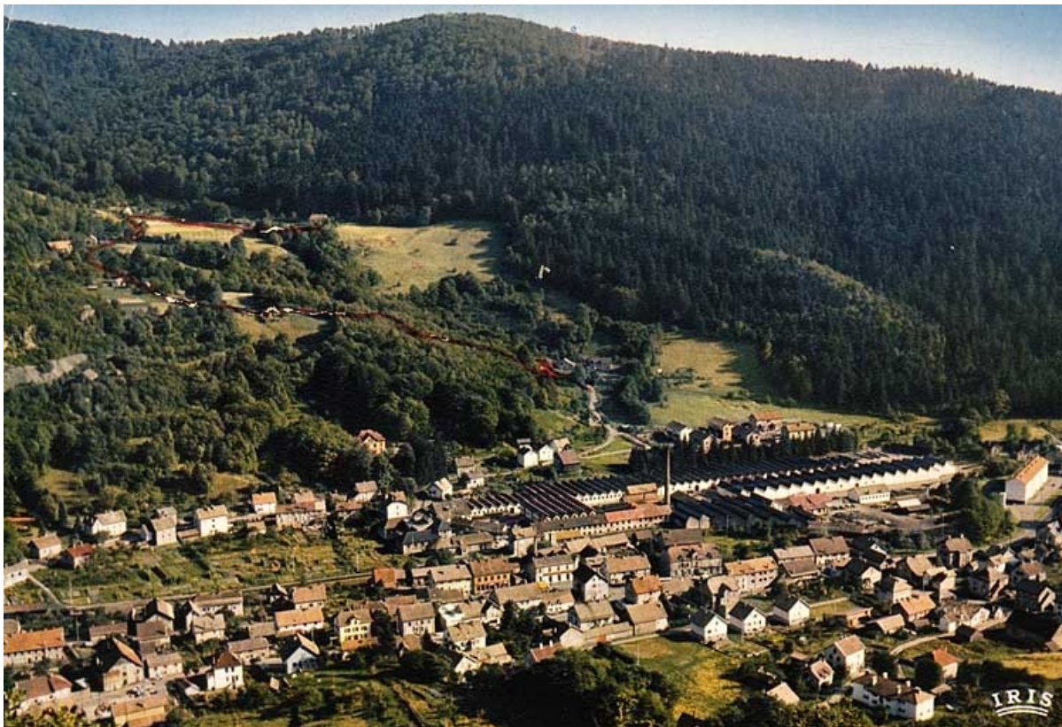
Plancher-les-Mines (Haute-Saône). Vue générale.
