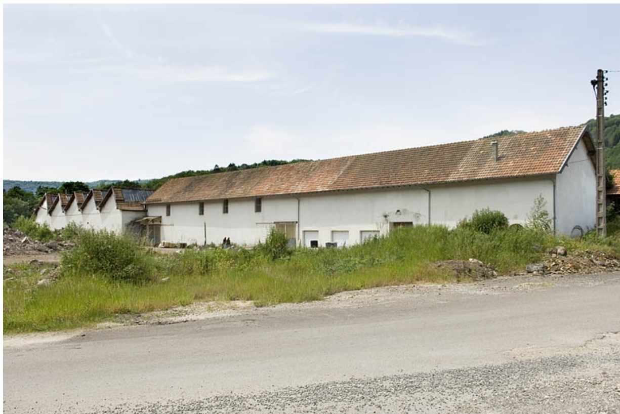
Atelier de fabrication (boulonnerie) depuis l'est. 70, Plancher-les-Mines rue du Pont du Var
