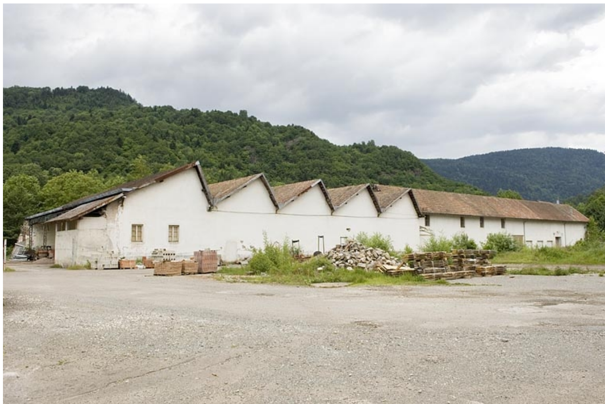
Atelier de fabrication (boulonnerie) depuis le sud.
