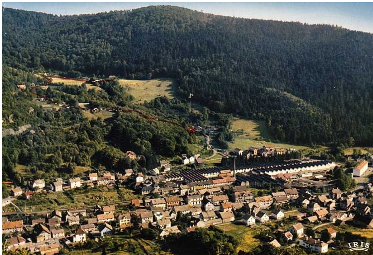
Plancher-les-Mines (Haute-Saône). Vue générale.
