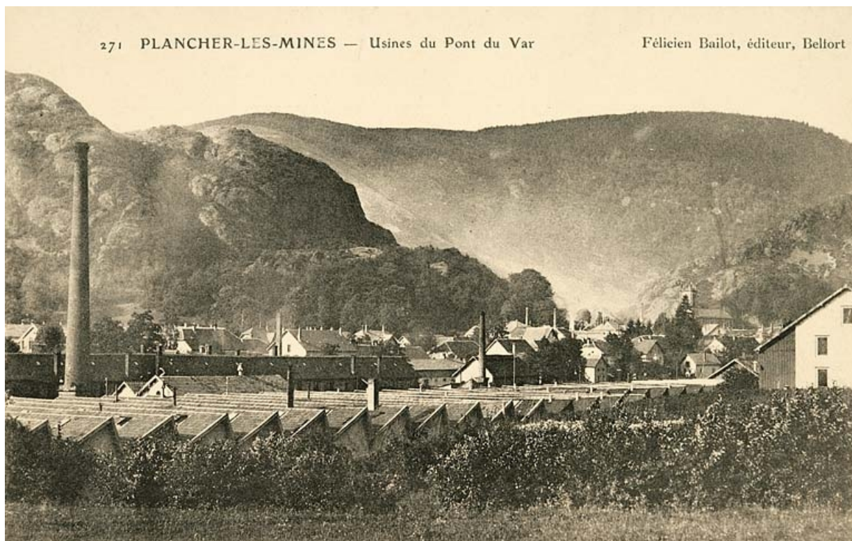
Plancher-les-Mines - Usines de Pont du Var.
