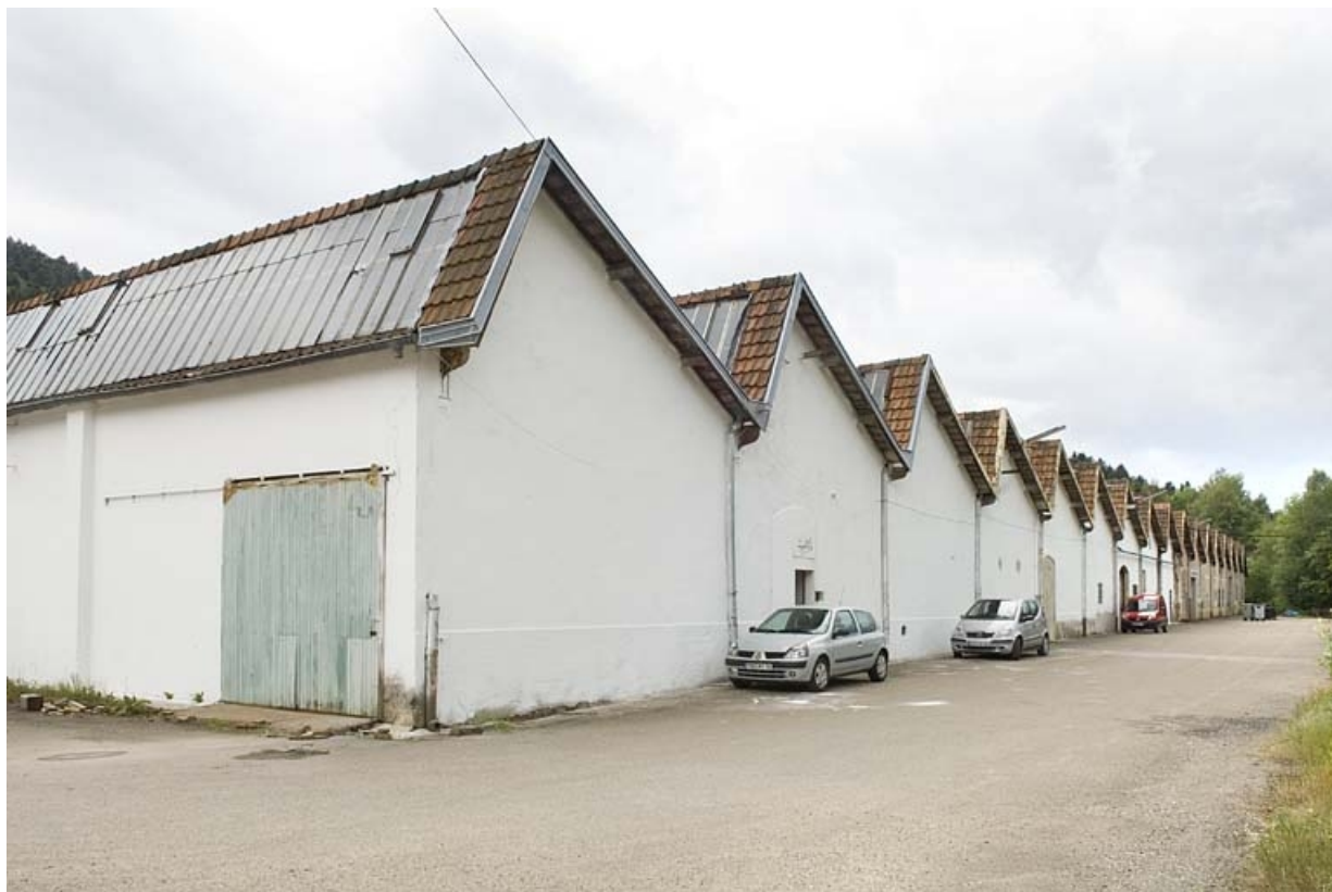
Atelier de fabrication ouest. Enfilade de pignons de sheds.
