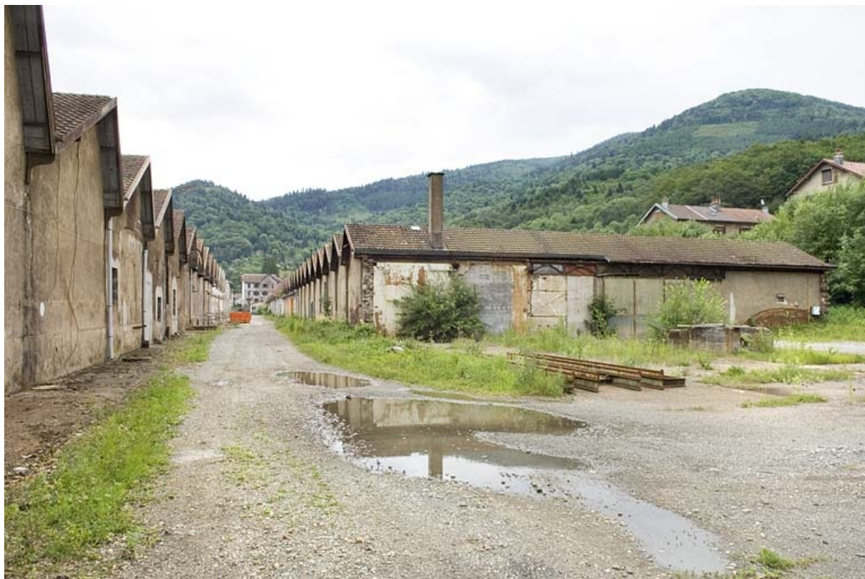
Ateliers de fabrication depuis le sud-ouest. 70, Plancher-les-Mines rue du Pont du Var
