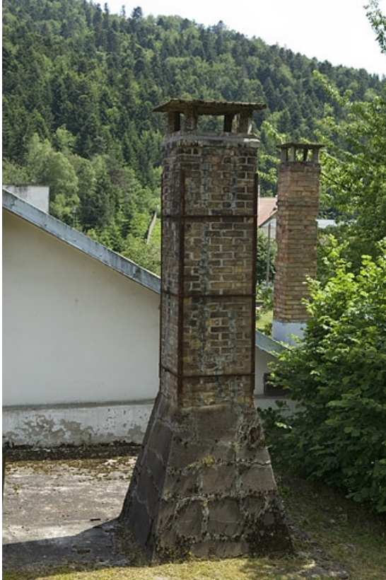
Détail d'une cheminée.
