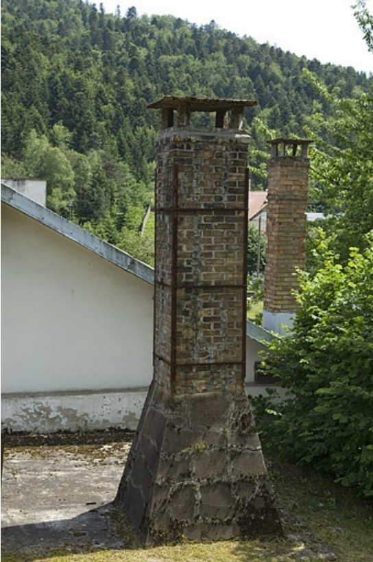
Détail d'une cheminée.
