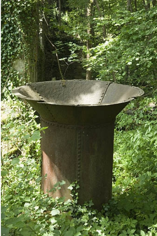
Couronnement métallique d'une cheminée en tôle.
