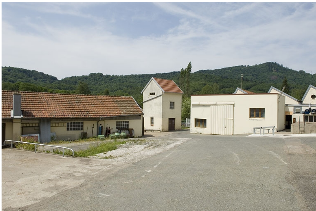
Magasin industriel et transformateur vus depuis le sud.
