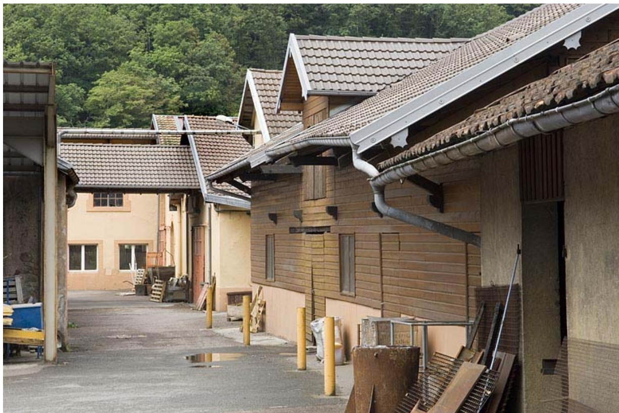
Ateliers de fonderie nord depuis la cour est. 70, Plancher-Bas, 56 rue Louis Pasteur
