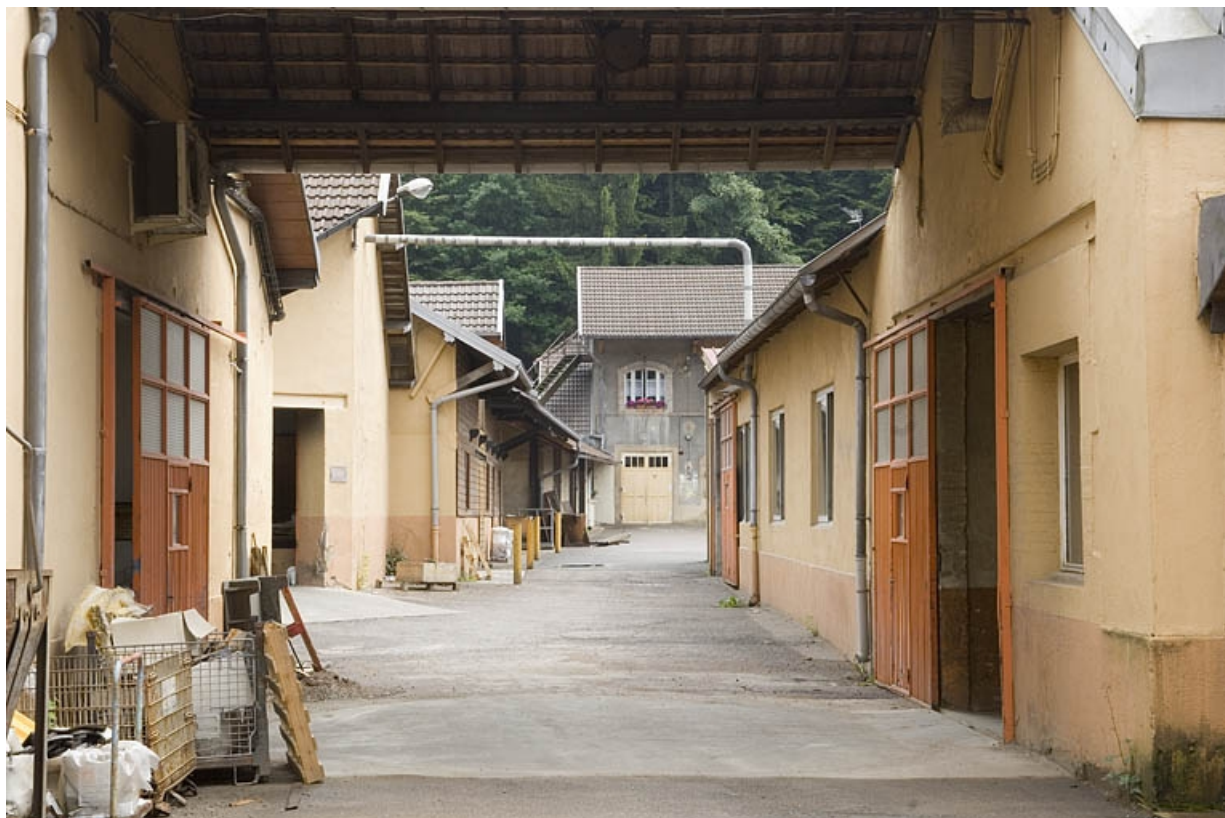
Passage couvert entre les ateliers nord et sud.
