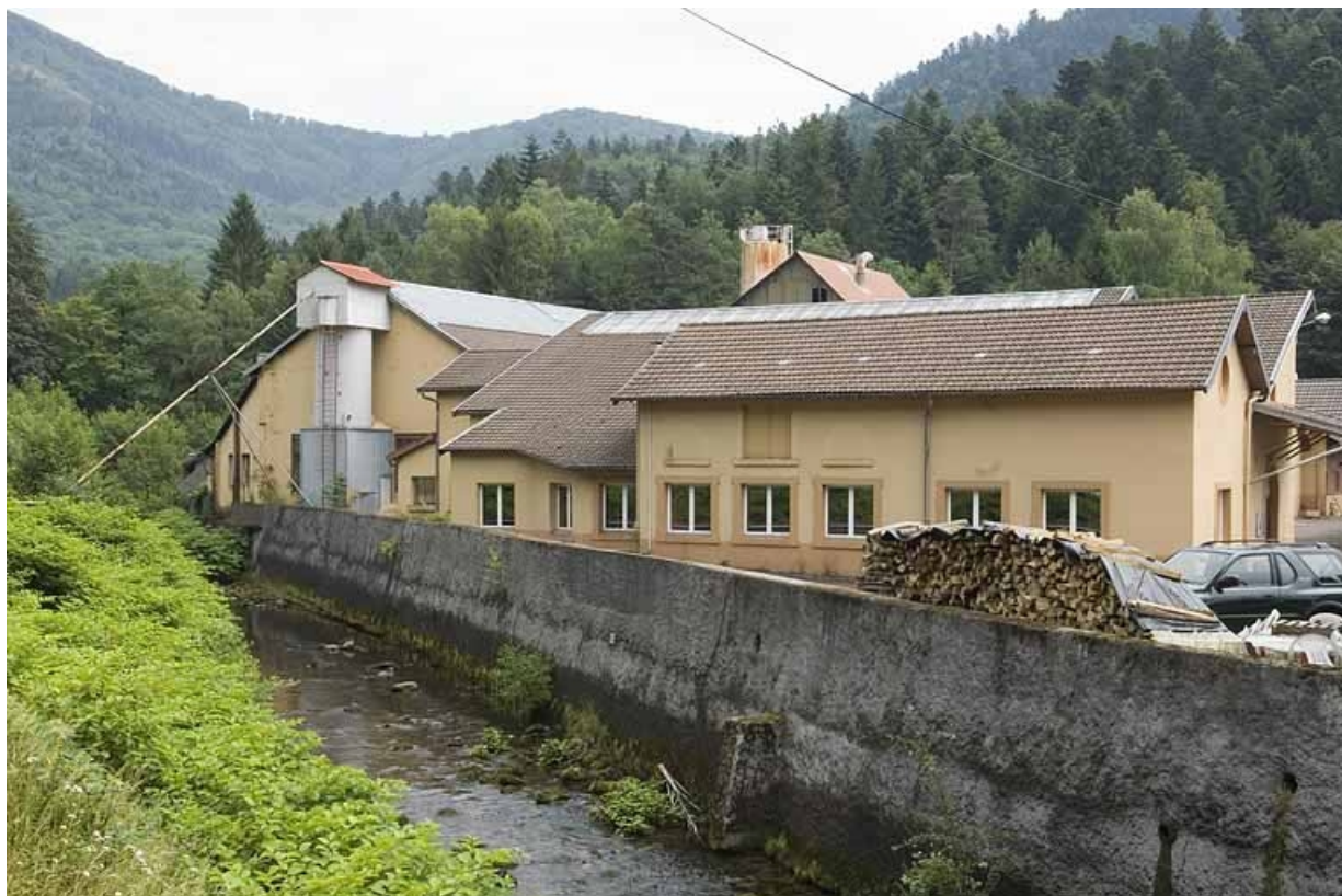
Ateliers nord depuis la rive droite du Rahin 70, Plancher-Bas, 56 rue Louis Pasteur
