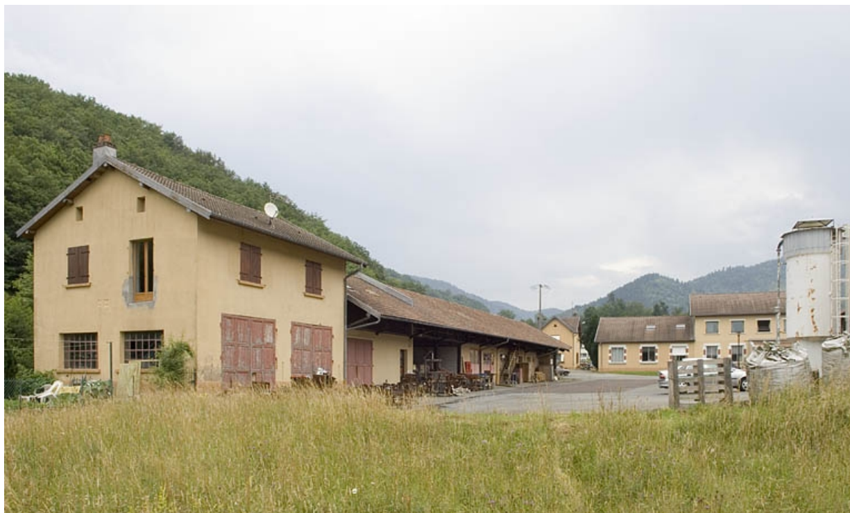
Logement, atelier de modelage, conciergerie et bureaux depuis le sud.
