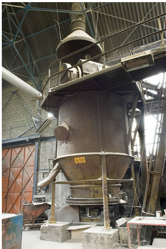
Équipement pour la préparation du sable de fonderie.
