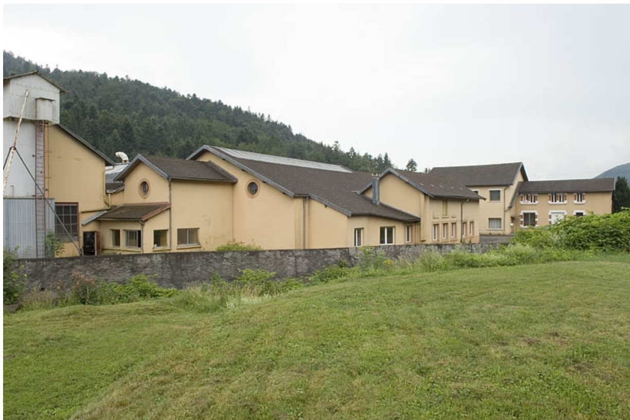
Ateliers de fabrication depuis le nord.
