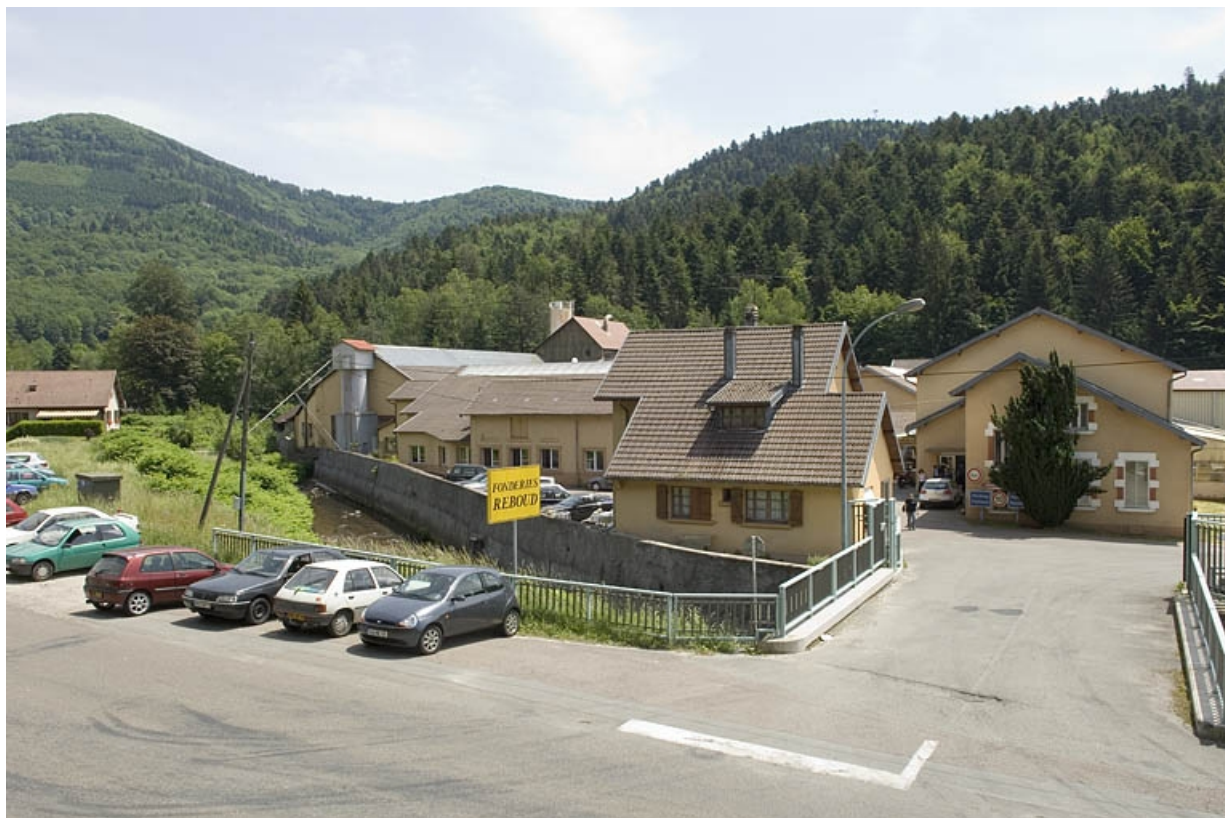
Partie nord de l'usine depuis l'entrée.
