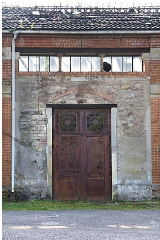
Façade antérieure. Détail d'une travée.
