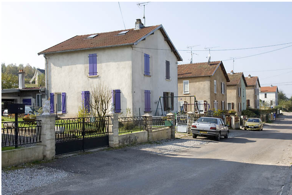
Alignement de maisons au sud de la rue Jean Jaurès.
