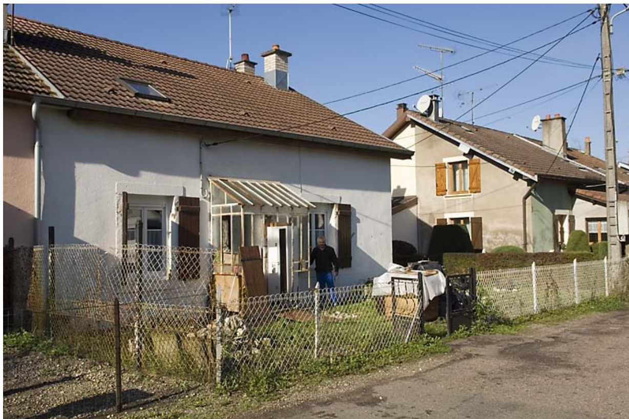
Façade est d'une maison.
