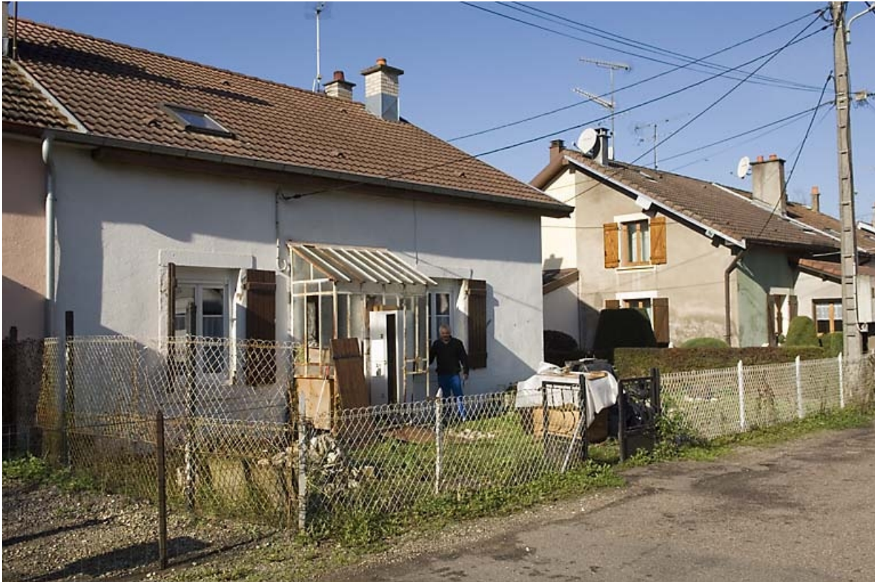
Façade est d'une maison.
