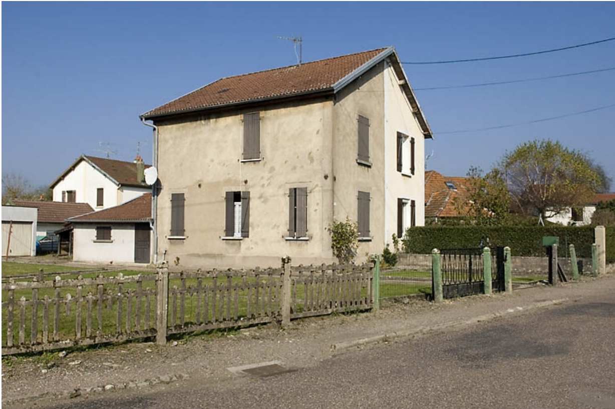
Maison double à étage (rue Jean Jaurès). 70, Ronchamp, lieudit : le Morbier
