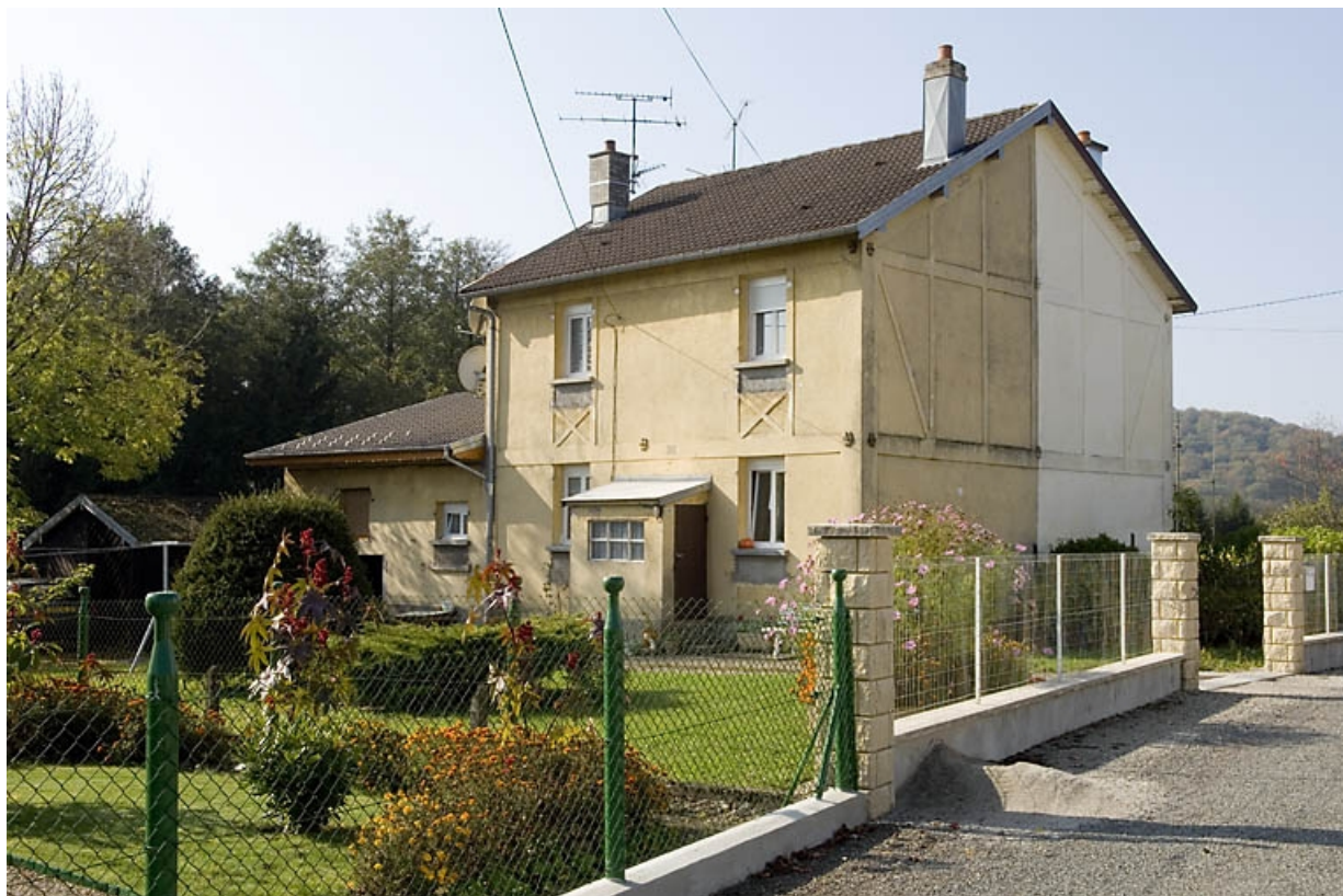
Maison double à étage. Vue de trois quarts. 70, Ronchamp, lieudit : le Morbier
