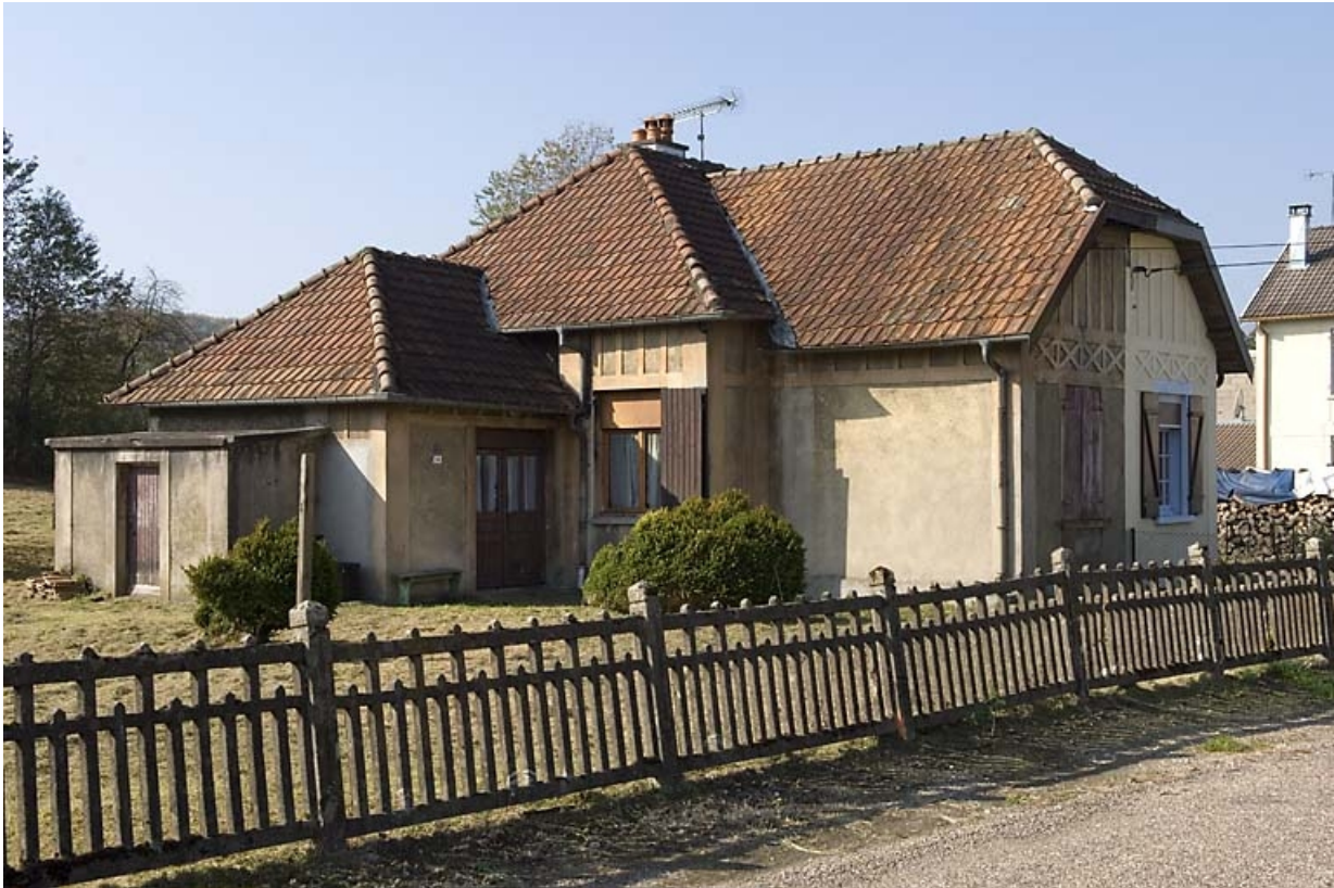
Maison double en rez-de-chaussée. Vue de trois quarts.
