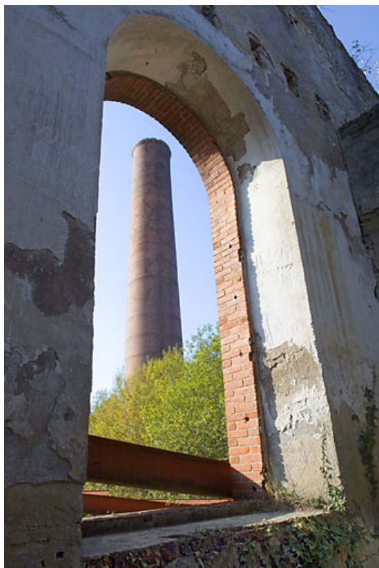
La cheminée depuis une ouverture du bâtiment des bureaux.
