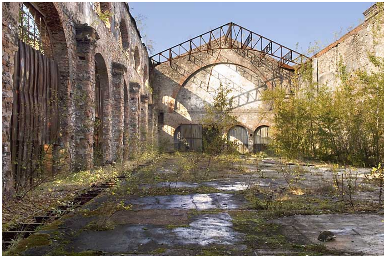
Intérieur de la salle des machines à vapeur.
