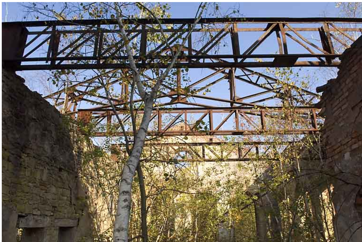
Bâtiment des bureaux et de la lampisterie : éléments de la charpente métallique.
