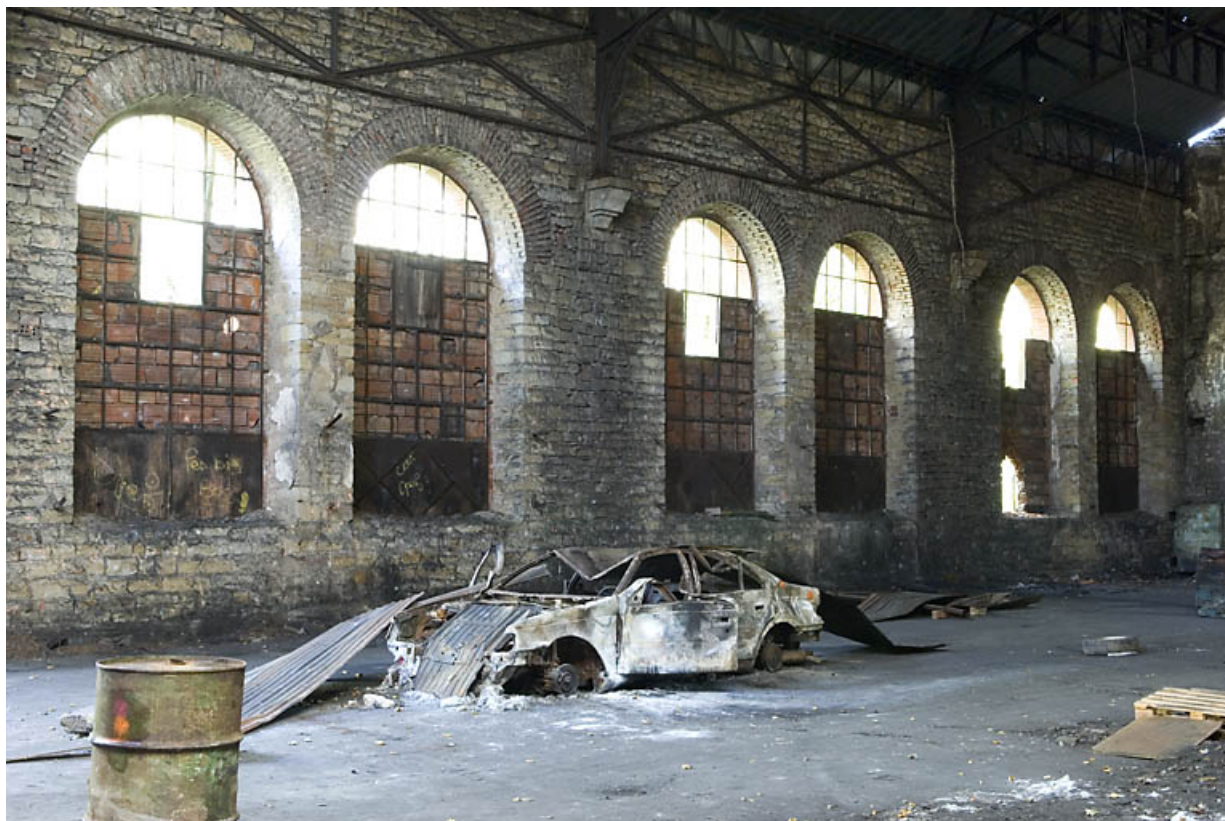
Mur nord du bâtiment des vestiaires.
