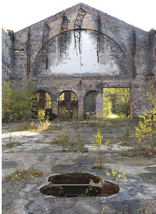
Face interne du pignon est de la salle des machines.
