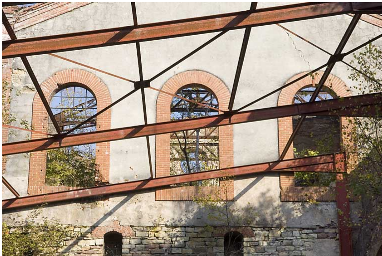
Pignon sud du bâtiment des bureaux et de la lampisterie.
