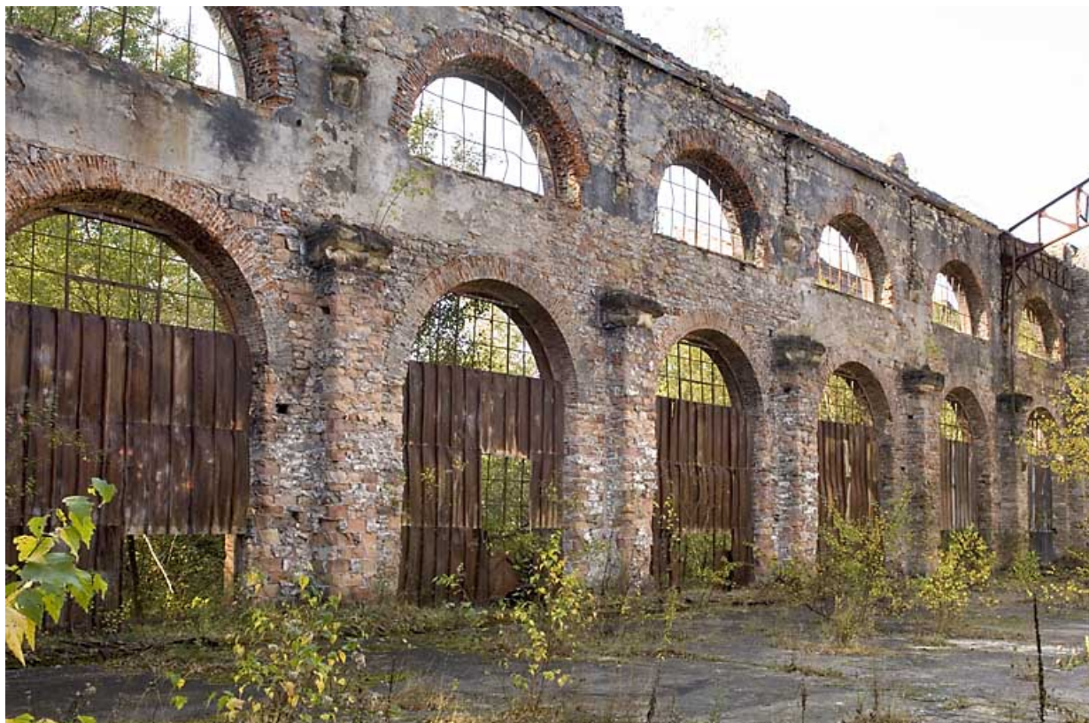
Détail du mur sud de la salle des machines.
