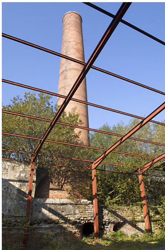
La cheminée vue depuis la salle des chaudières.
