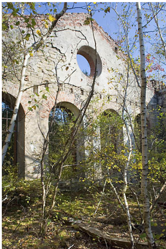
Bâtiment des bureaux et de la lampisterie : vue intérieure.
