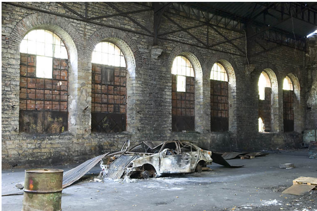
Mur nord du bâtiment des vestiaires.
