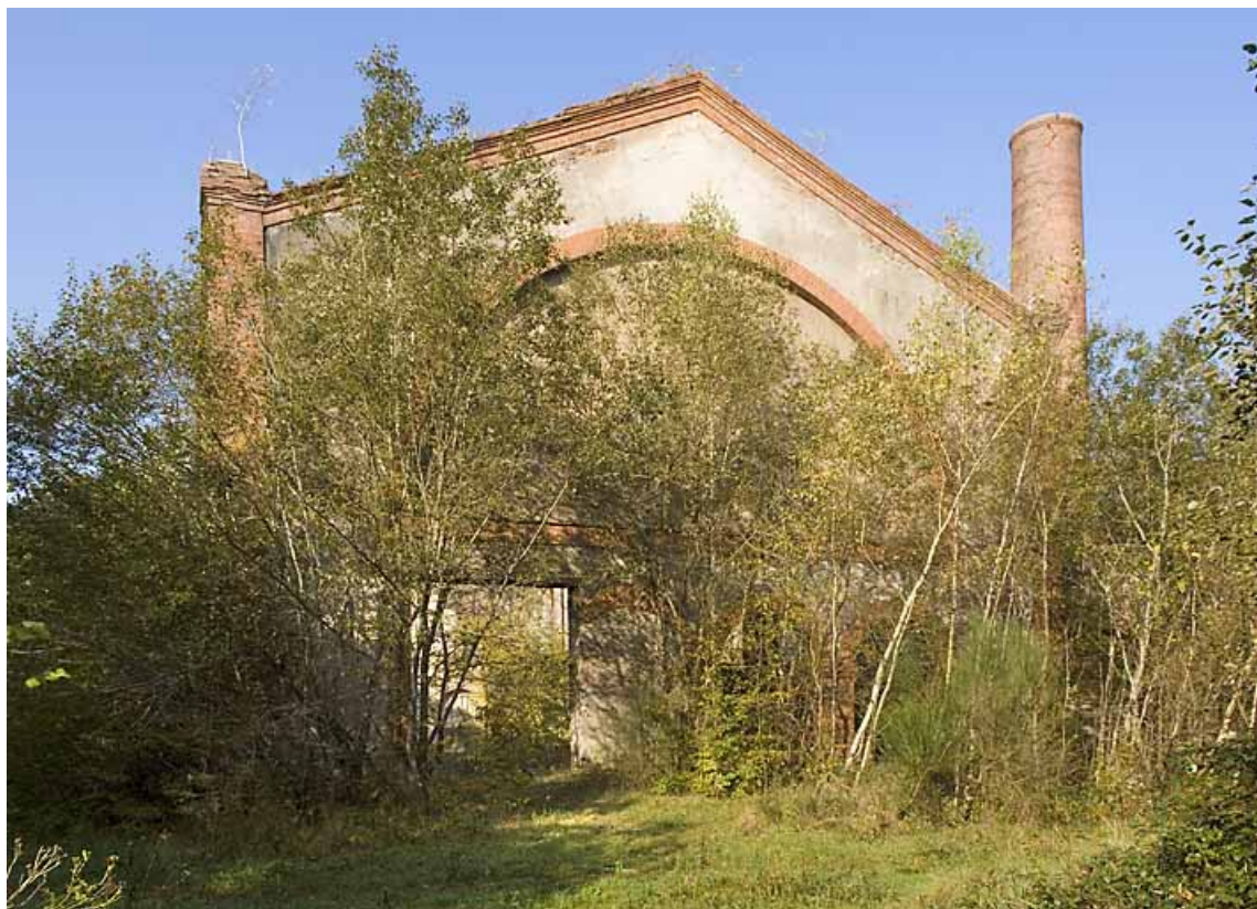
Pignon oriental de la salle des machines à vapeur.
