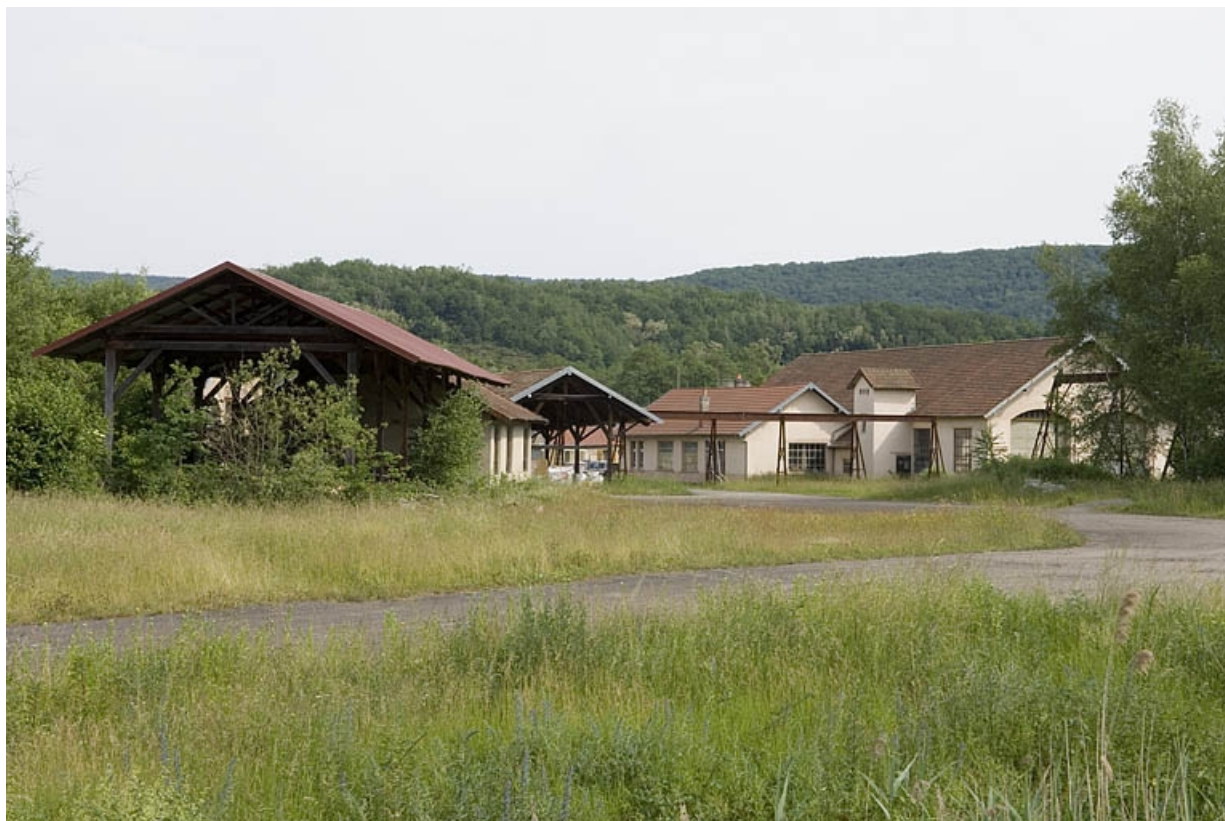
Vue d'ensemble depuis le sud.
