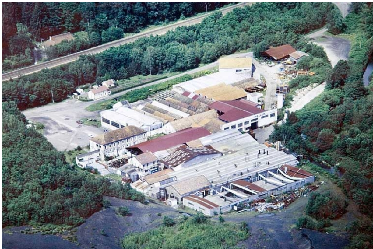
Vue aérienne depuis le sud-ouest vers 1985.
