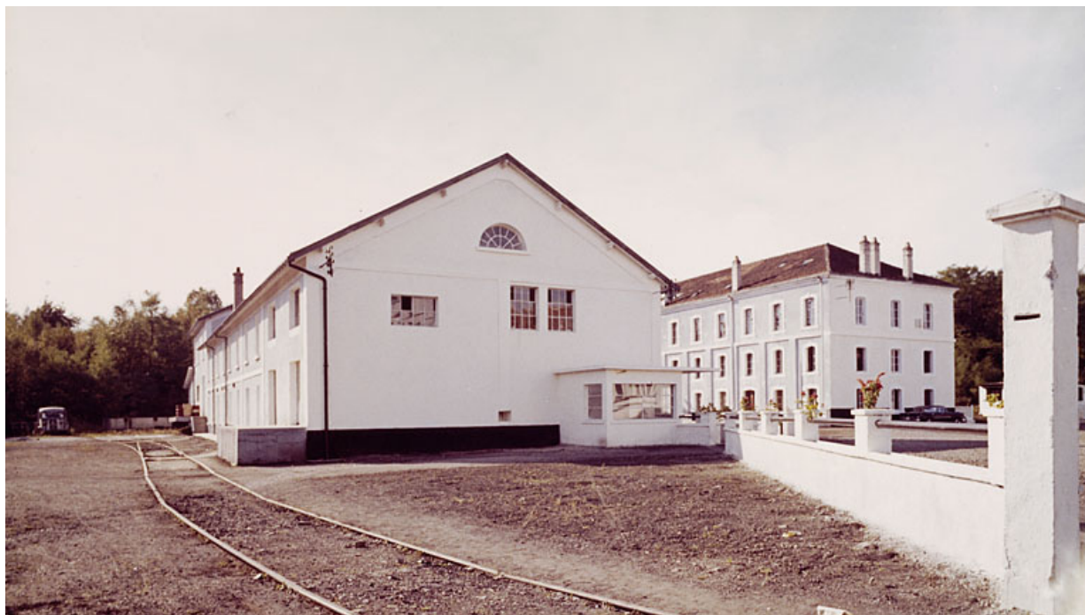
Usine Maglum. Vue d'ensemble depuis l'est.
