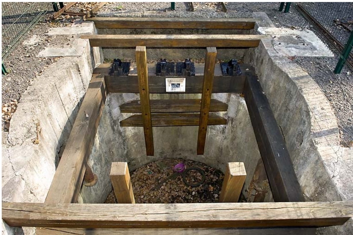
Vestige du puits de l'Etançon (colmaté).
