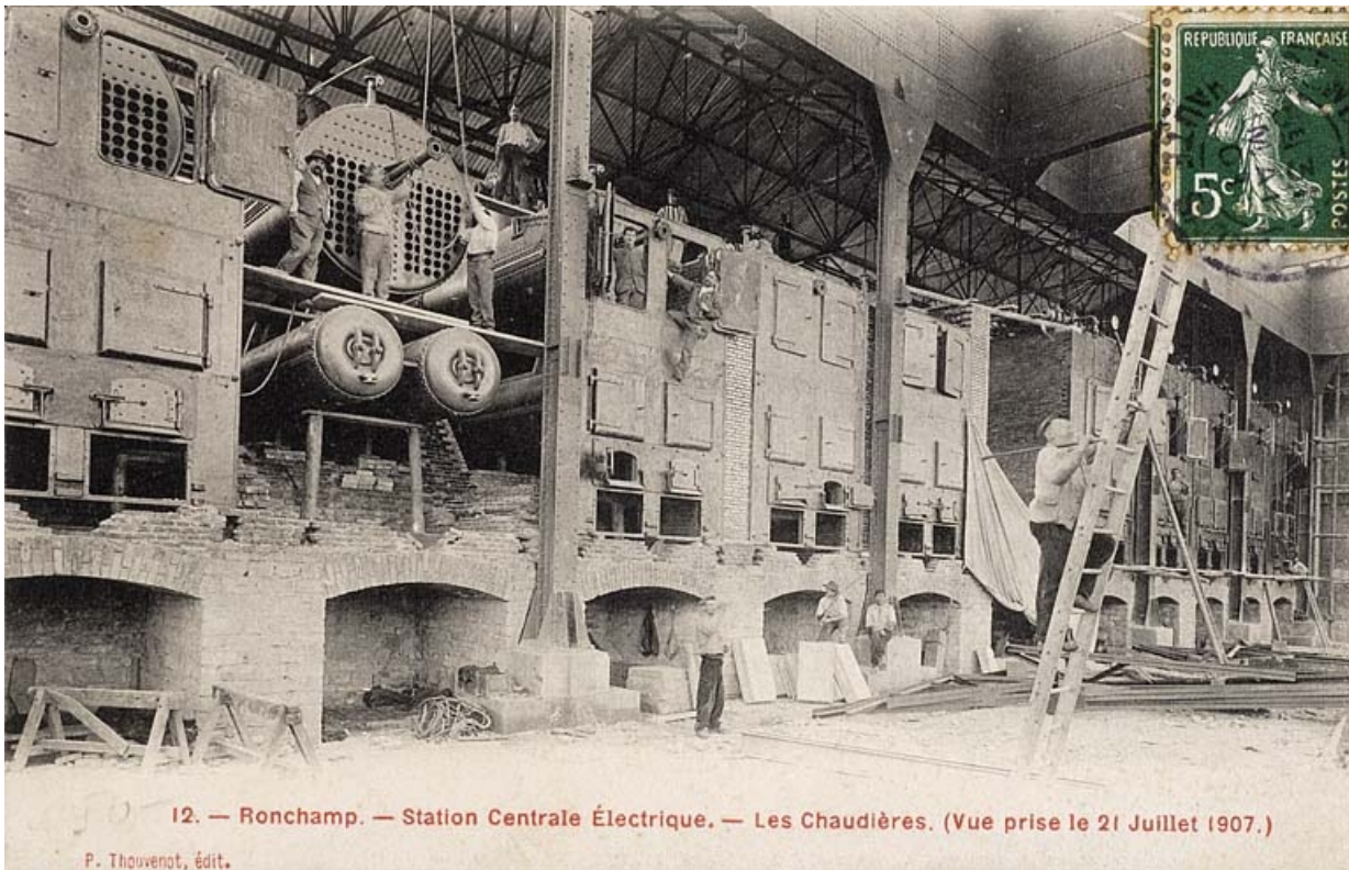
Ronchamp. - Station Centrale électrique. Les chaudières (vue prise le 21 juillet 1907).
