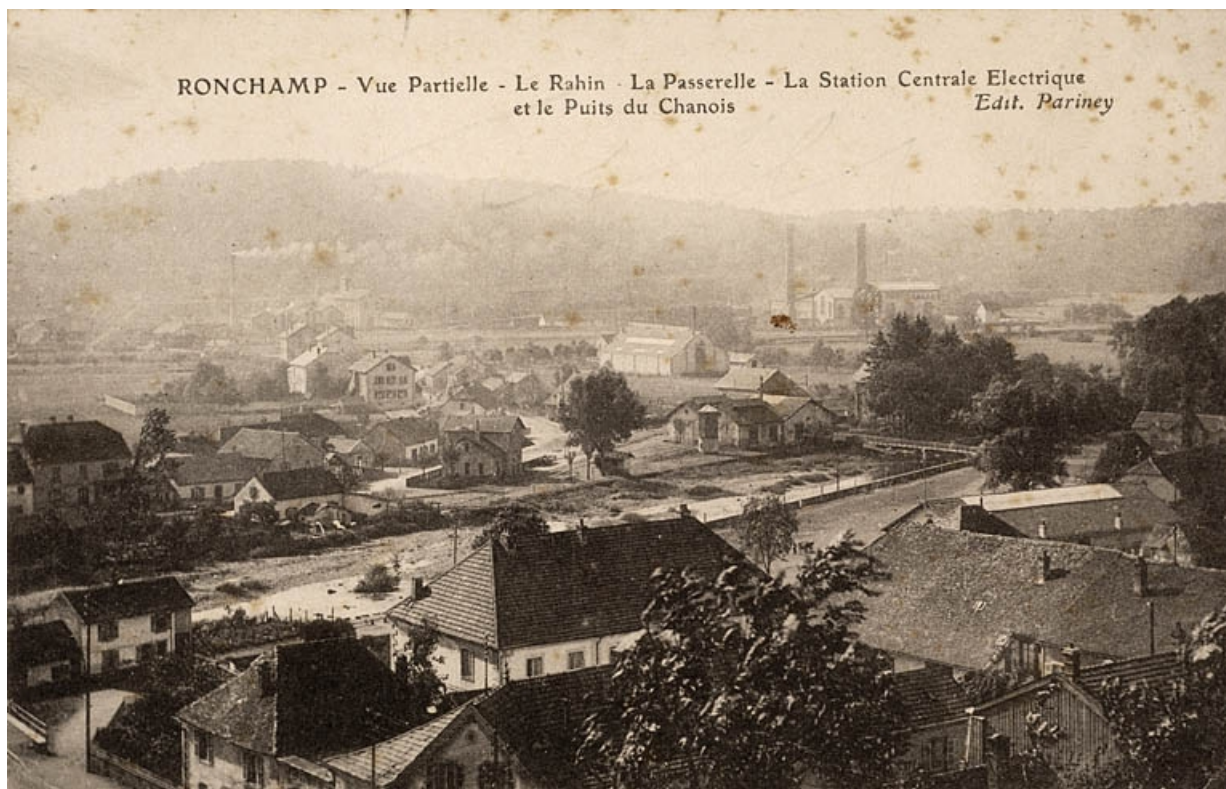
Ronchamp - Vue partielle - Le Rahin - La passerelle - La Station électrique et le puits du Chânois.
