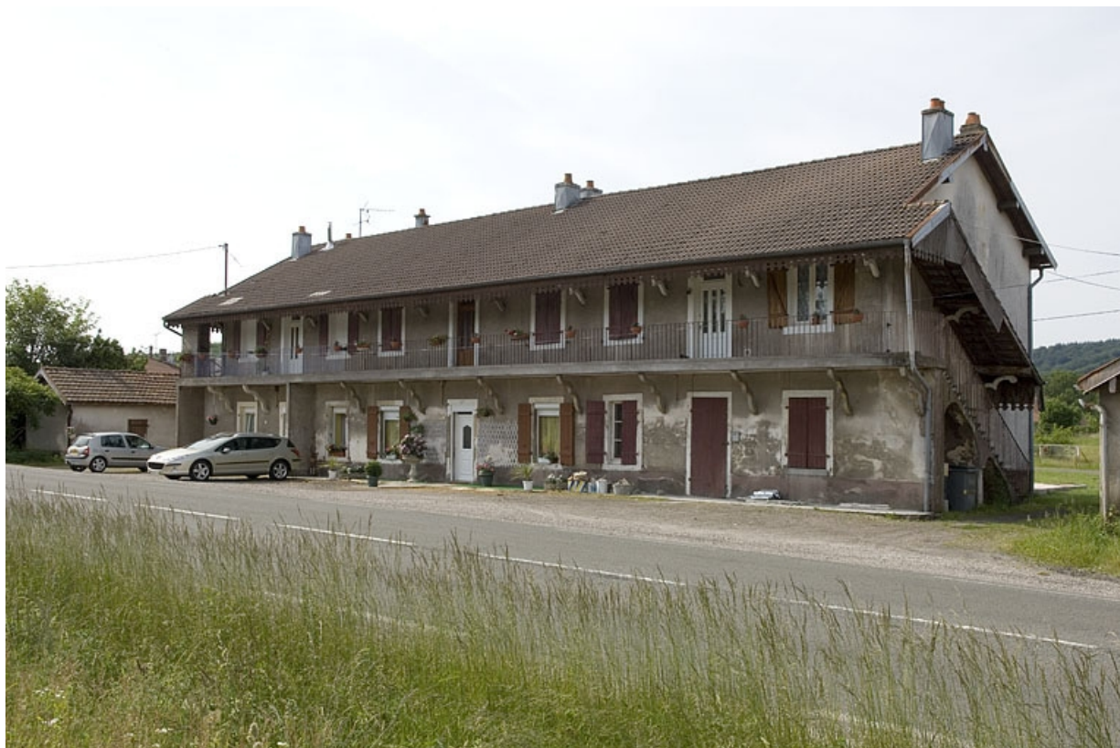
Logement d'ouvriers, dit caserne des Fressais (27 avenue de France). 70, Ronchamp, 17 rue de l' Industrie
