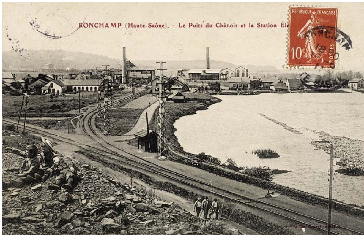
Ronchamp (Haute-Saône). Le puits du Chanois et la station électrique.
