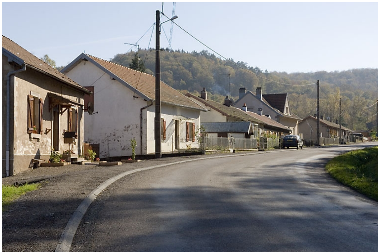
Logements ouvriers du Magny. Vue d'ensemble (commune de Magny-d'Anigon). 70, Ronchamp, 17 rue de l' Industrie
