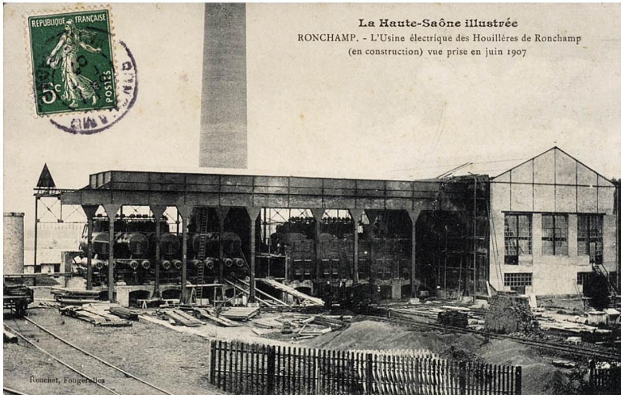
La Haute-Saône illustrée. Ronchamp. - L'usine électrique des Houillères de Ronchamp (en construction) vue prise en juin 1907. 70, Ronchamp, 17 rue de l' Industrie
