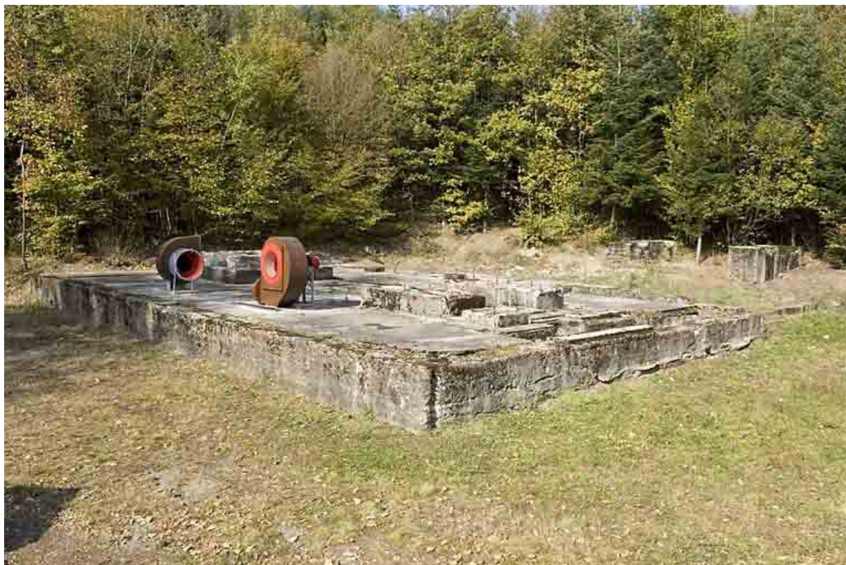
Puits de l'Étançon. Plate-forme de l'ancienne salle du compresseur. 70, Ronchamp, 17 rue de l' Industrie
