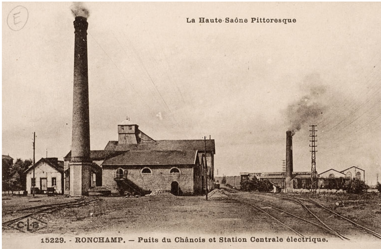
La Haute-Saône pittoresque. Ronchamp - Puits du Chânois et Station Centrale électrique.
