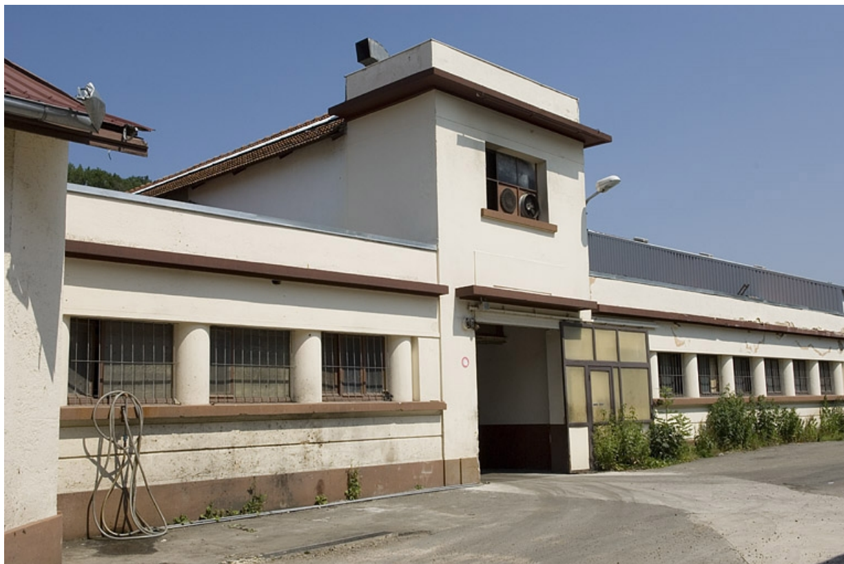
Façade antérieure de l'atelier de fabrication.
