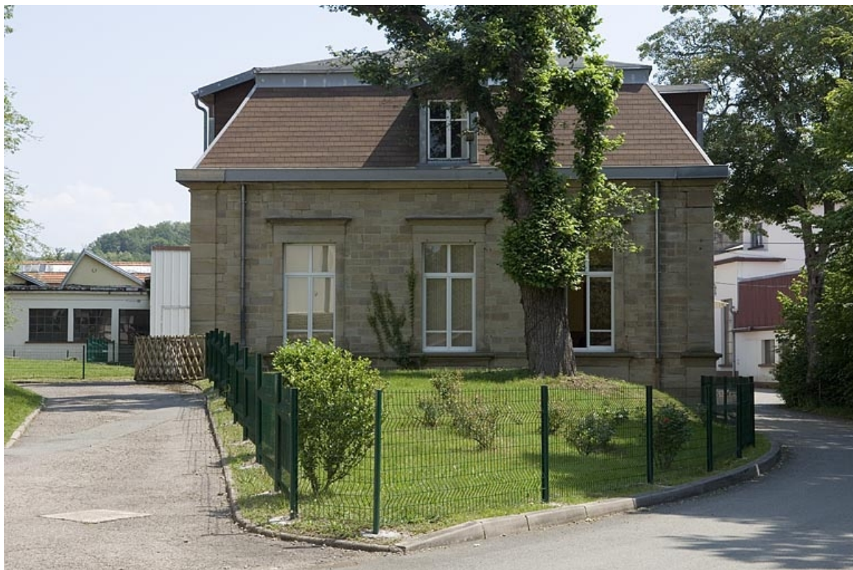
Ancien logement patronal, actuellement bureau.
