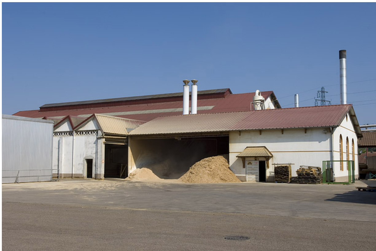
Atelier de réparation et entrepôt industriel vus depuis le sud.
