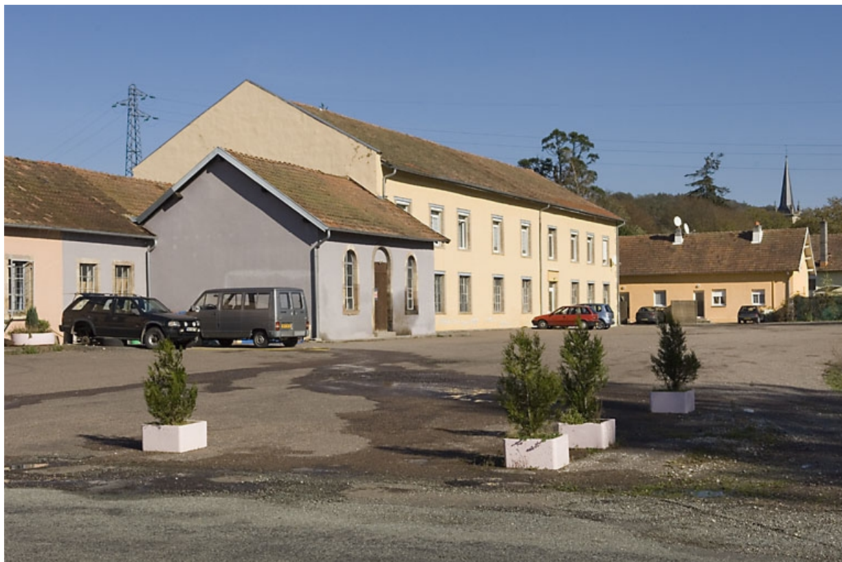
Façades sud. Chaufferie et atelier de fabrication (?).
