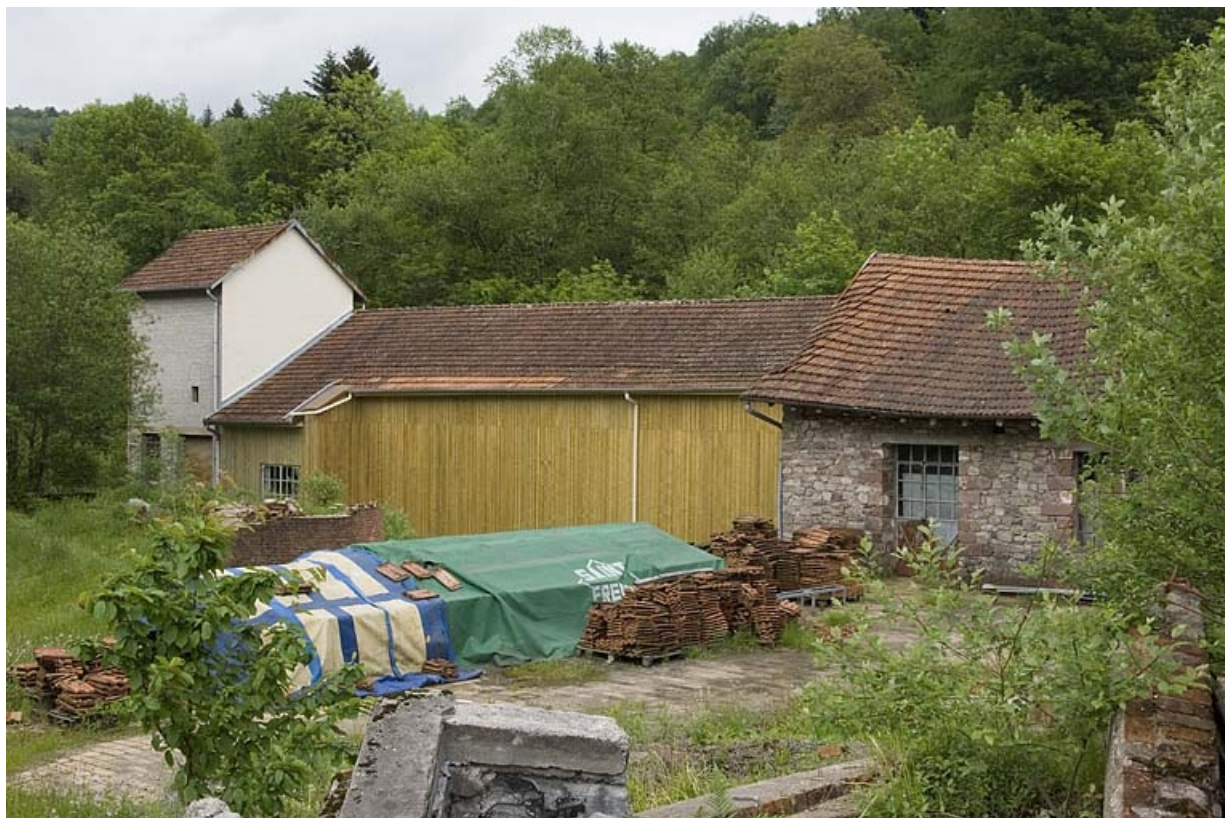
Transformateur, salle des machines, bâtiment d'eau et atelier de réparation. 70, Haut-du-Them-Château-Lambert, 6 rue du Tissage
