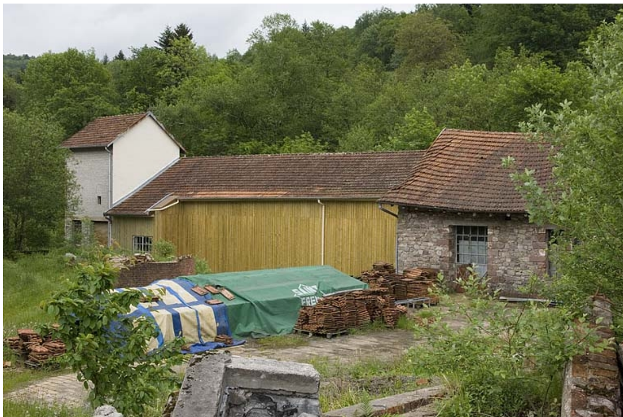
Transformateur, salle des machines, bâtiment d'eau et atelier de réparation. 70, Haut-du-Them-Château-Lambert, 6 rue du Tissage
