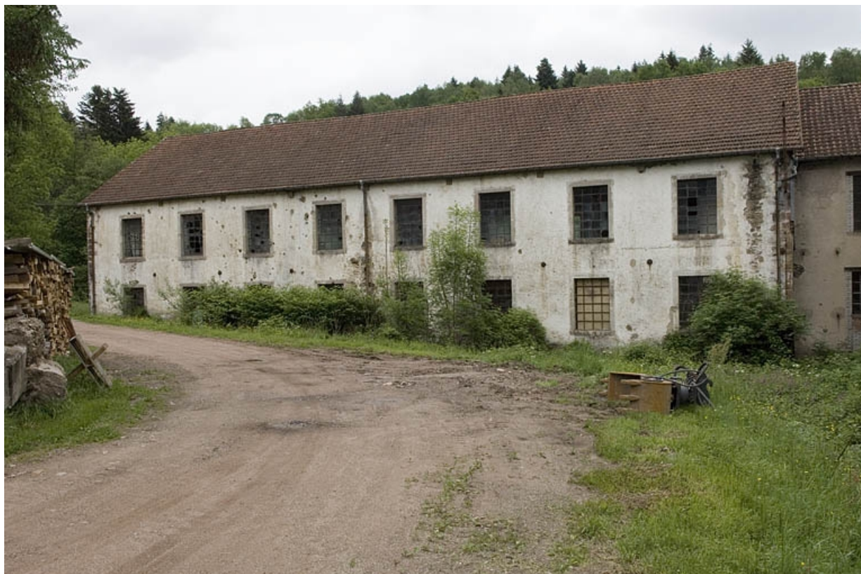
Façade nord-ouest de l'atelier de tissage.
