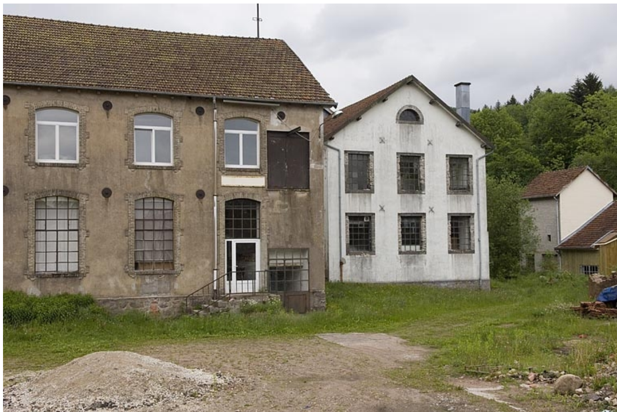
Extrémité sud de la réception et pignon d'un atelier de tissage.
