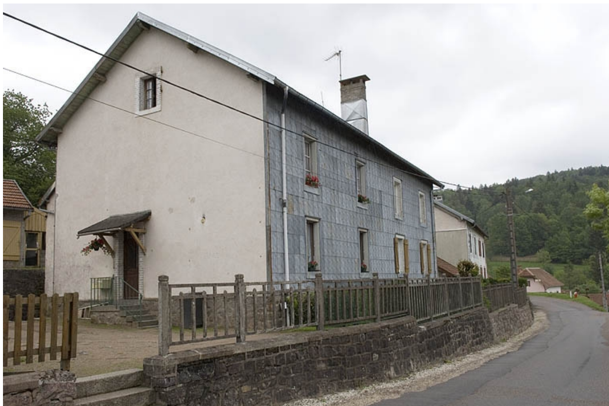
Logements ouvriers collectifs (rue de la Croisette). 70, Haut-du-Them-Château-Lambert, 6 rue du Tissage
