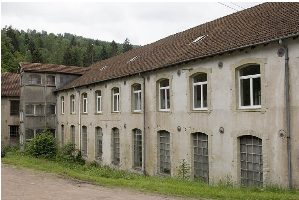
Façade est de la réception et de l'atelier de rentrage. 70, Haut-du-Them-Château-Lambert, 6 rue du Tissage
