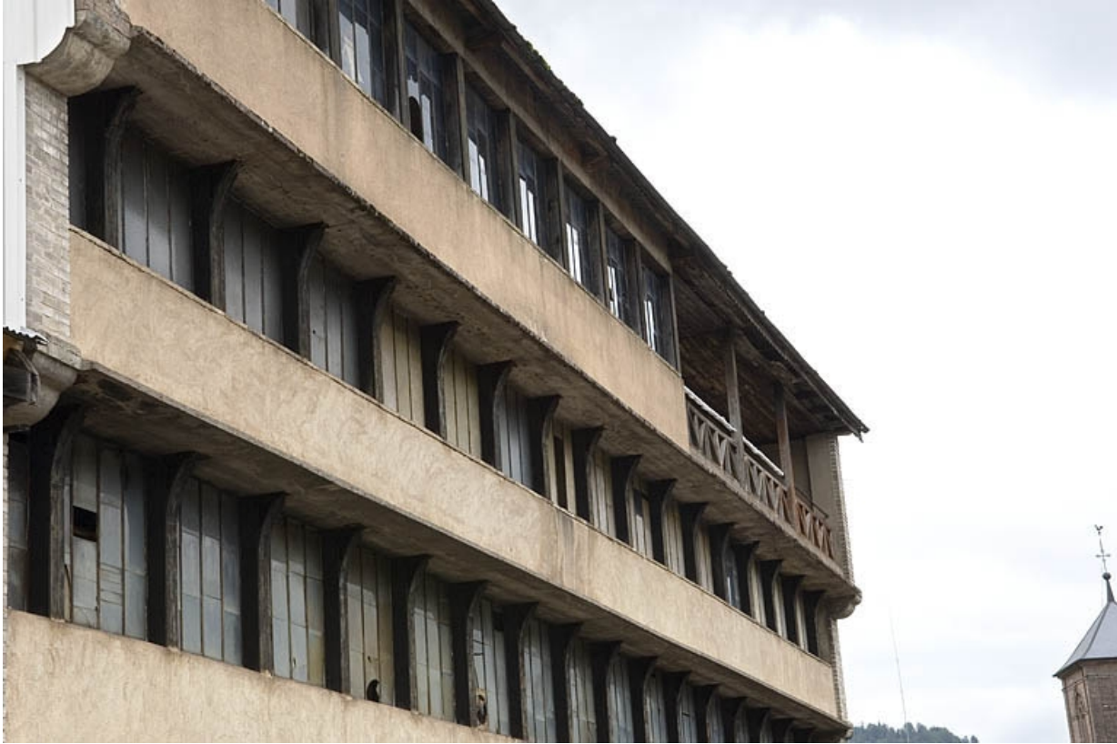
Atelier de fabrication primitif. Détail des encorbellements.
