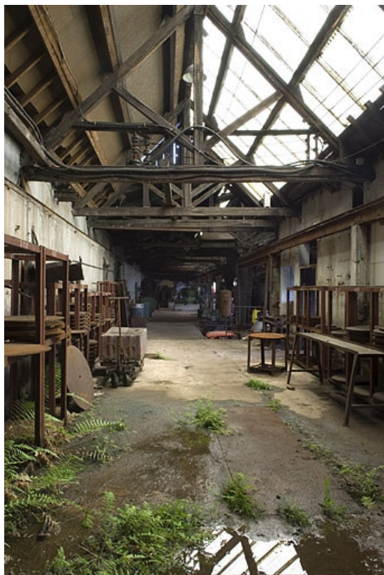
Extension occidentale de l'atelier de fabrication. Vue intérieure.
