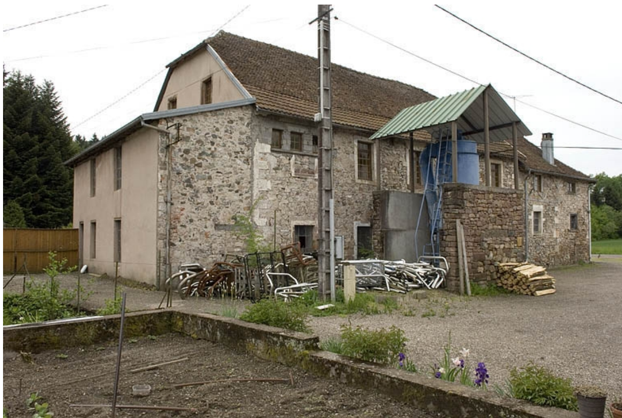
Façade nord de l'atelier de filature.
