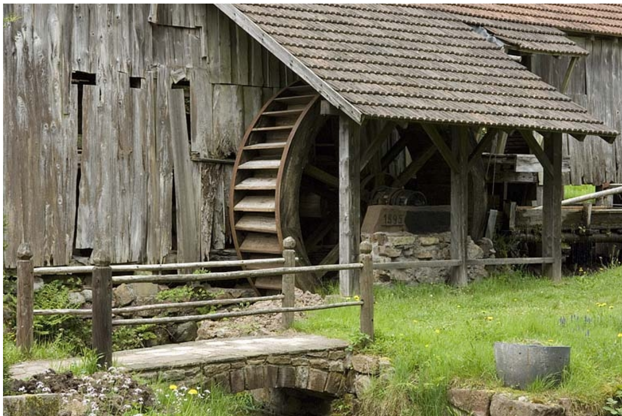
Façade sud. Détail de l'appentis abritant la roue hydraulique.
