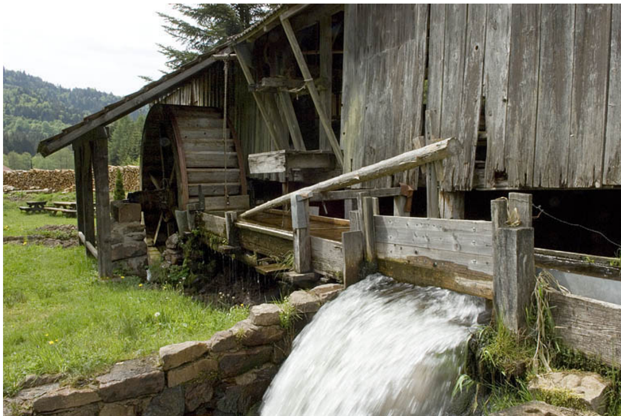
Façade sud. Détail de la huche et du déversoir.
