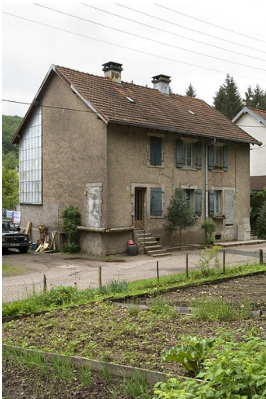
Logement ouvrier double (rue du Barrage).
