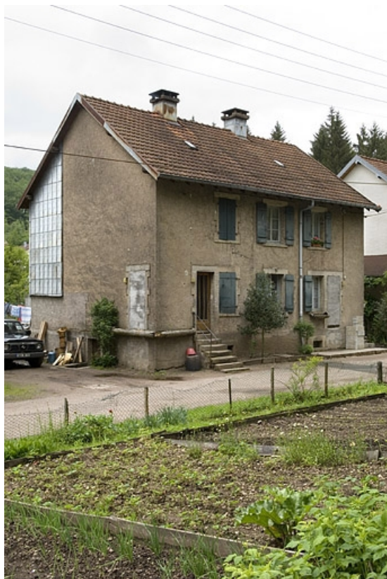
Logement ouvrier double (rue du Barrage).
