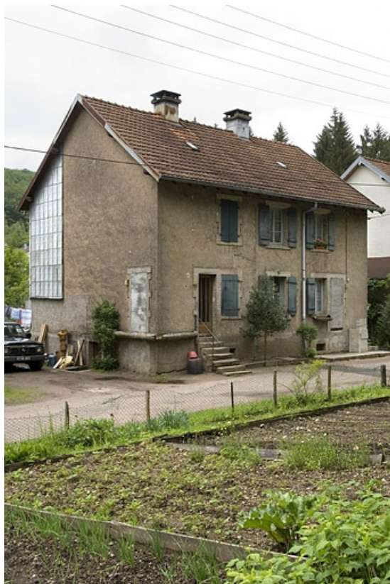
Logement ouvrier double (rue du Barrage).
