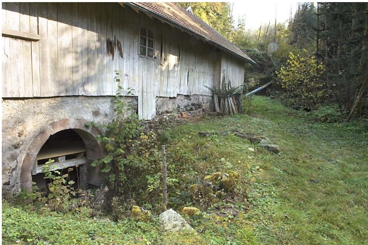
Façade occidentale. A gauche : ouverture en plein-cintre abritant la turbine. 70, Miellin, lieudit : le Miellenot
