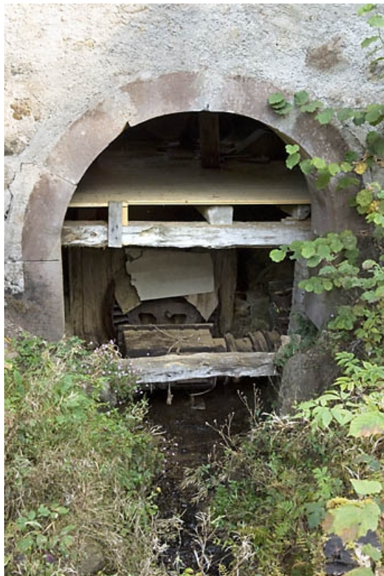
Ouverture cintrée et turbine Wiedeman Frères.
