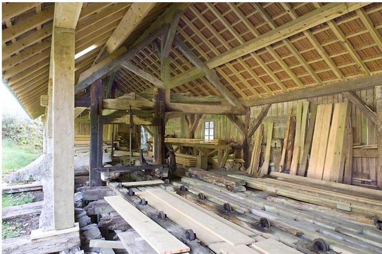
Intérieur de l'atelier de sciage. Chariot et châssis de scie. 70, Miellin, lieudit : le Miellenot
