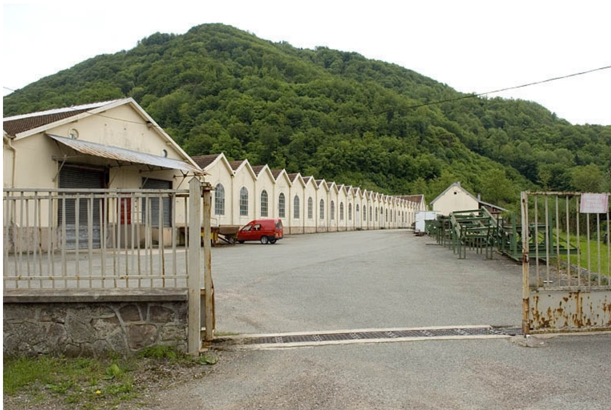
Pignons de l'atelier de fabrication depuis l'entrée.
