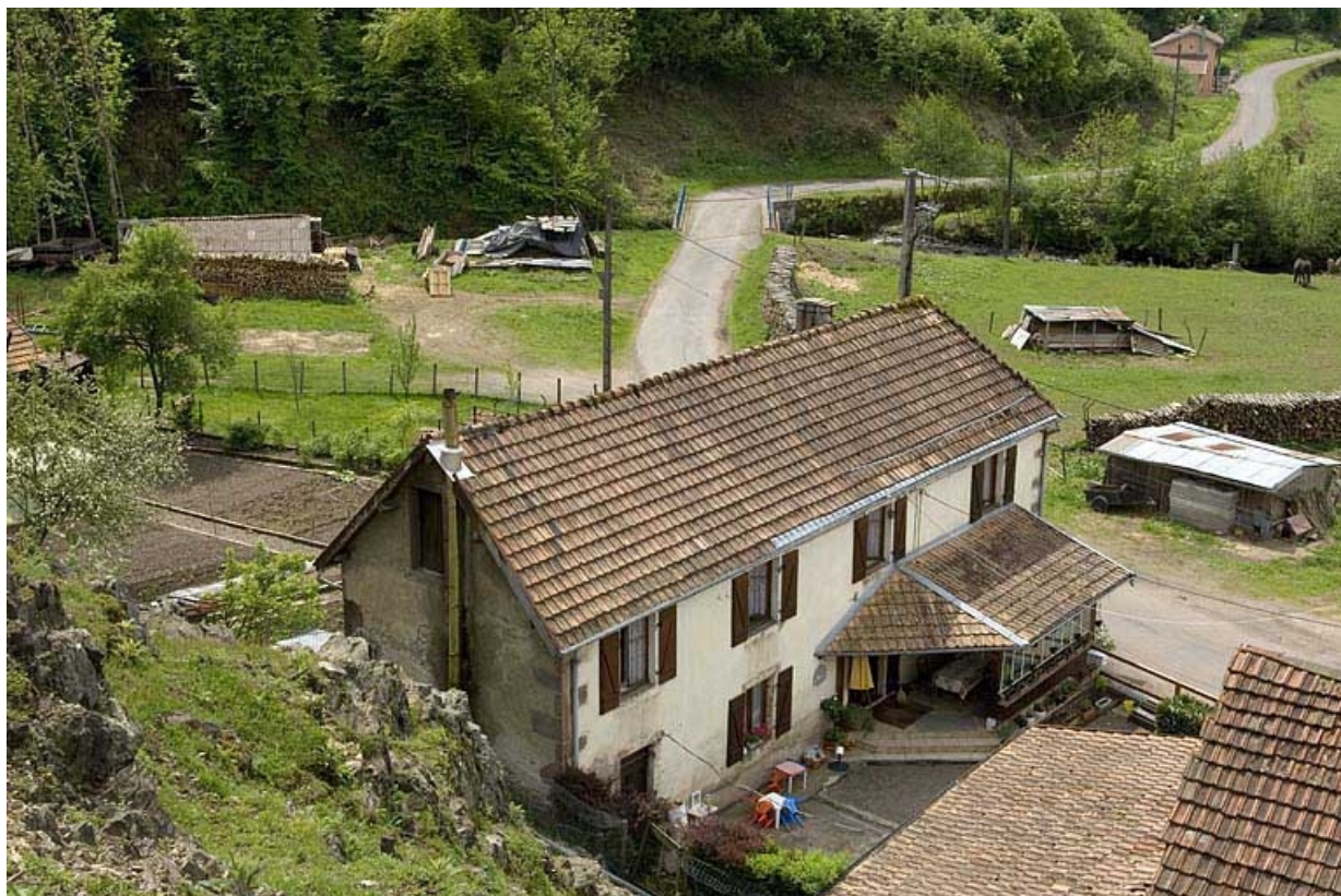
Vue plongeante sur un logement ouvrier.
