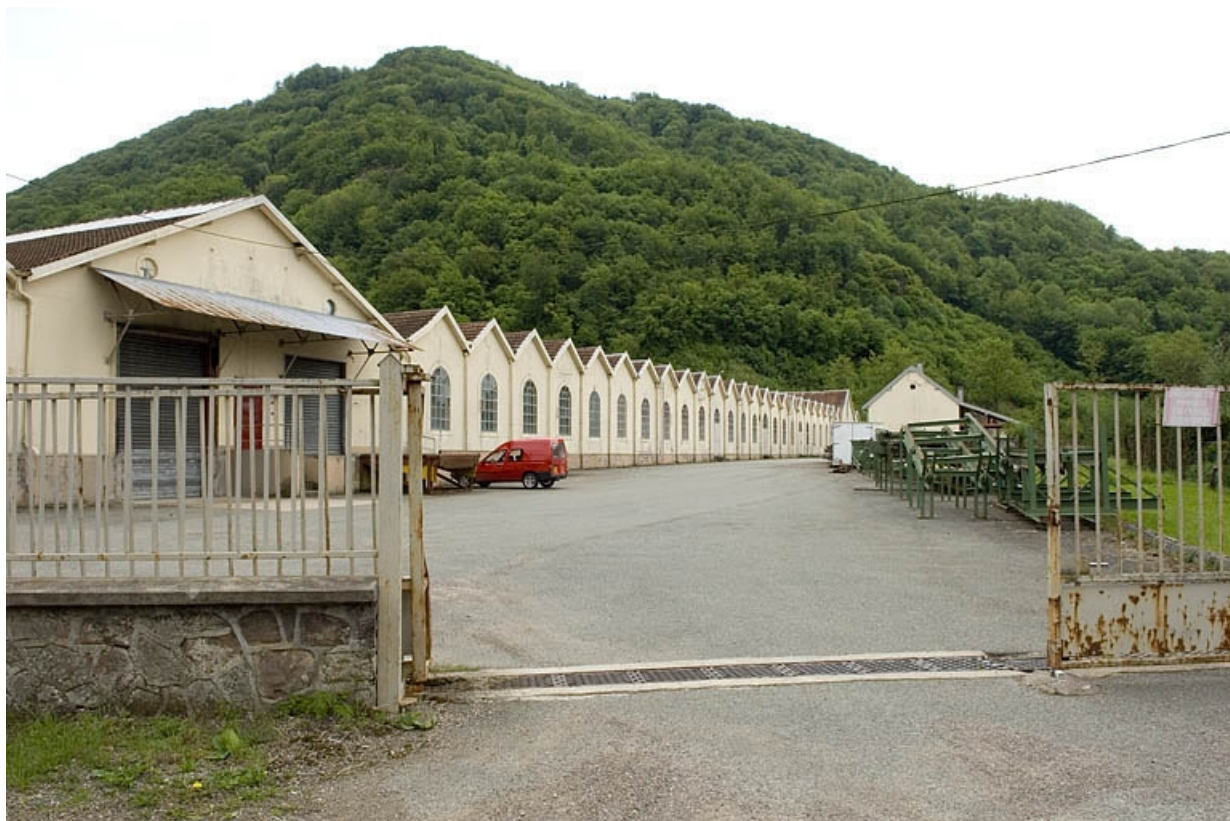
Pignons de l'atelier de fabrication depuis l'entrée.
