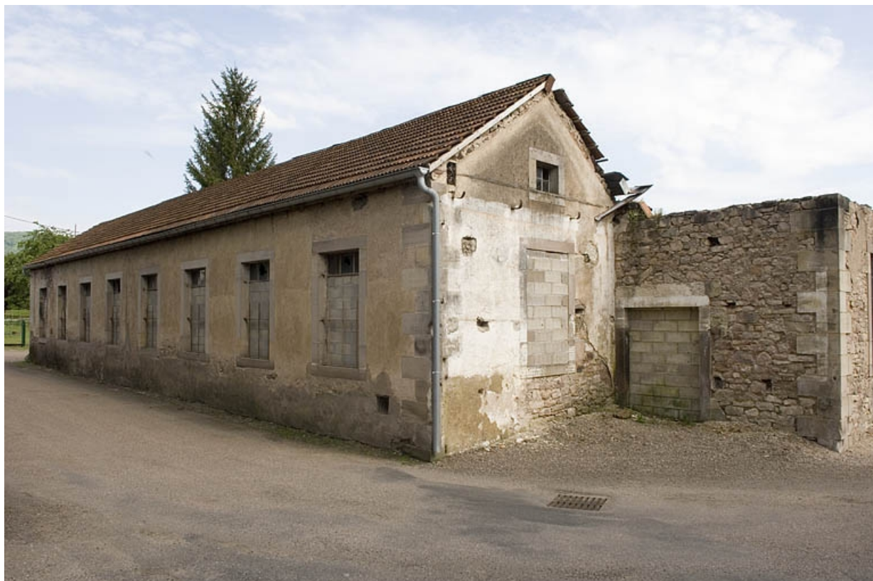
Façade nord de l'atelier de fabrication.
