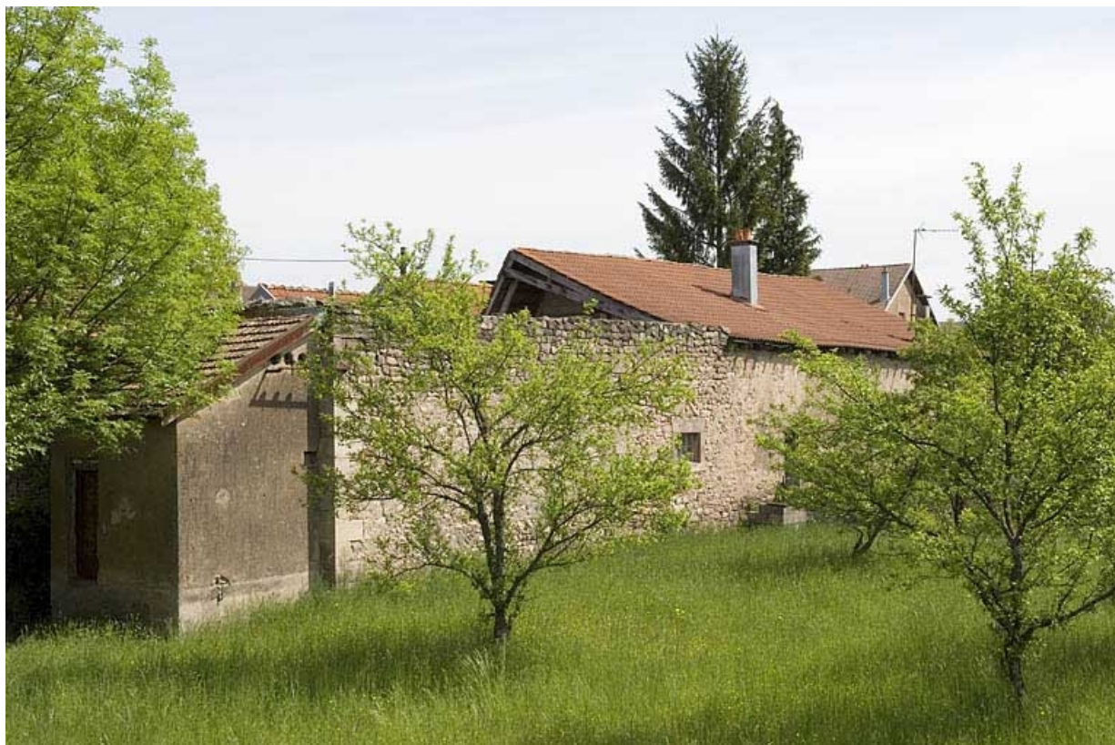
Transformateur et façade sud de l'atelier de fabrication.
