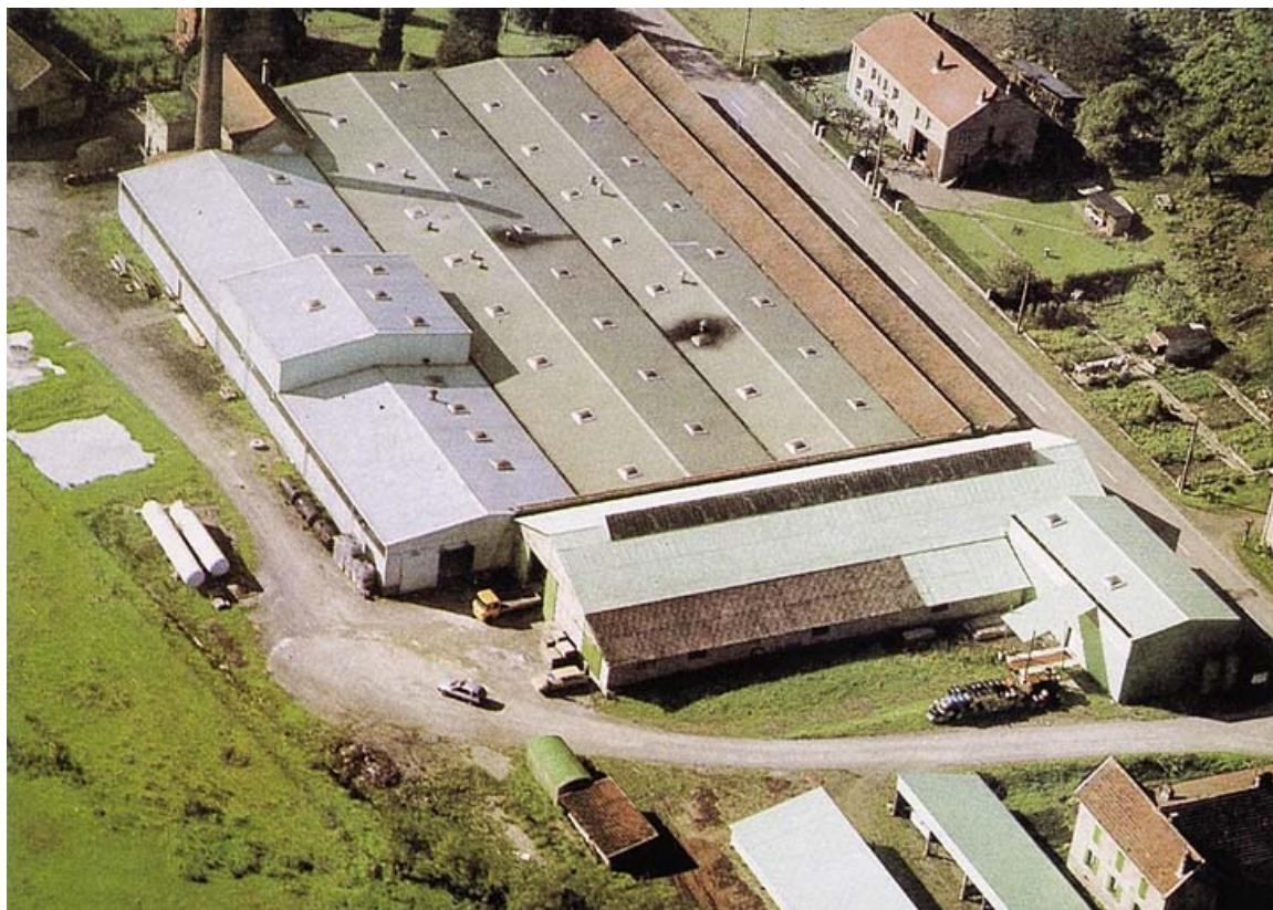
Vue aérienne de l'usine d'Enduction Dreyer Rhénoflex France.
