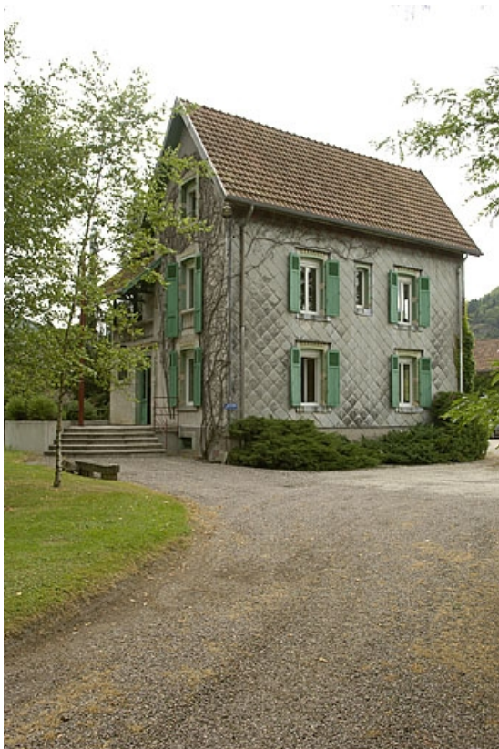
Ancien logement patronal. Vue depuis l'entrée.
