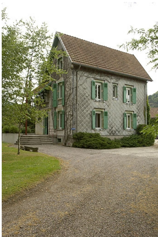
Ancien logement patronal. Vue depuis l'entrée.
