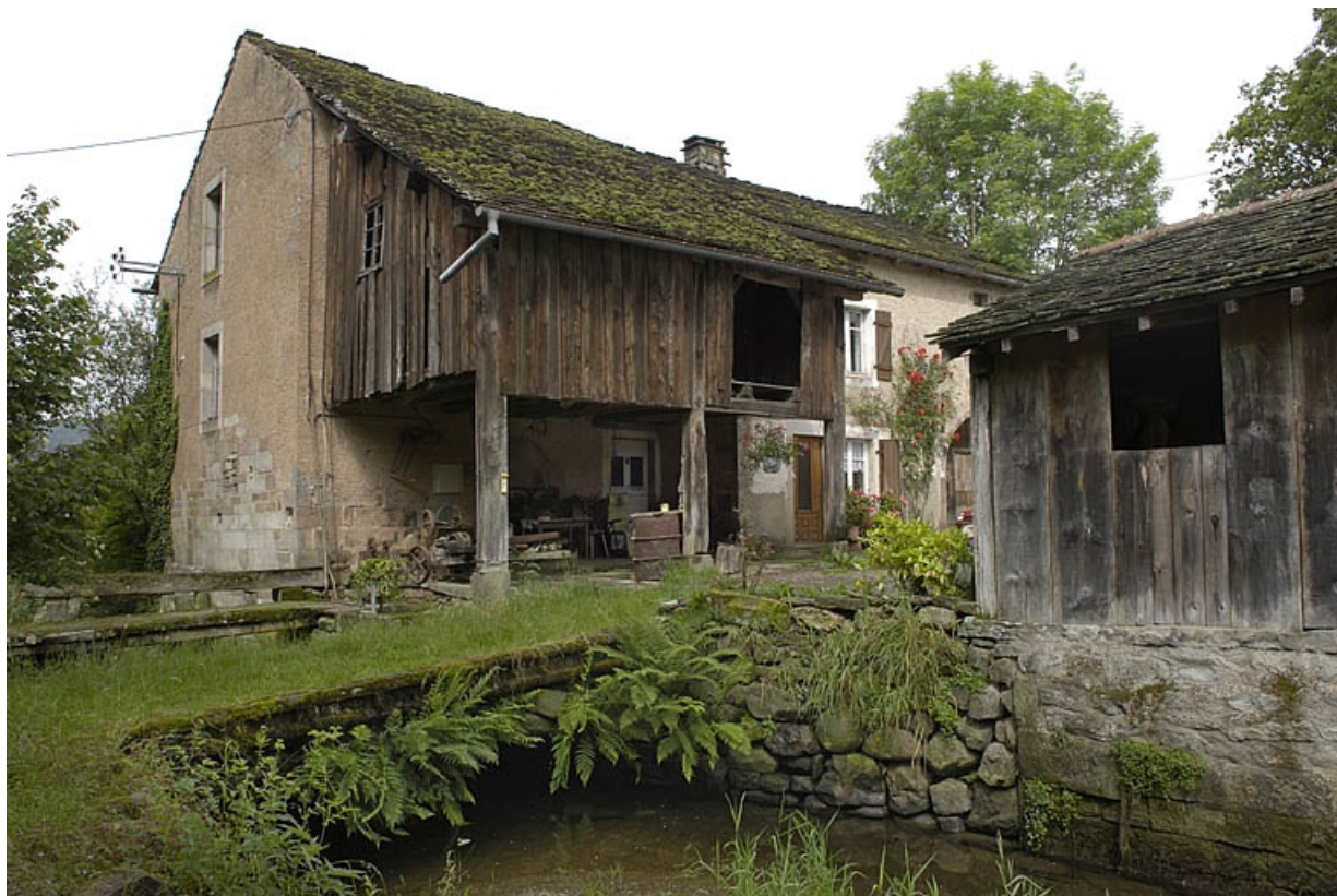
Atelier de saboterie depuis la rive gauche du bief de dérivation.
