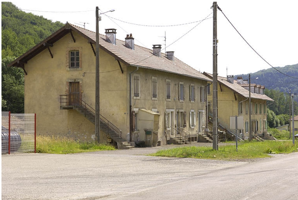
Vue d'ensemble des logements ouvriers. 70, La Longine, 5 à 9 avenue Carlos Dorget
