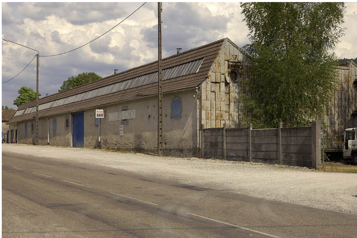
Travées nord de l'atelier de fabrication (tissage).
