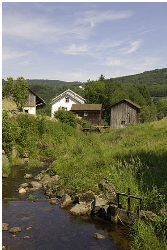
Vue d'ensemble depuis l'amont.
