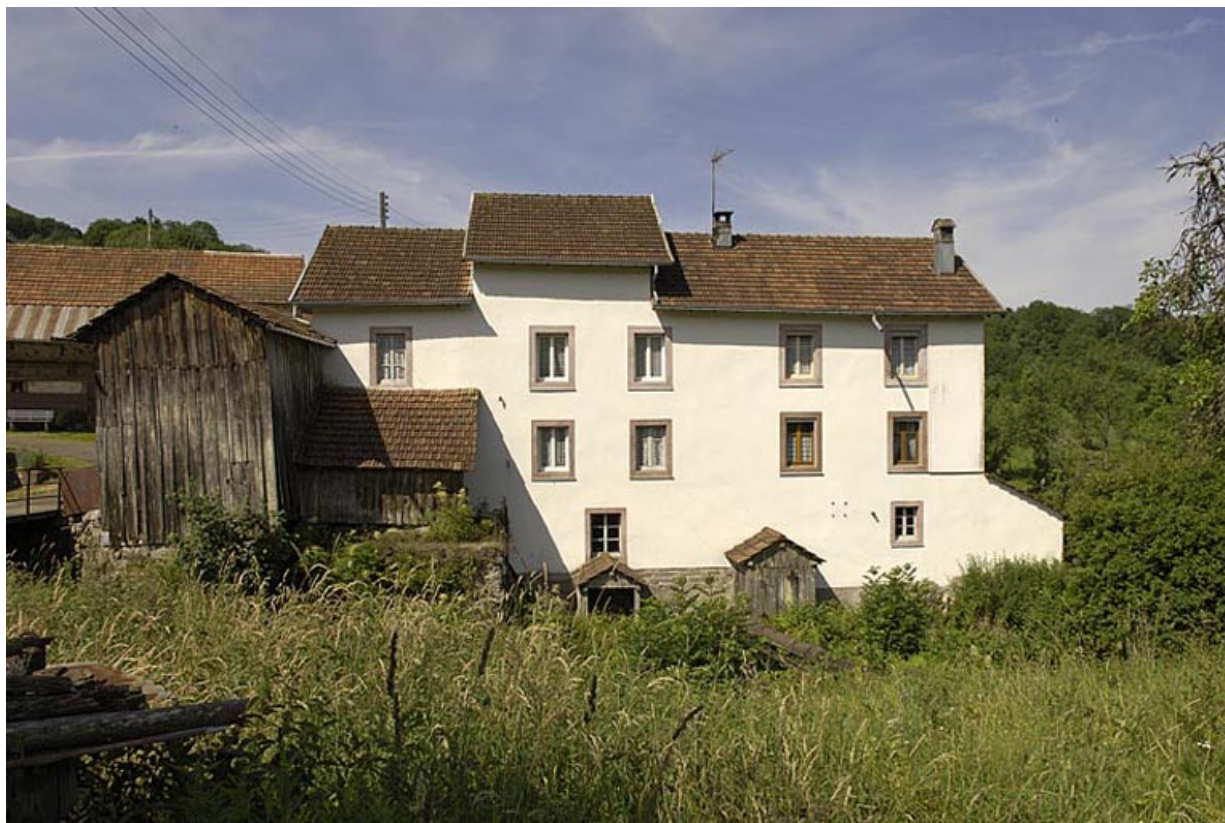
Façade est de la minoterie.
